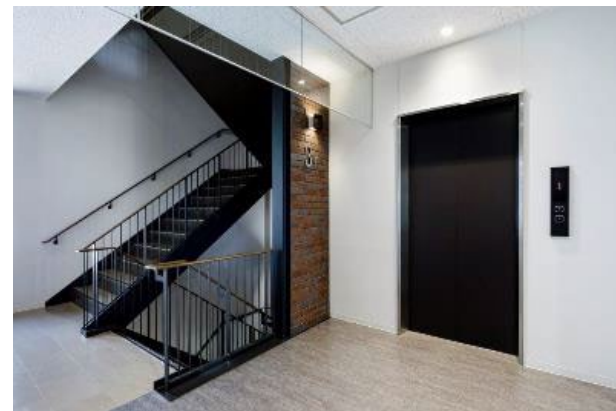
▲防火戸のない階段室
