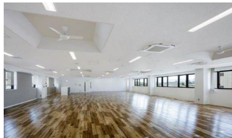
▲3階事務室：シーリングファン
