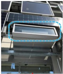
薄型水平光ダクト 採光部（プリズム）
