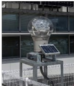
太陽光採光システム 採光部
