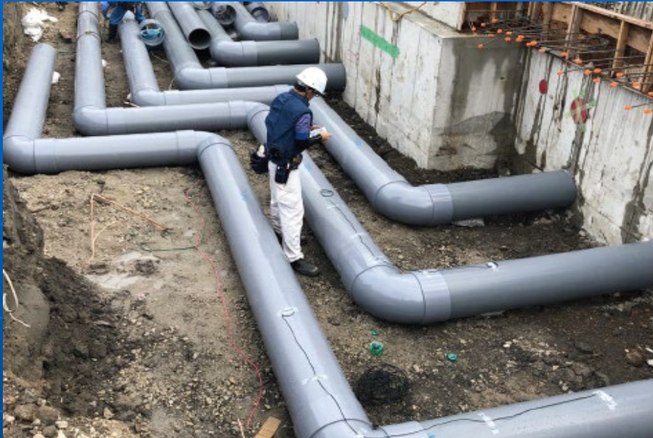
アースチューブ敷設状況
