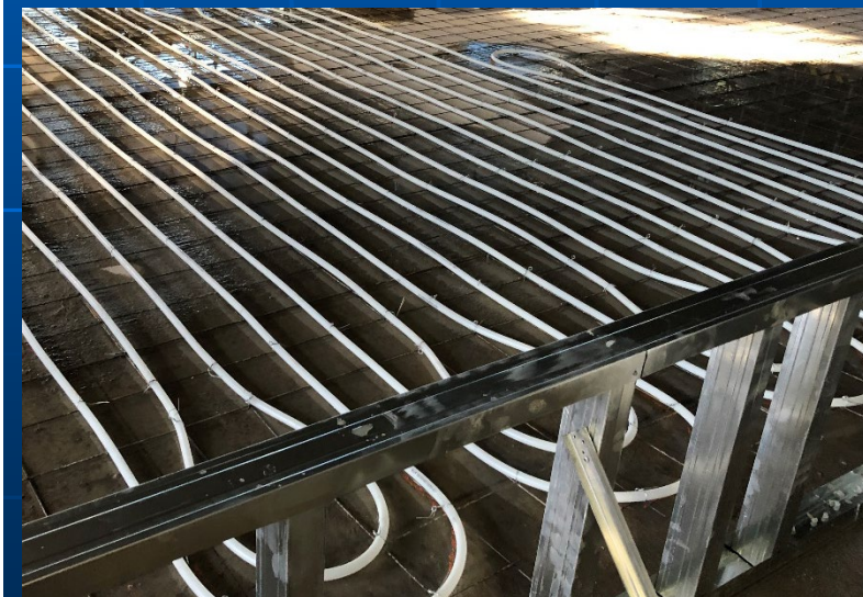
TABS配管施工状況
