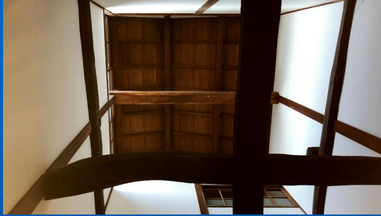
町家にみられる天窓
