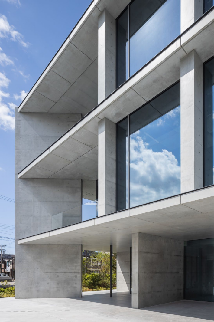
軒庇と壁柱で日射遮蔽しクライマー式ブラインドで視界確保
