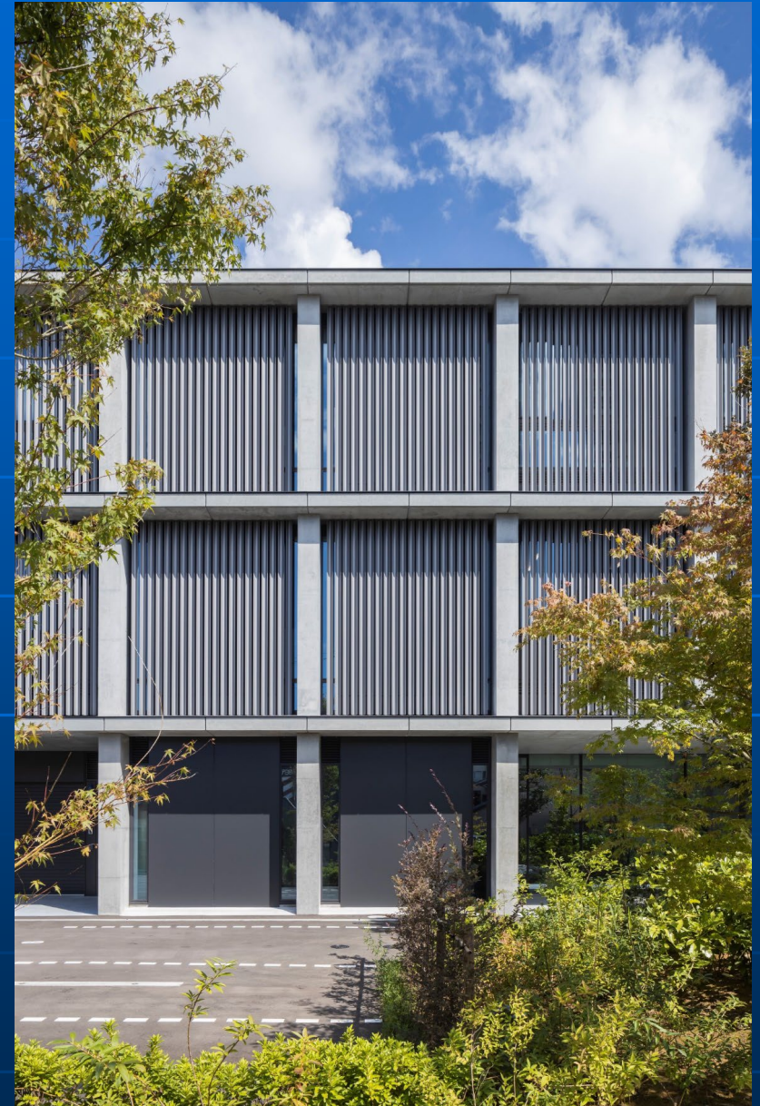
木虫籠ルーバー（室外より）・西面
