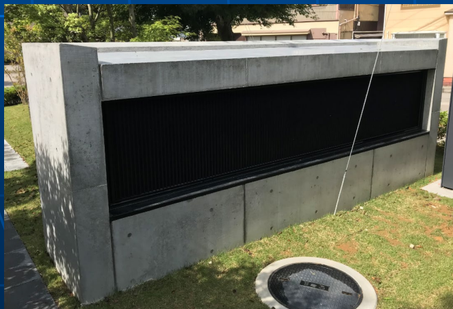
建物から離れた位置にある給気塔
