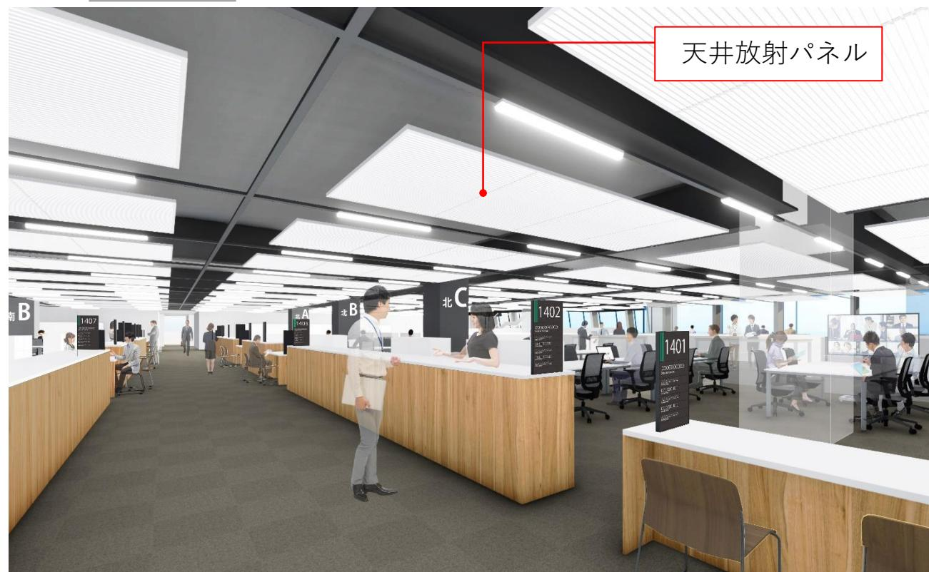
執務室フロアは、空気搬送に比べて熱搬送効率が高い水搬送方式により、搬送動力を削減する「省エネ性」と、気流感や温度ムラが少なく静寂性の高い「快適性」を両立した「天井放射空調」を採用。
