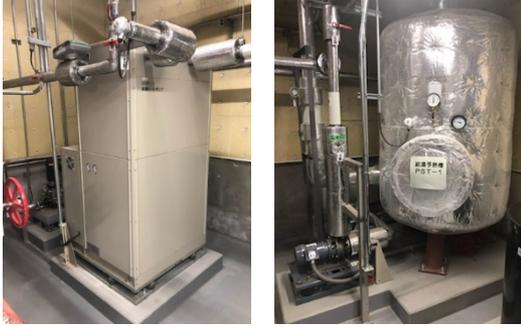
写真：下水熱利用HP・予熱槽
