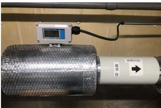
写真：流量計（廃熱回収）
