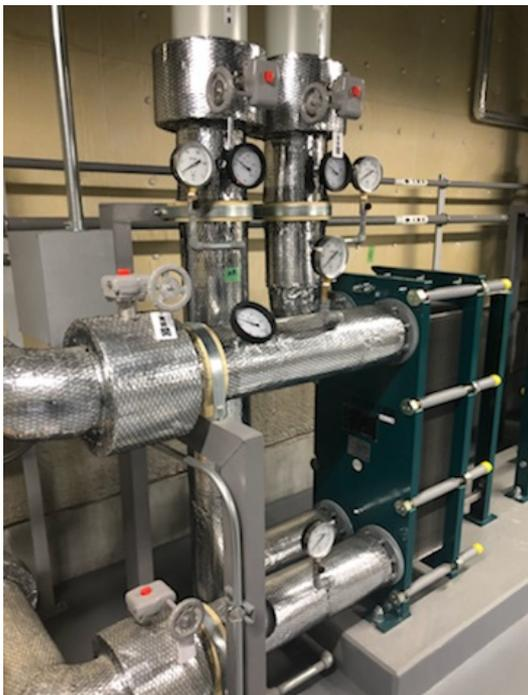
写真：排熱回収用熱交換器
