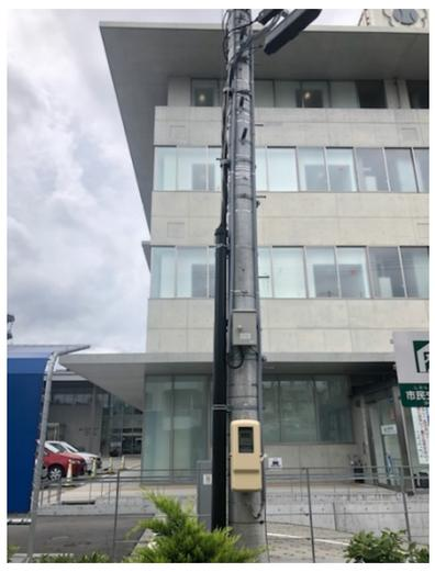
写真：高圧分岐盤
