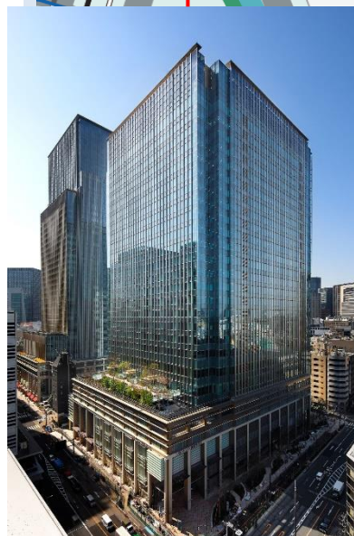
日本橋室町三井タワー
