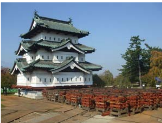
曳屋完了後の天守
