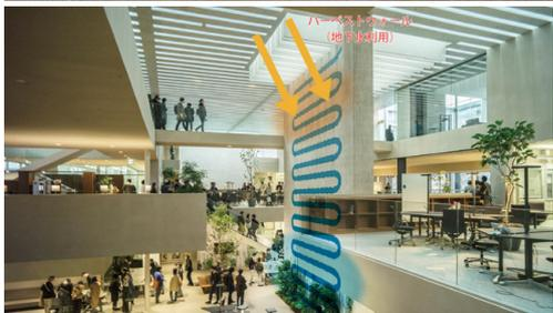
天井ルーバーや壁体の内部に井水を循環させ、天井から差し込む自然光の熱成分を除去することで、光のみを室内に最大限取り入れる
