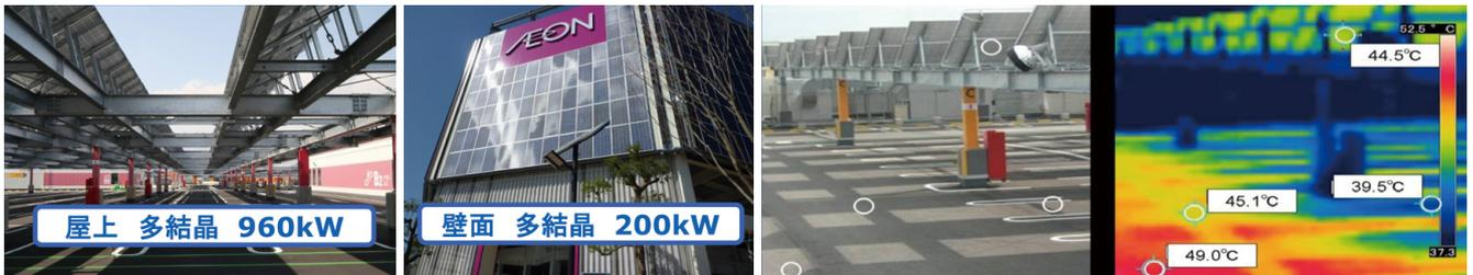
壁面と屋上に国内商業施設最大級計7,956㎡のソーラーパネルを設置。屋上では駐車場の遮熱効果も大きい。
