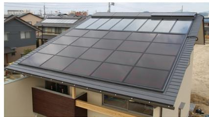
空気集熱式ソーラーシステム (OMソーラー)、太陽光発電システム、太陽光利用給湯器により、年間6.08t/年のCO<sub>2</sub>削減 (住宅事業建築主基準)。
