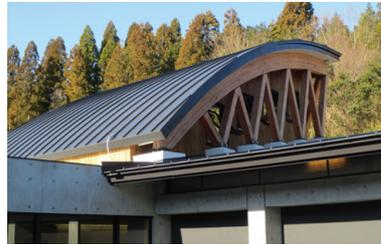
登り窯のように空気が連続的に上の階を通り、風の塔の換気窓から熱を逃がし、校舎全体の自然換気を促す
