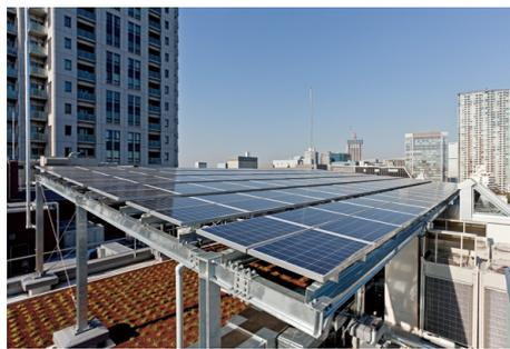
夏期はダブルスキン内の電動ブラインドにより日射の負荷低減。冬期はダブルスキン内の暖気を室内に導入し、空調負荷を低減。また、壁面には室内からの眺望が確保可能な透過型太陽光発電パネル、屋上には大型の太陽光パネルを設置。
