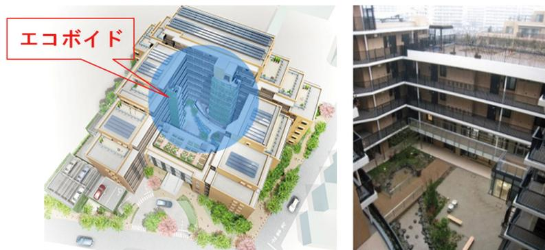
ヒートポンプ式給湯器の室外機を中庭に面して配置し、その冷排熱を中庭(エコポイド)に貯め、建物内外への風の通り道を確保することで夏期の温度上昇を緩和
