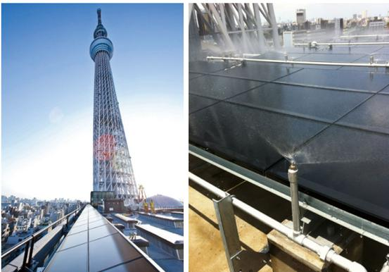
屋上(8階)に設置した太陽光パネル(左)とパネルに雨水を自動制御で散水する様子(右)
