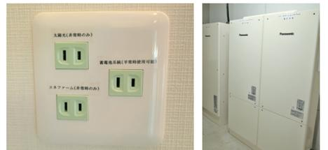
屋根全面に設置される太陽光発電は、専用部の個別供給用と共用部に割り振られている専用部住戸内には、蓄電池、燃料電池と連携した停電時自立運転用コンセントも設置
