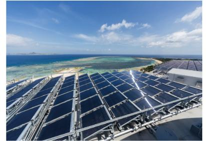
デシカント外調機により、効率よく除湿し井水で冷却。デシカントの再生には太陽熱を用いる。
