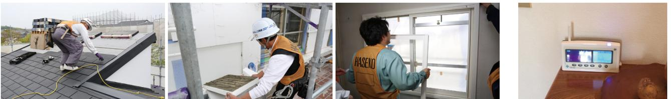
屋根、外壁の外断熱の改修工事および二重窓の取り付け工事の様子
