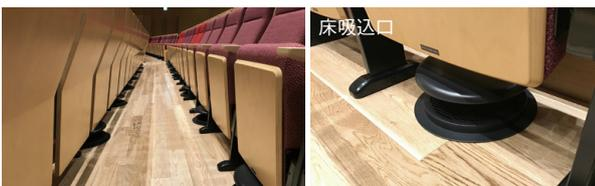
壁面吹出・床吸込により空気搬送エネルギーと再熱負荷を低減
