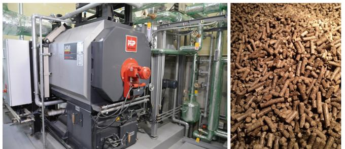
地元産ペレットを使用したボイラーを設置し、給湯装置として利用
