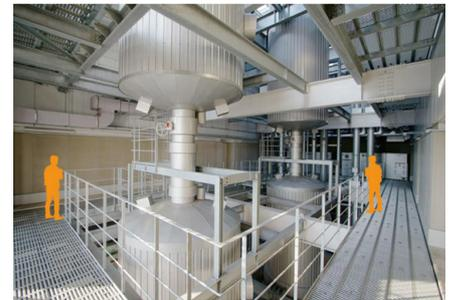
吹き抜け空間に設置された縦型蓄熱槽(連結部)。縦型蓄熱槽をバッファタンクとすることで、冷凍機の高効率運転を実現。分散ポンプと組み合わせることでさらに高効率なシステムとなる。
