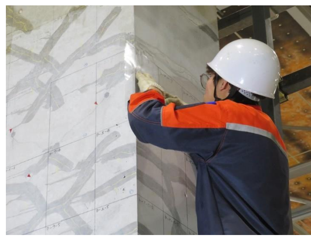
梁・耐力壁の損傷度と修復法の整理(鉄筋コンクリート造)
