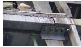
a) 鋼製下地と層間ふさぎ材
