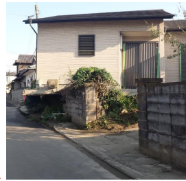
図. 浮上しずれた家屋 (令和2年7月豪雨)
