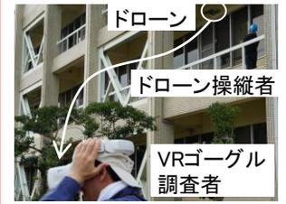
VRゴーグルを使用した構造躯体のひび割れ状況の確認
