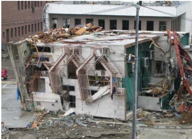
外装材がほとんど残存したため、大きな波力と浮力が作用したものと推測される
