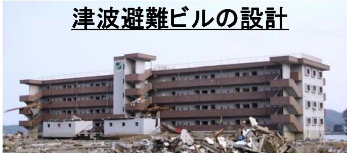
10mを超える浸水深では、設計で考える地震の力よりも、津波の力の方が大きくなることもある
