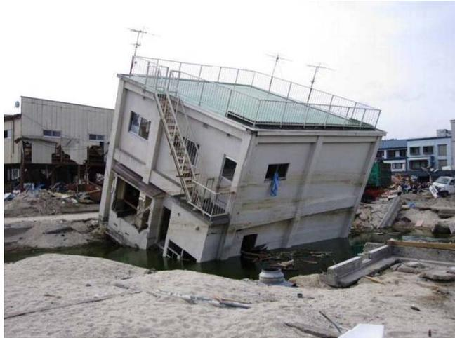
洗堀により直接基礎の建築物が傾斜した例
