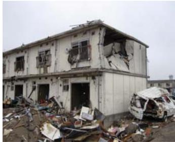
外部に面する柱等が漂流物により破壊しても、その軸力支持能力を喪失しない(大梁等を介して伝達できる)
