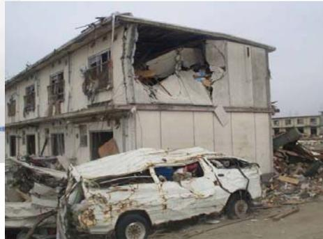
構造耐力上主要な部分である耐力壁の破壊
