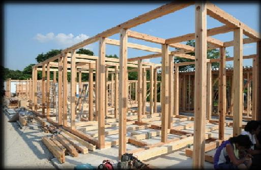
**在来軸組工法**：一般の小規模工務店や大工が誰でも可能な工法を採用。構造材は入手が容易な120mm角の杉材。**メッシュ筋入りコンクリートべた基礎**：松杭は機械が無いと手間がかかる、コンクリートも再生骨材として再利用可能なことからコンクリート基礎を採用。この結果玄関土間を室内に確保。
