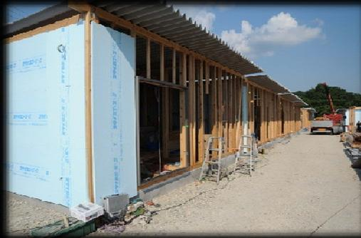
**外張り断熱外壁通気工法**：スタイロフォーム(厚30mm)を張り、防水透湿シートで気密性を確保。外部建具はペアガラスの樹脂サッシ。屋根は折半で天井断熱、小屋裏換気をとる。**内外装はすべて杉板張り**：地域の地場産材を生かし、自然素材による被災者への癒やしの効果を期待。
