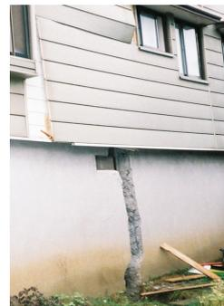
写真-33 高床基礎の被害
