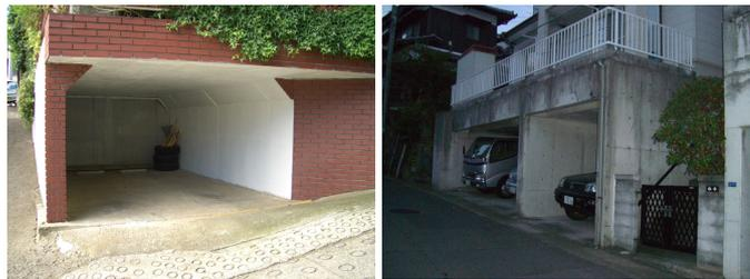
写真-12 擁壁に頼らない斜面地の地下構造の例
