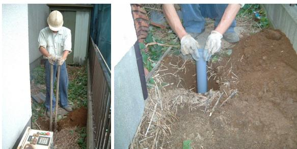
写真-27 容易に実施できる浅層部の地下水位観測
