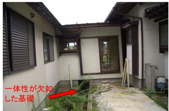
写真-34 新旧の増築の接合部における液状化被害
