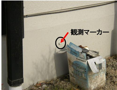
写真-35 基礎完成後に設置した沈下観測マーカー
