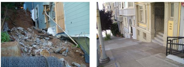
写真-16 海外の基礎構造(基礎壁や階段状基礎)
