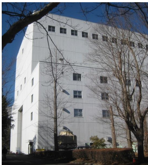
実大構造物実験棟の外観
