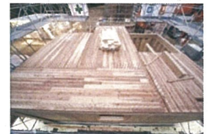
2階CLT床(工事中)
