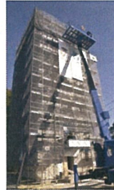
実験棟(工事中)
