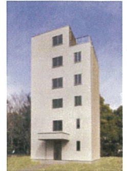
ツーバイフォー6階建て実験棟
