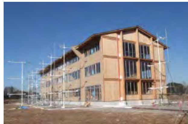
軸組、木造3階建て学校
