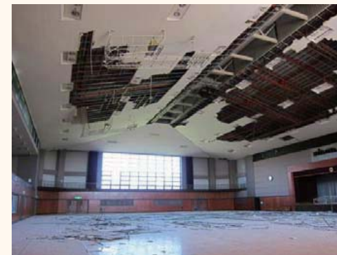
山形架構の屋根面に平行な天井
