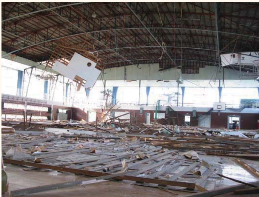
写真5.3-5 天井(木下地)、照明の落下
