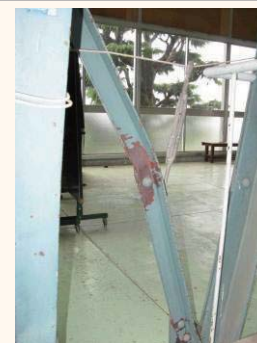
写真5.3-3 ラチス柱斜材の座屈
