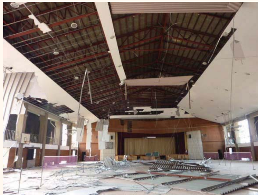
写真5.3-6 天井(在来工法)の落下
