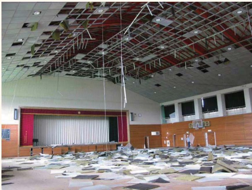
写真5.3-13 天井(システム)の落下
