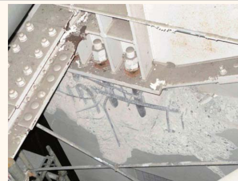
写真5.3-10 妻壁とS造屋根接続部のコンクリート破壊等
