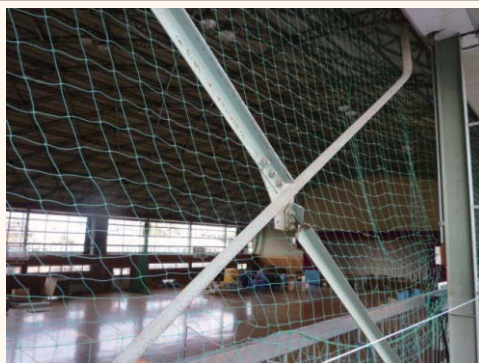
写真5.3-1 ブレース材の座屈と接合部破断
