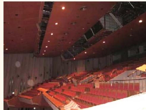
段差部・折り曲がり部
