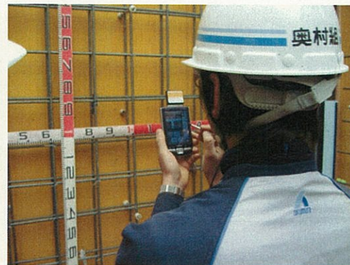
図5 PDAに表示された検査支援情報 に従って検査結果を入力する。 また、PDAを用いて検査写真 を撮影する。
