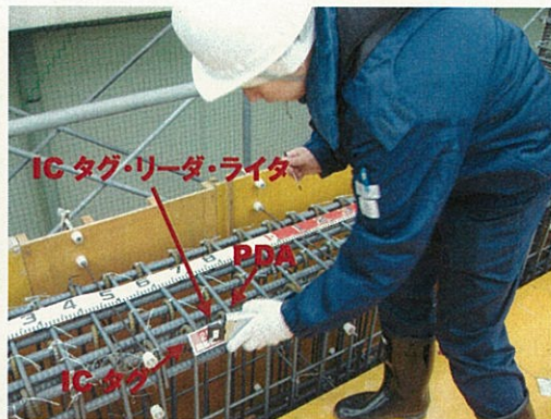
図3 PDAを用いて、施工現場の所定の 場所に設置したICタグを読み、 検査行為の認証を行う。
