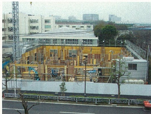
図2 システムの検証を行っている 施工現場 （注）日本空手道会館の建設工事現場 （株式会社奥村組施工）
