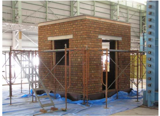
建設中の試験体
