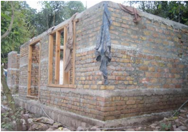
パキスタン北部で建てられているレンガ造住宅
