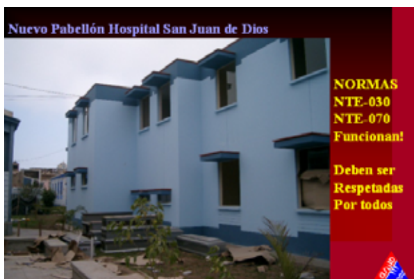
病院(Nuevo Pabellón Hospital San Juan de Dios) 新しい建物であり、無被害であった。 (以上)
