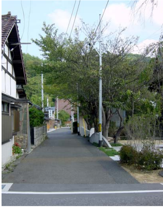
写真 4 福島県会津本郷町町道
