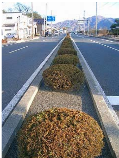
写真 8 国道 45 号線防草舗装（左が施工当初、右が 1 年経過後：雑草はほとんど生えないが、中央分離帯の植栽は透水性舗装のため枯れていない。）
