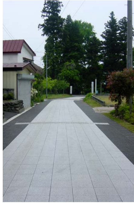
写真 5 福島県会津坂下町町道 (石畳みの透水性舗装)
