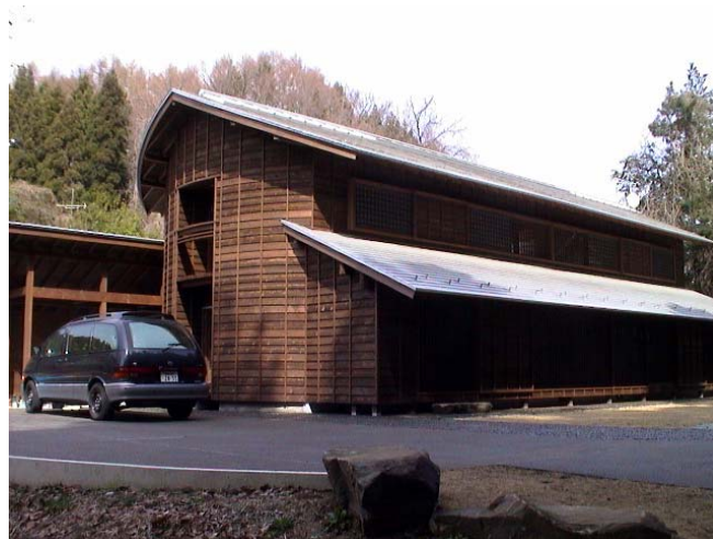
写真 7 I 邸駐車場と玉石舗装 (施工後 8 年経過)
