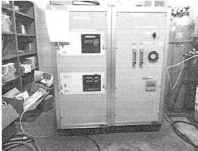
防耐火実験棟 (No.4)
