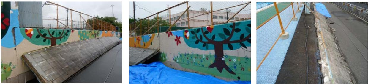
写真-I-1. 2. 2 倒壊した補強コンクリート造ブロック塀の状況
