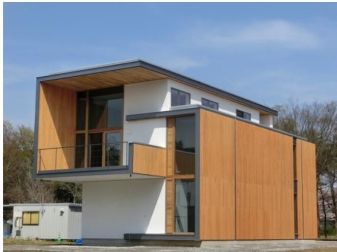
写真-I-1. 2. 12 CLT 実験棟
