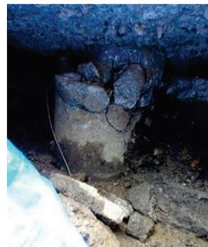
写真 1.4 既製コンクリート杭の被害
