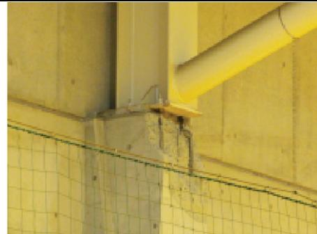
写真 1.2 鉄骨置き屋根体育館の被害
