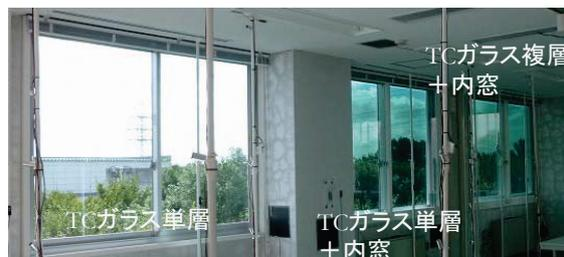
写真 1 サーモクロミックガラスの色変化
