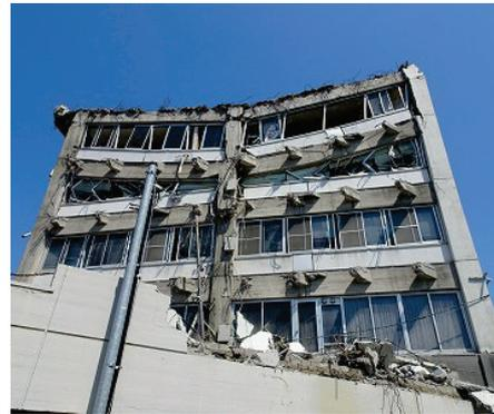
写真 1.3 RC 造庁舎の被害
