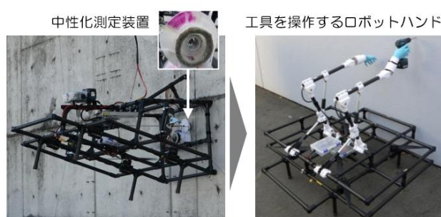
写真1 中性化測定装置搭載ドローンによる外壁調査状況、及び未来のソフトハンド搭載ドローン
