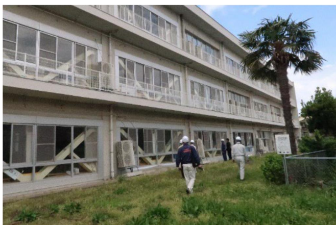
▲現地調査の様子
