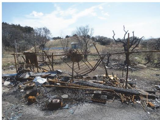
図 8.7.15 簡易な構造物の被害 (地点⑭)
