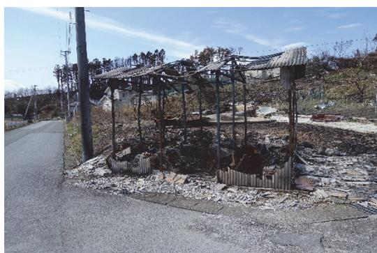
図 8.8.8 簡易な構造物の焼損痕（外口地区）
