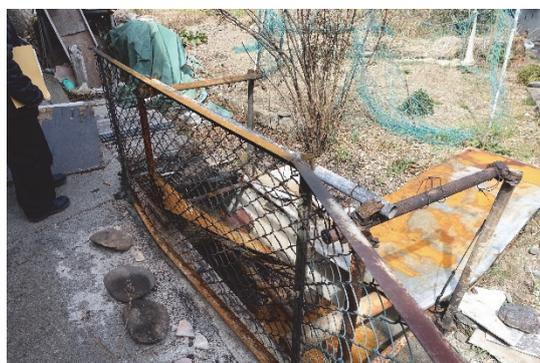
図 8.7.21 住宅が比較的密集した地域の物置の焼損跡（地点⑳）
