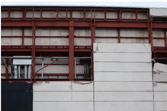
写真 WA-15.3 外壁のECPの損傷・脱落
