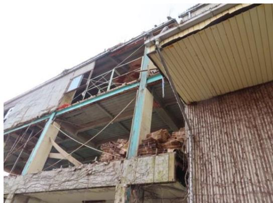
写真 SU-01.6 ターンバックルブレースのたわみ
