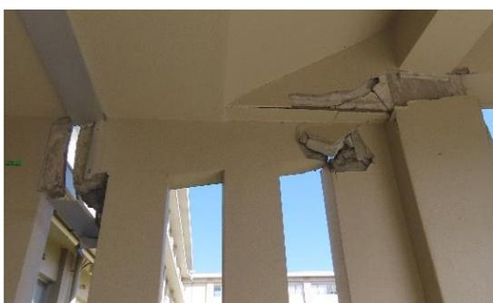
写真 SU-101.3 校舎渡り廊下の壁の破損
