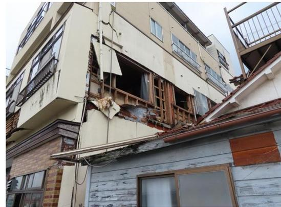
写真 WA-07.4 建築物の側面の外壁の脱落
