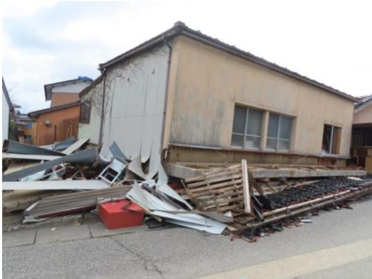
写真 NA-01.1 1階の層崩壊
