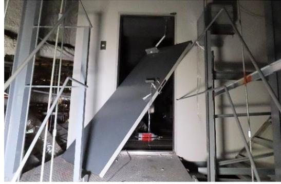
写真 AN-103.7 調光室の扉の被害
