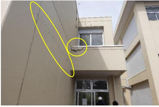
写真 AN-102.13 校舎外壁の被害
