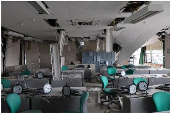
写真 AN-101.13 校舎 天井板の脱落等
