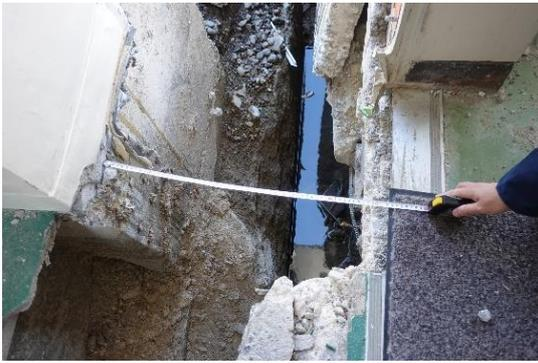
写真 SU-101.13 第一体育館と第二体育館の通路の損傷による約 60cm の隙間
