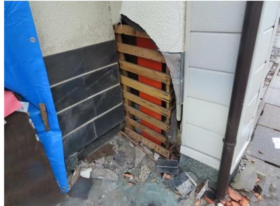
写真 WA-11.2 外壁の一部脱落
