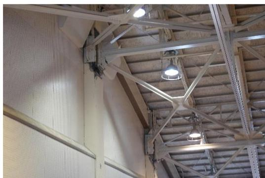
写真 AN-102.4 屋内運動場 妻面（入り口側）のRC造柱とトラス屋根の梁の接続部の損傷
