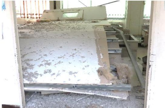
写真 WA-111.18 校舎 3階内壁の被害
