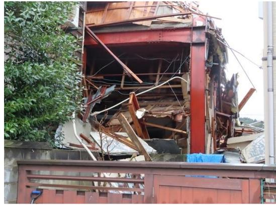
写真 WA-01.4 1階は倒壊していない
