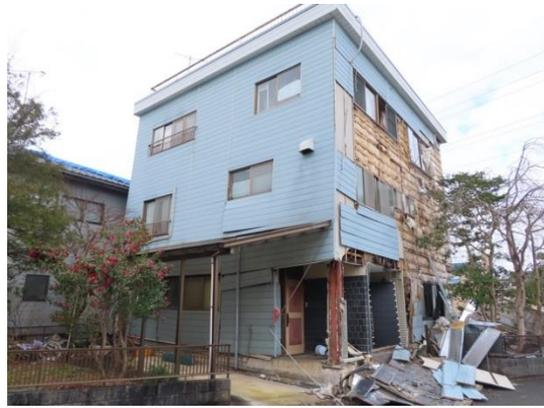
写真 AN-04.2 外壁の脱落(裏側)
