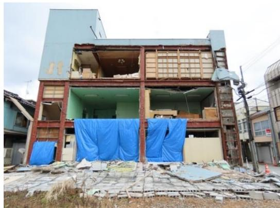
写真 NA-04.2 外壁（ALCパネル、コンクリートブロック壁）の広範囲での脱落・転倒
