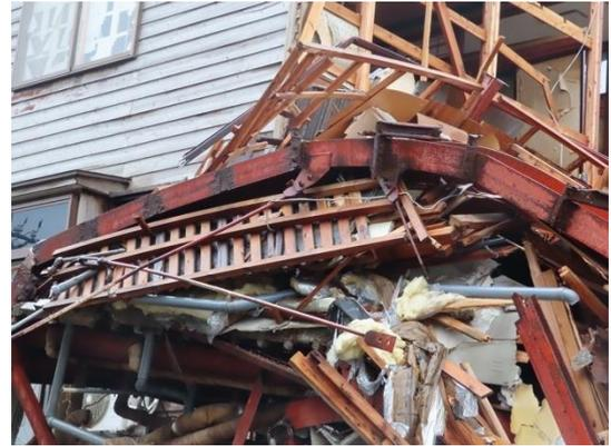
写真 WA-01.6 2階のターンバックル
