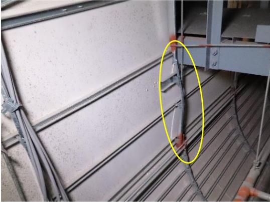
写真 AN-103.8 天井下地の変形
