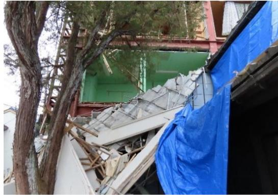
写真 NA-04.6 外壁（コンクリートブロック壁）の脱落
