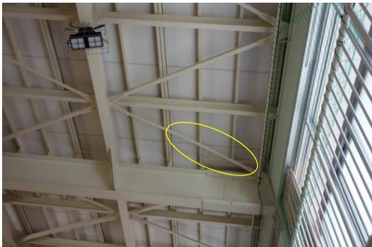
写真 NA-103.3 屋内運動場 水平ブレースのたわみ
