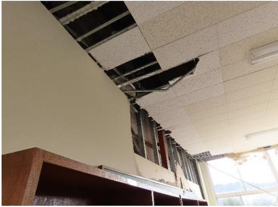
写真 WA-111.13 校舎 3階内壁と天井の被害
