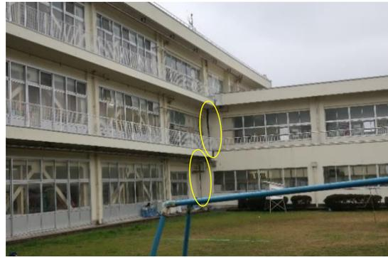
写真 WA-105.6 校舎棟間の Exp.J の損傷 (外観)
