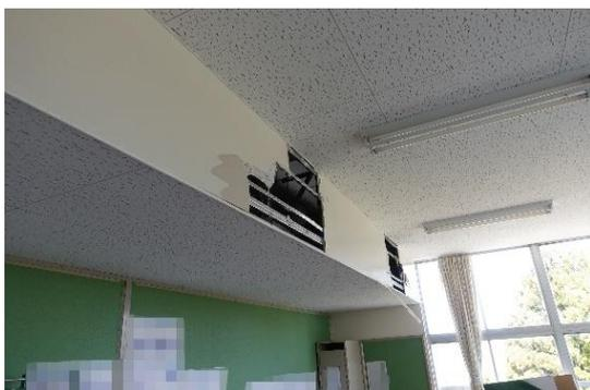
写真NO-102.5 校舎 天井段差部の損傷
