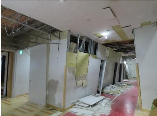
写真 WA-102.7 屋内運動場 ギャラリー部分の間仕切壁の傾き、天井の被害状況
