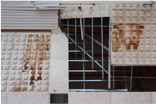
写真 NA-105.7 天井仕上げが脱落した箇所（写真 NA-105.2 丸囲み部分を下から見た様子）
