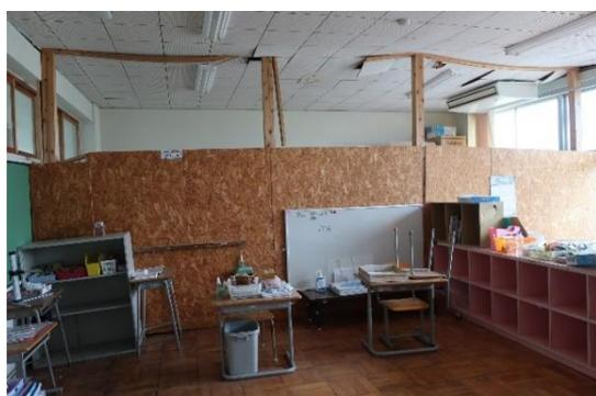
写真 WA-106.5 校舎 床の隆起により持ち上げられた間仕切による天井の損傷
