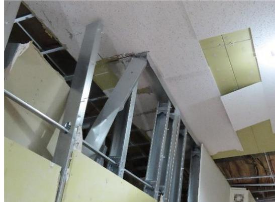
写真 WA-102.8 屋内運動場 ギャラリー部分の間仕切壁、天井の被害状況 (写真 WA-102.7 の壁上端拡大)
