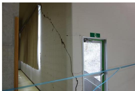
写真 WA-109.4 屋内運動場 壁のひび割れ
