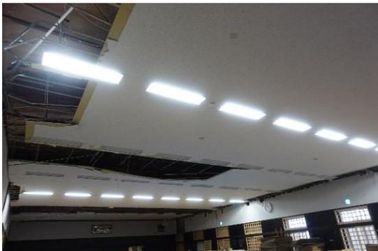
写真 WA-102.15 武道場 天井の被害状況
