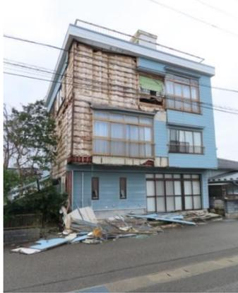
写真 AN-04.1 外壁の脱落
