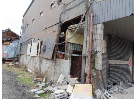
写真 SU-03.2 建築物全体の大きな変形
