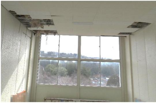
写真 WA-111.21 校舎 3階天井の被害
