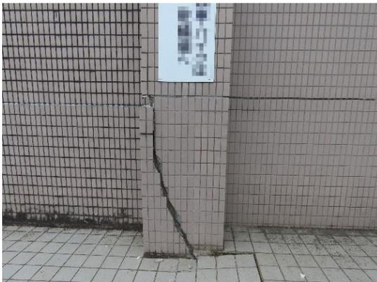
写真NA-102.4 地盤沈下に伴うと思われる外装材の被害
