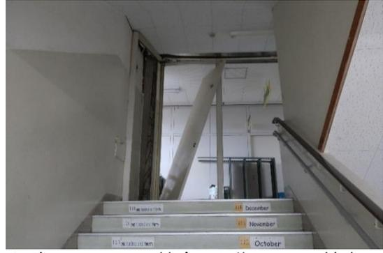
写真 WA-106.8 校舎 3階 Exp.Jの被害
