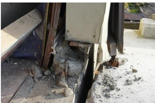
写真 NO-01.5 出入り口の柱脚部分のコンクリート破壊、柱脚部のプレートに溶接されたアンカー鉄筋の破断
