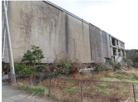
写真 SU-01.2 建築物背面の外壁の脱落
