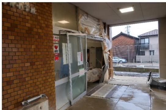
写真 WA-106.3 校舎 玄関サッシの歪み
