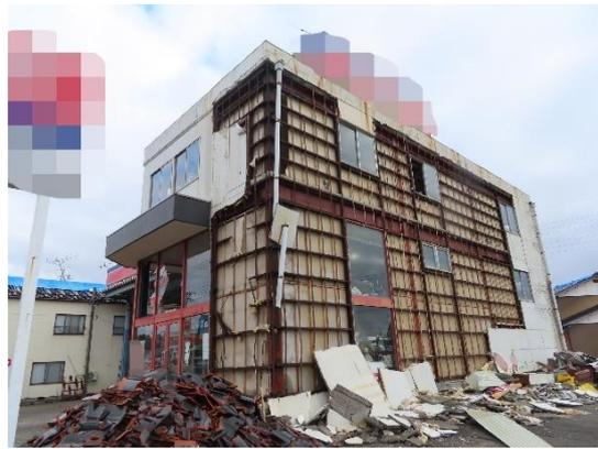
写真 AN-03.2 外壁の広範囲の脱落
