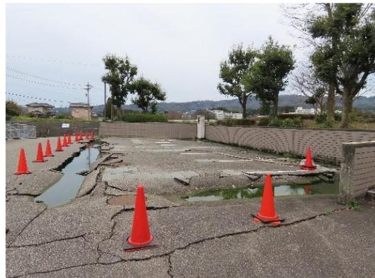
写真NA-102.5 地盤沈下に伴うと思われる貯水槽周辺の被害
