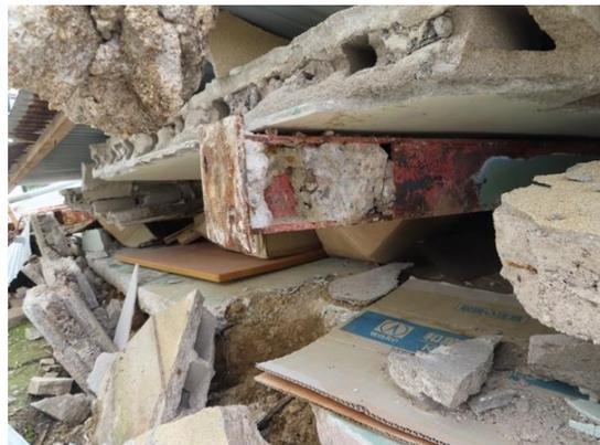
写真 NA-01.4 露出柱脚の引き抜け
