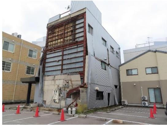
写真 NA-03.2 外壁の脱落
