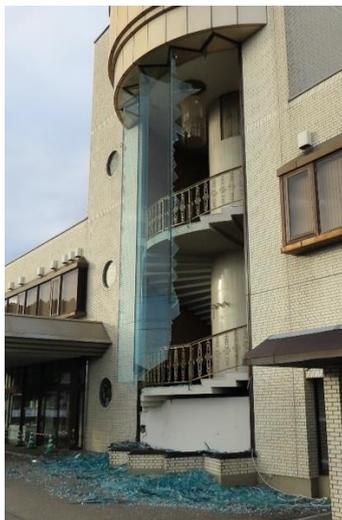
写真 NA-08.1 残ったガラススクリーンが垂れ下がる様子
