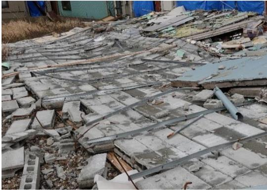
写真 NA-04.5 外壁（コンクリートブロック壁）の脱落・転倒
