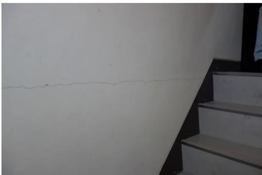
写真 NA-101.3 階段室の壁の損傷
