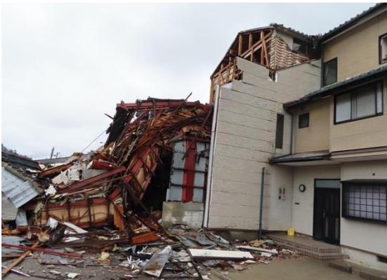
写真 WA-01.1 2階と3階が西側に倒壊
