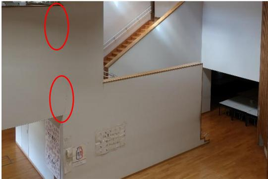
写真 WA-109.9 校舎 内壁のひび割れ
