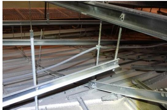
写真 SU-102.3 天井懐における天井金物等の接合状況
