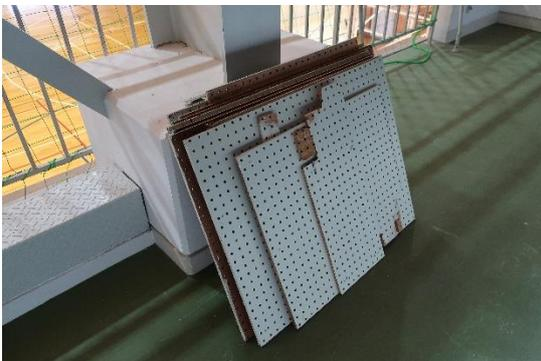
写真 WA-108.5 脱落した有孔合板
