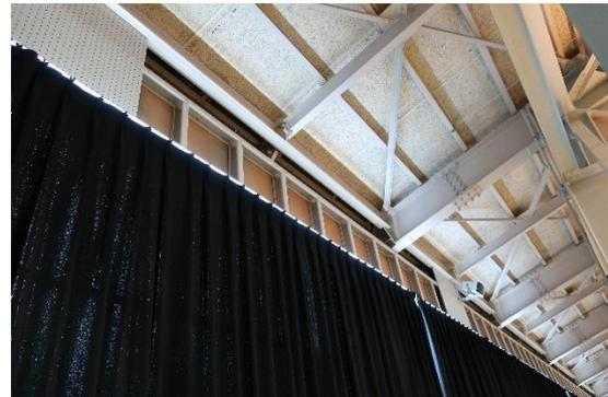
写真 WA-108.4 内装仕上げ板の脱落
