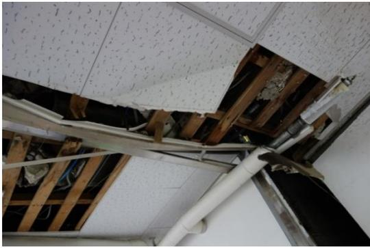
写真 WA-105.5 屋内運動場と校舎との間の Exp.J の損傷
