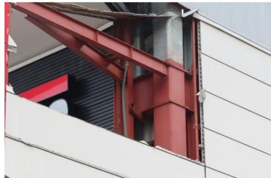
写真 WA-15.4 袖壁のECPの損傷・脱落
