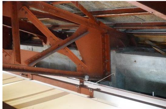
写真 NO-102.12 RC造架構とトラス梁の屋根の接合部の状況
