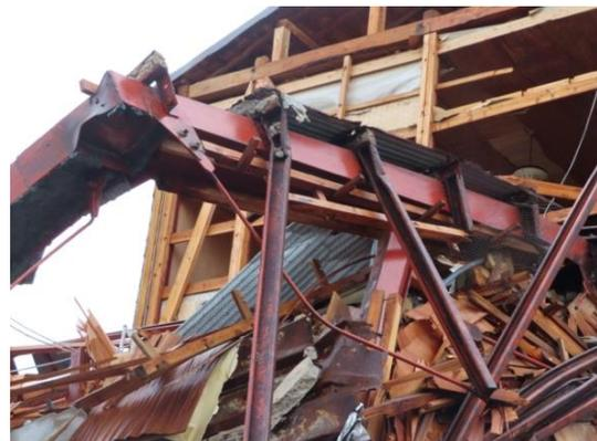
写真 WA-01.2 3階柱頭部のH形柱弱軸方向に接続するターンバックルブレース
