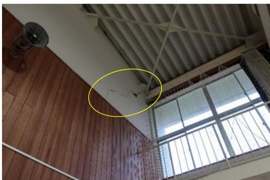
写真 WA-105.3 屋内運動場 内壁のひび割れ
