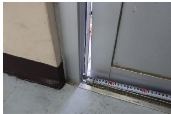
写真 WA-105.10 校舎 (3階建て棟) 写真 WA-105.9 に示した RC造非構造壁の近傍のサッシの隙間
