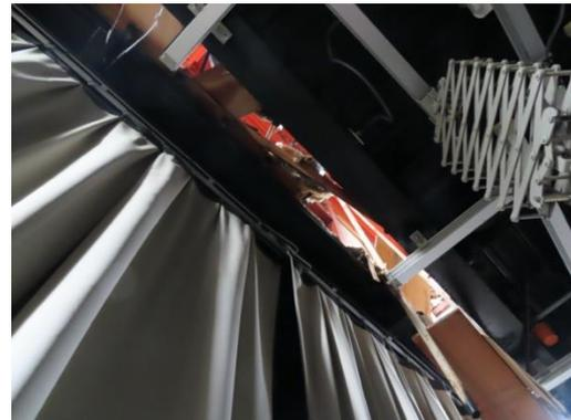
写真 WA-03.4 残留変形による前後の建築物の隙間（建築物内部からの撮影）
