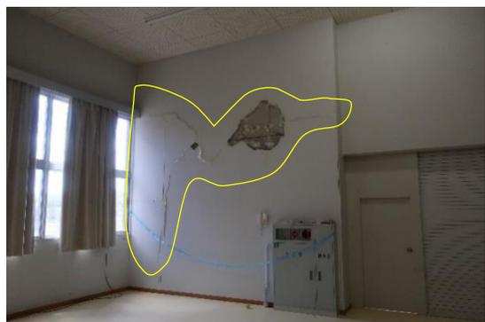
写真 WA-109.5 屋内運動場 壁のひび割れ
