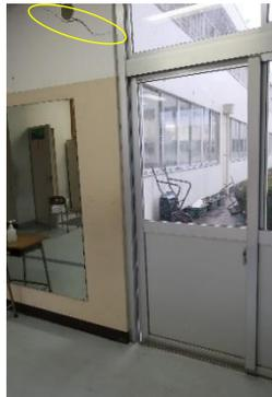
写真 WA-105.9 校舎 (3階建て棟) RC造非構造壁のひび割れ
