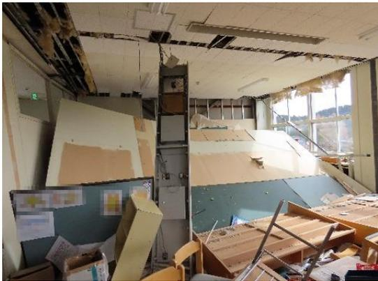
写真 WA-111.15 校舎 3階内壁の被害
