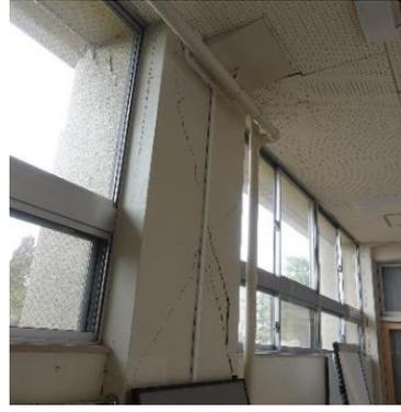
写真 AN-102.14 校舎 柱のひび
