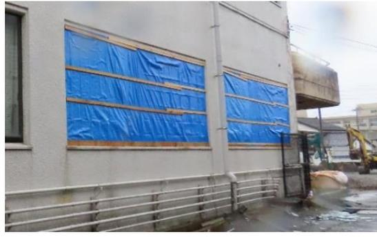
写真 WA-104.16 事務所 1階の窓の被害
