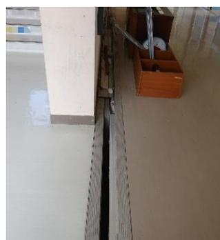
写真NO-102.4 校舎と階段室の間の隙間
