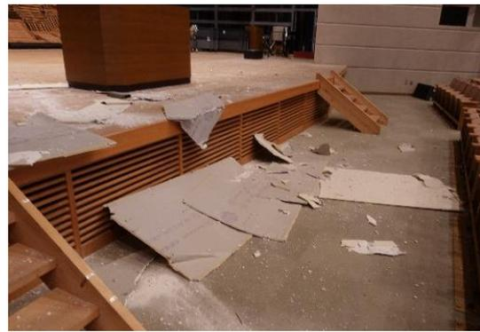
写真 AN-103.3 舞台上部の照明設置箇所側壁のボードの落下状況
