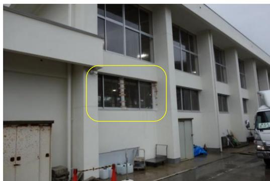
写真 WA-105.4 屋内運動場 建具の損傷
