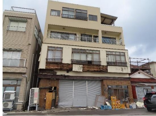
写真 WA-07.2 建築物の前面の外壁の脱落
