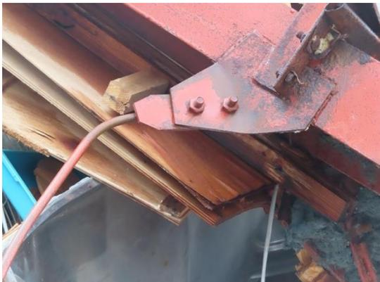
写真 WA-01.7 ターンバックルブレース
