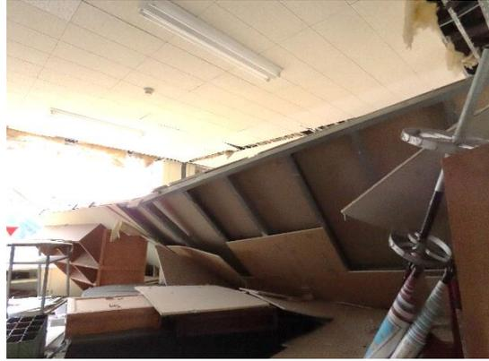
写真 WA-111.14 校舎 3階内壁の被害
