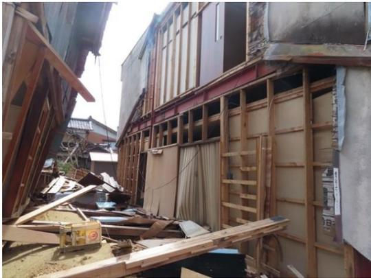
写真 NA-02.3 外壁の広範囲での脱落
