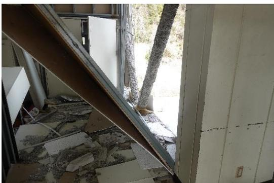
写真 WA-111.11 校舎 3階外壁の被害
