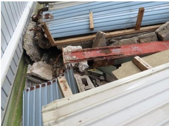
写真 NA-01.3 日の字断面柱の露出柱脚の引き抜け
