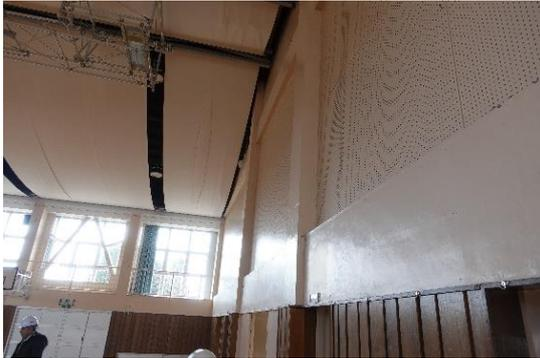
写真 NO-102.9 屋内運動場 妻壁の傾きによる隙間
