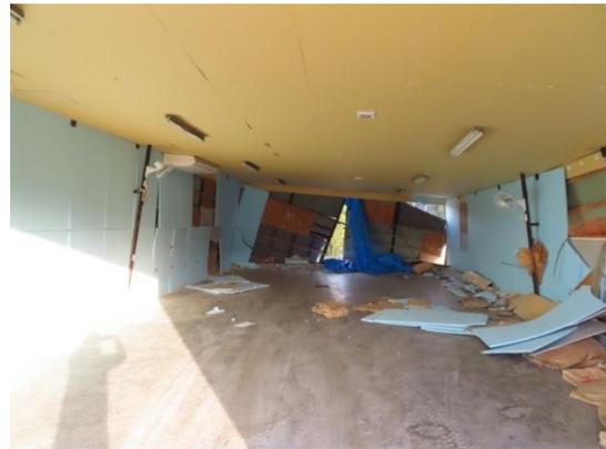
写真 NO-01.2 床の沈下、傾斜
