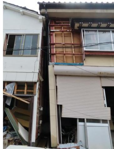
写真 WA-06.2 建築物全体の傾斜と隣接建築物との接触
