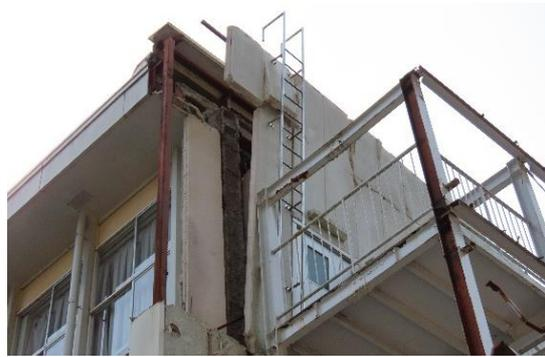
写真 WA-111.22 校舎 3階外壁の被害
