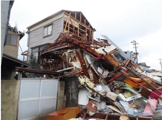
写真 WA-01.5 2階、3階の倒壊の状況
