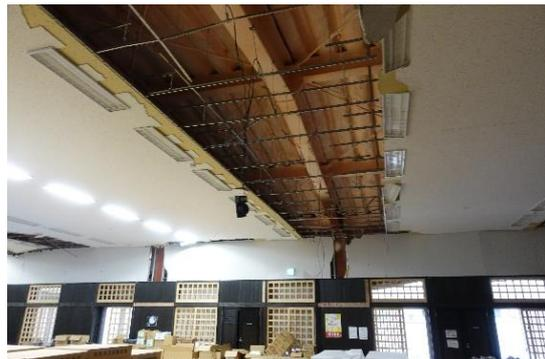
写真 WA-102.16 武道場 天井の被害状況
