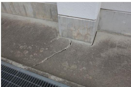
写真NA-105.5 土間コンクリートの損傷
