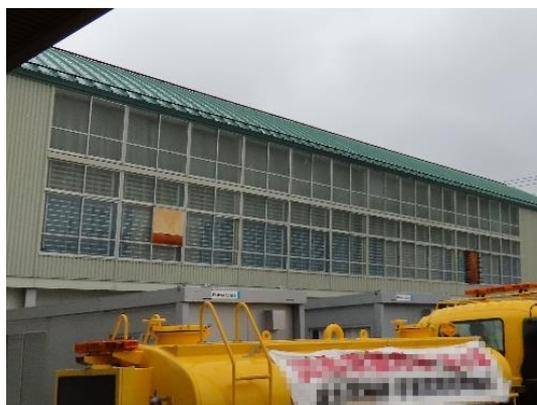
写真 WA-103.6 屋内運動場ガラスの被害
