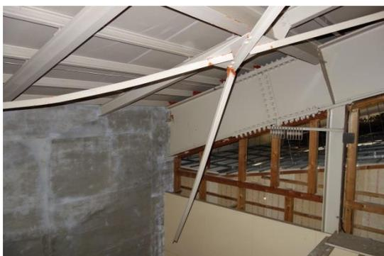
写真NA-105.3 水平ブレース端部の破断
