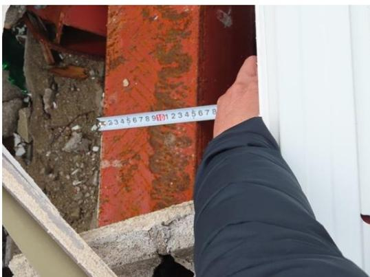
写真 NA-01.5 柱外径（約150mm）
