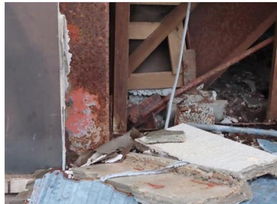
写真 AN-01.4 柱の錆
