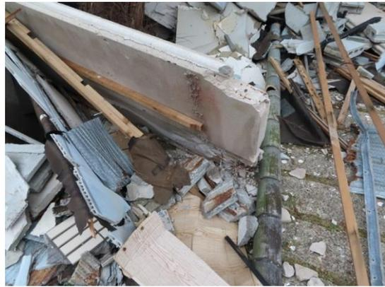
写真 NA-04.4 ALC 外壁の脱落
