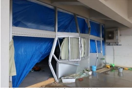
写真 WA-106.7 校舎 1階教室のサッシの歪み
