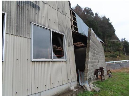
写真 WA-09.2 下屋のコンクリートブロック外壁が一部倒れかかっている
