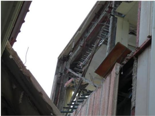
写真 WA-111.5 校舎 3階外壁の被害
