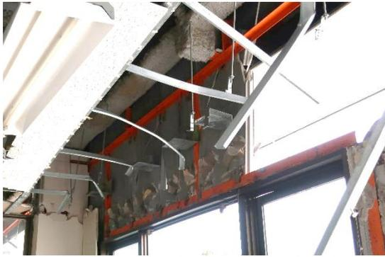
写真 AN-101.11 校舎 外装材支持部の内観
