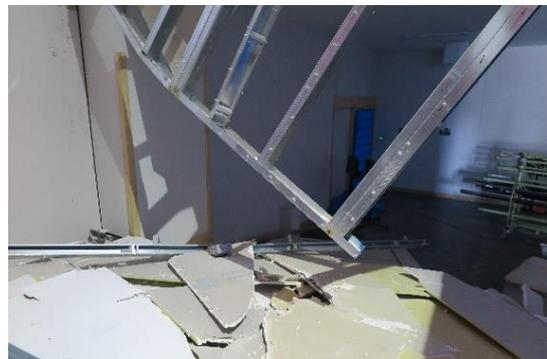
写真 WA-102.10 屋内運動場 舞台裏の間仕切壁、天井の被害状況 (上部ランナの外れ)
