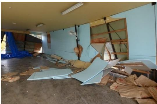
写真 NO-01.3 組立て材のフレームの端部の破断と傾き、はらみ出し、外壁、内壁の破損
