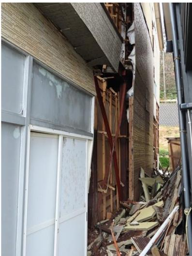
写真 WA-02.3 側面の外壁の脱落
