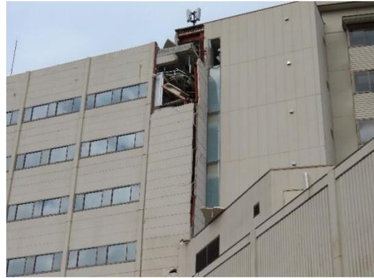
写真 NA-07.2 外壁の脱落
