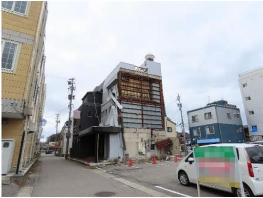
写真 NA-03.1 外壁の脱落
