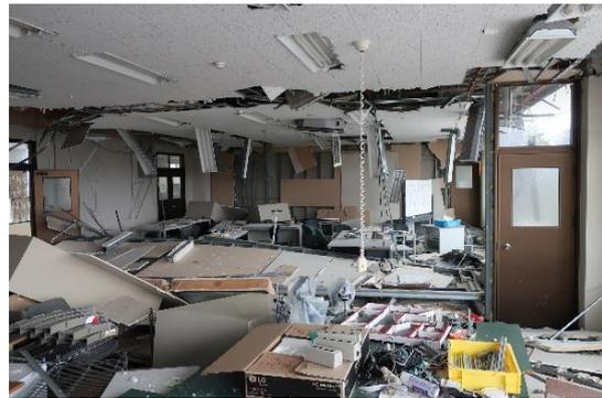
写真 AN-101.14 校舎 間仕切壁の転倒等
