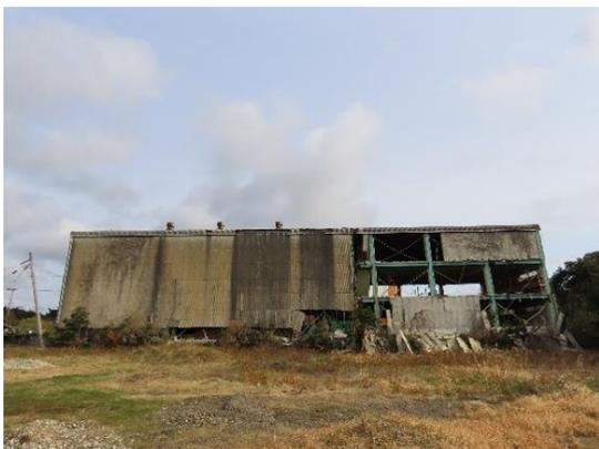
写真 SU-01.3 建築物背面の外壁の脱落
