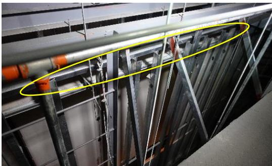
写真 AN-103.4 舞台上部の照明設置箇所における側壁(天井懐の様子)
