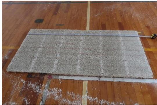
写真 NA-105.8 脱落した木毛セメント板
