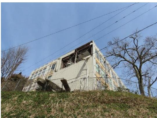
写真 WA-111.3 校舎 外壁脱落
