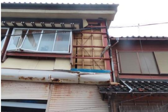
写真 WA-06.3 ターンバックルブレースの状況
