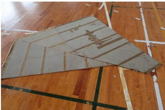
写真 NA-105.9 脱落したフェルト状の面材
