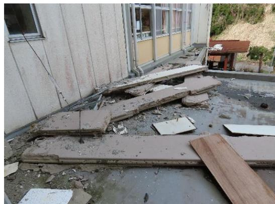
写真 WA-111.10 校舎 落下した3階外壁
