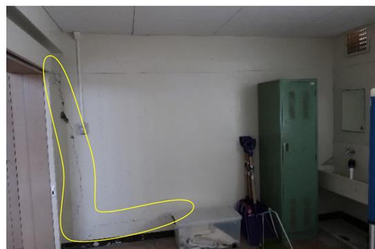
写真 NA-106.4 屋内運動場 1 倉庫の RC 造非構造壁の被害
