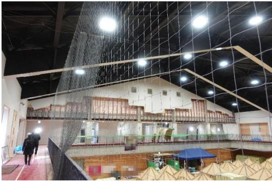
写真 WA-102.5 屋内運動場 妻面の内壁の広範囲な脱落
