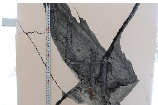
写真NO-102.2 校舎 柱の損傷
