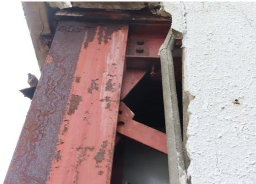
写真 AN-02.5 H形鋼弱軸側の柱梁接合部
