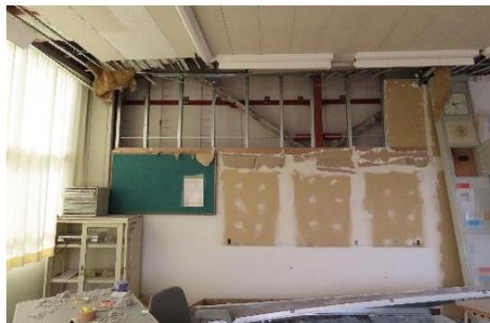
写真 WA-111.20 校舎 3階内壁の被害
