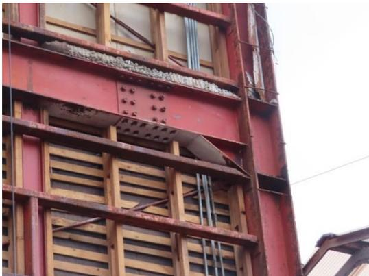
写真 AN-01.3 柱梁接合部
