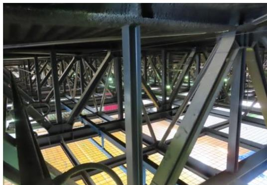
写真 NO-101.4 鉄骨立体トラス梁の屋根
