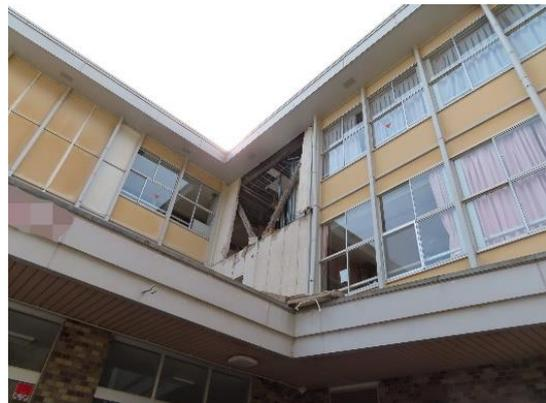
写真 WA-111.2 校舎 外壁脱落
