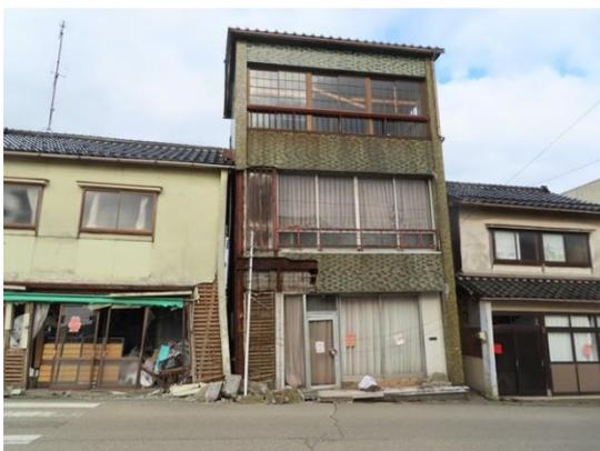
写真 NA-05.1 外観（建築物全体の傾斜）
