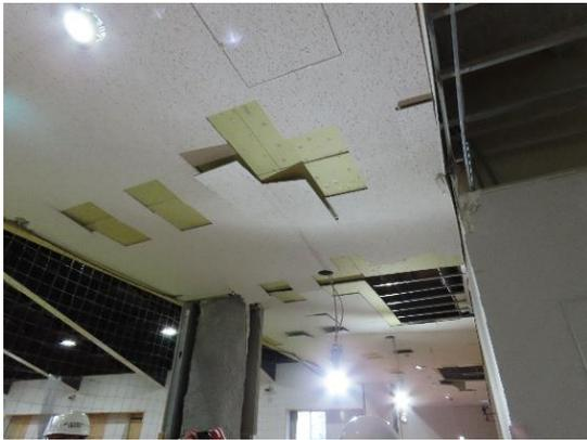
写真 WA-102.13 屋内運動場 ギャラリー部分の天井の被害状況
