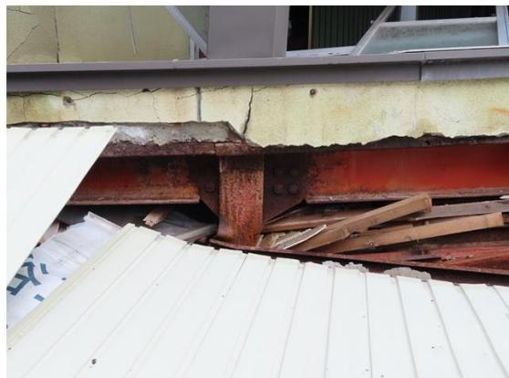
写真 WA-04.6 倒壊した1階の柱頭部の梁端部接合部及び柱の座屈状況
