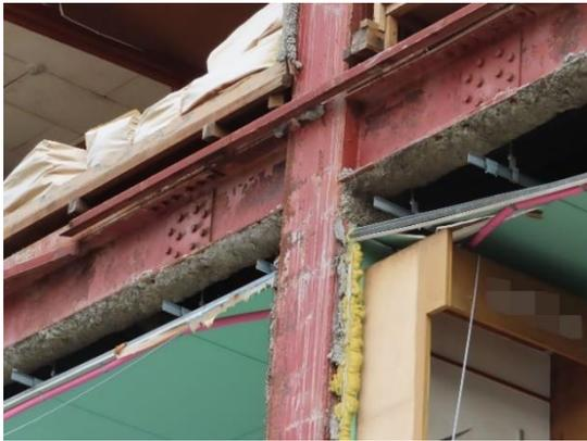
写真 NA-04.3 日の字断面柱梁接合部
