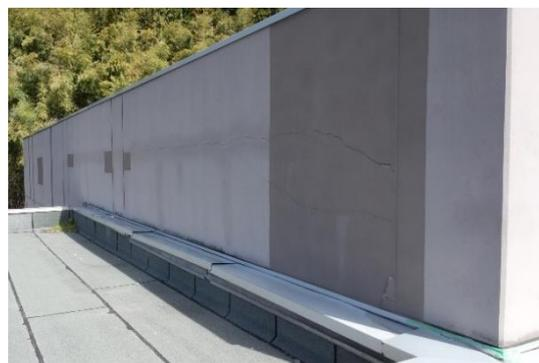
写真 WA-109.6 屋内運動場 外壁のひび割れ
