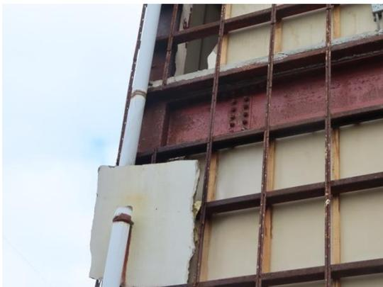
写真 AN-03.3 柱梁接合部
