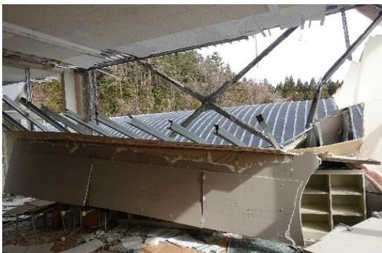
写真 WA-111.19 校舎 3階内外壁の被害
