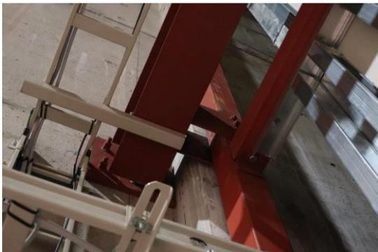
写真 NA-101.7 鉄骨下地と躯体の接合
