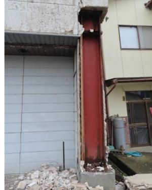
写真 AN-02.4 柱脚の錆と腐食
