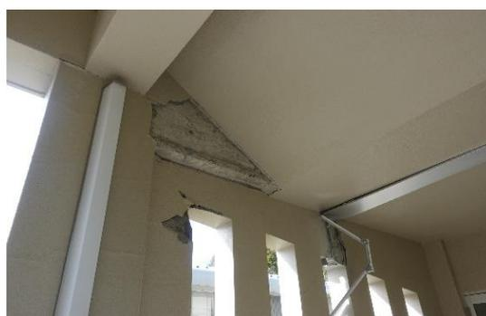
写真 SU-101.2 校舎渡り廊下の壁の破損
