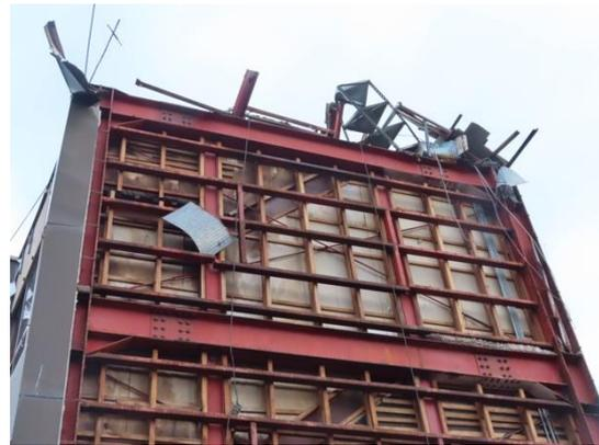
写真 AN-01.2 側面の外壁の広範囲での脱落
