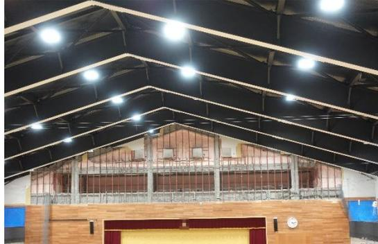
写真 WA-102.4 屋内運動場 妻面の内壁の広範囲な脱落
