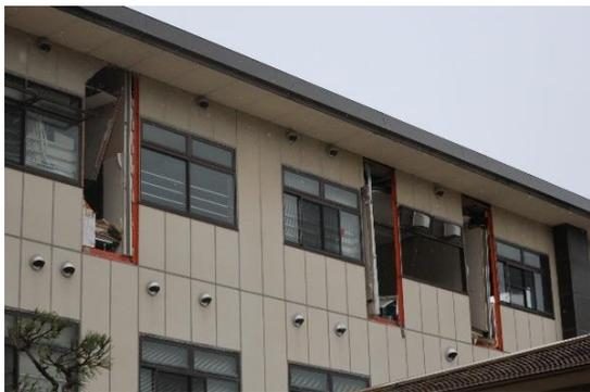
写真 AN-101.15 校舎 張間方向の外壁の脱落
