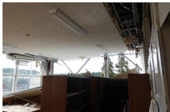
写真 WA-111.12 校舎 3階内外壁の被害
