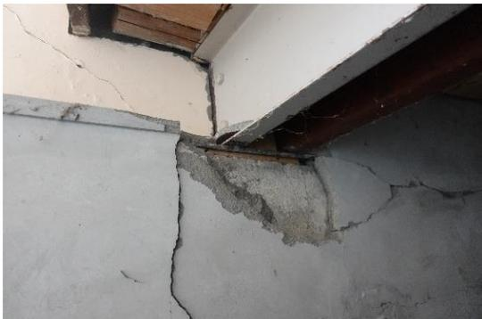
写真 NO-102.13 地下部分のコンクリートの破損
