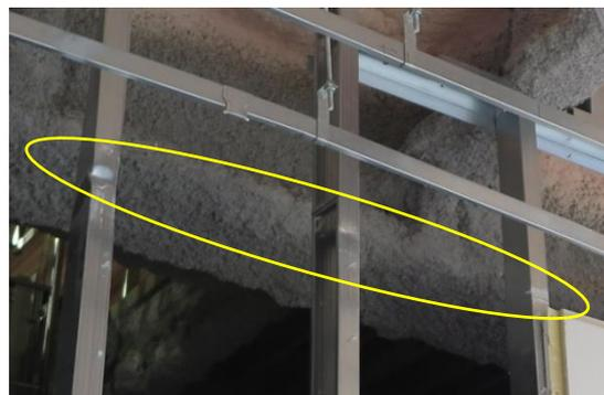
写真 WA-102.12 屋内運動場 舞台裏の間仕切壁の被害状況 (写真 WA-102.11 の丸部分拡大。天井面高さの位置でスタッドが変形)
