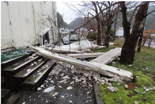
写真 WA-101.7 脱落した外壁
