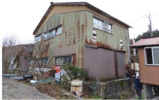
写真 WA-13.2 建築物の裏側からは大きな残留変形(たわみ)が見られた
