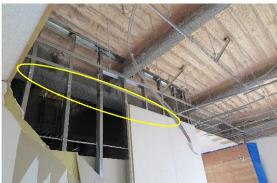
写真 WA-102.11 屋内運動場 舞台裏の間仕切壁、天井の被害状況 (天井面高さの位置でスタッドが変形)
