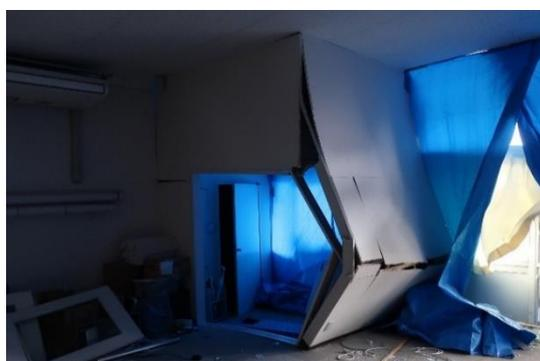
写真 WA-106.6 校舎 内部間仕切壁の損傷
