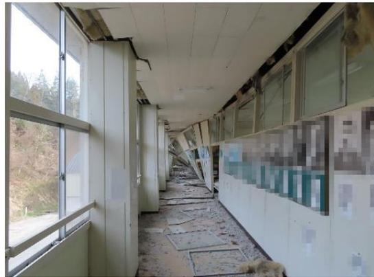
写真 WA-111.16 校舎 3階内壁の被害
