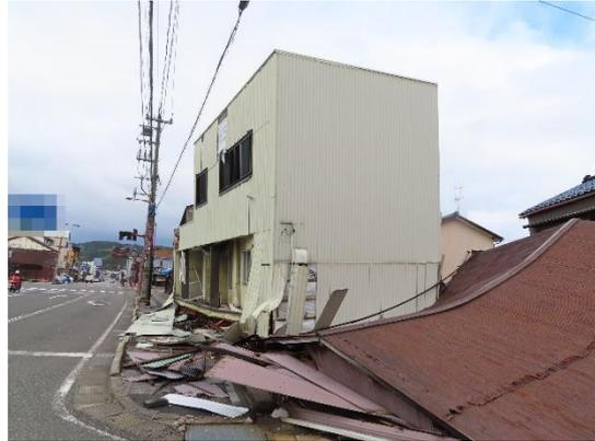
写真 WA-04.2 1階の層崩壊（側面）
