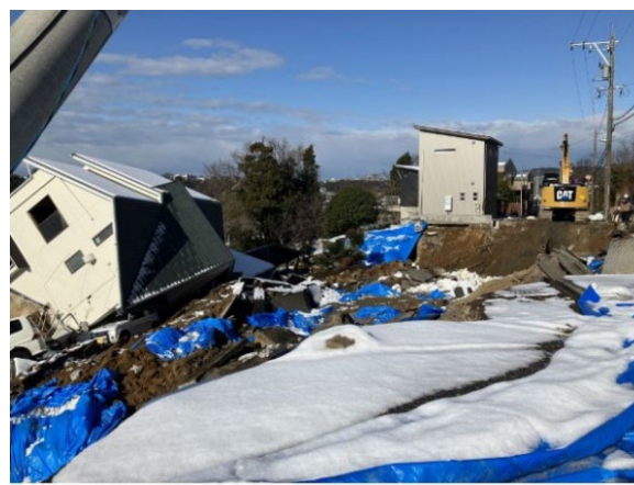
写真 4.2 崩壊した斜面の状況（2）
