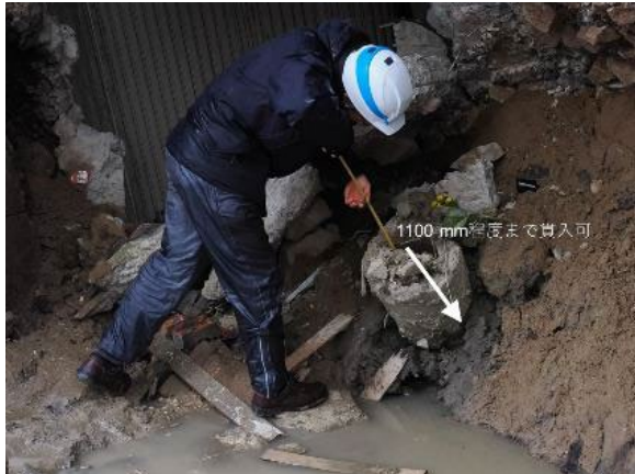
写真 6.5 露出した杭頭
