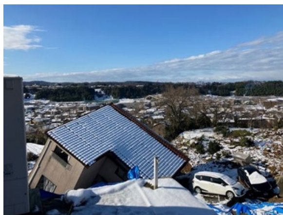
写真 4.1 崩壊した斜面の状況（1）
