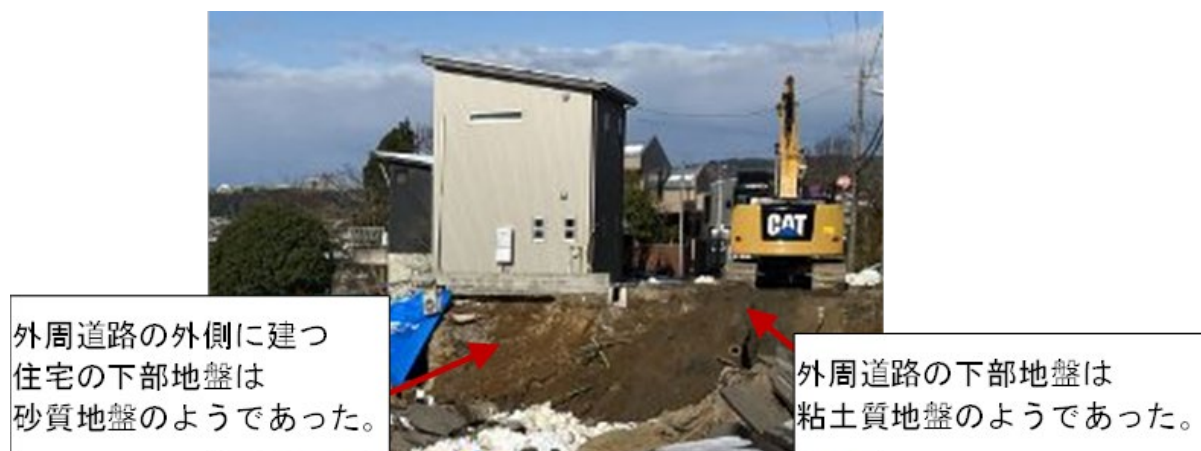
写真 4.5 斜面崩壊エリアの地表面（写真 4.2 のアップ）
