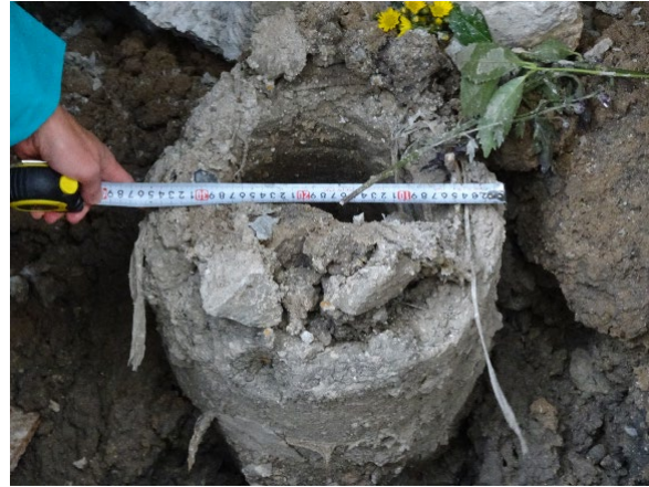
b) 杭の寸法形状の確認状況
