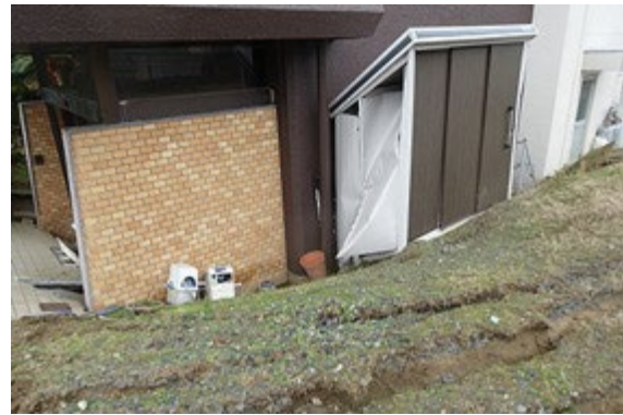
写真 5.5 正面入口付近の状況（周辺地盤）
