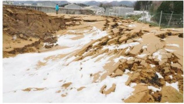
写真 10.2 校庭の地割れ
