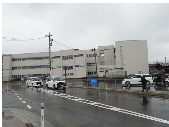
写真 8.1 C 小学校の外観
