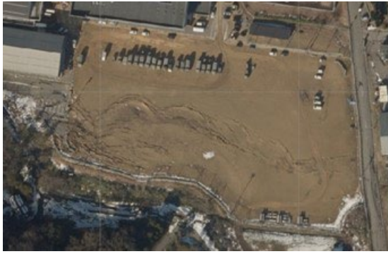
写真 10.1 校庭の地割れ全景 1)
