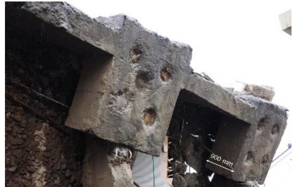
写真 6.4 パイルキャップ
