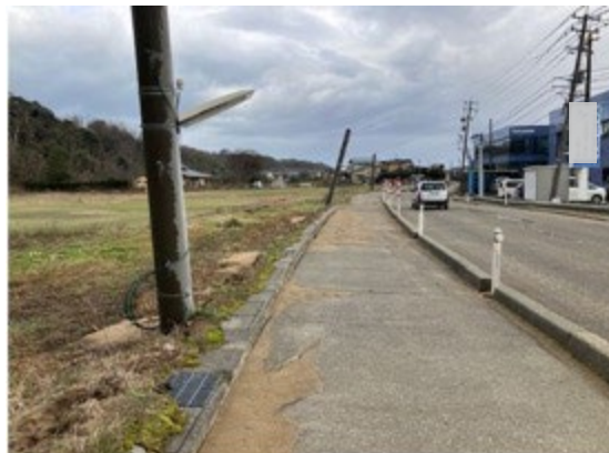
写真 5.6 県道 8 号の状況（写真左側が砂丘であり、県道 8 号沿いは砂丘に隣接する低地）
