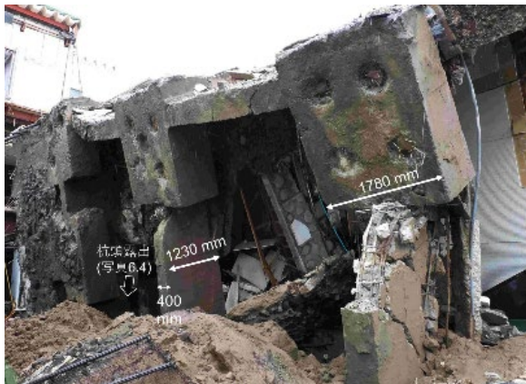
写真 6.3 引抜き側のパイルキャップと基礎梁
