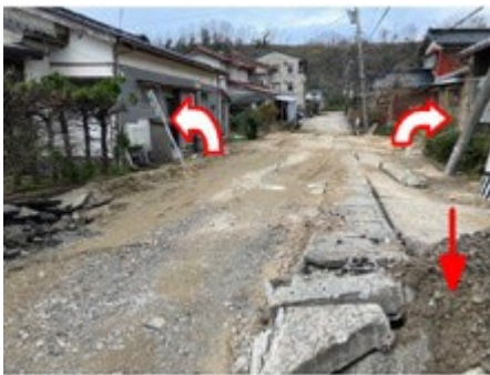
g) 地盤沈下と傾斜した電柱等
