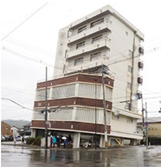
写真 7.1 建物全景（南東側から撮影）
