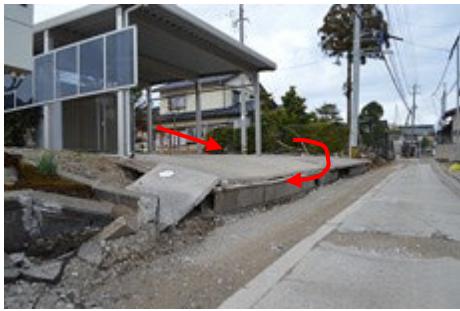
k) 側方流動と側溝の回転
