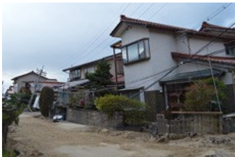
m) 住宅の沈下
