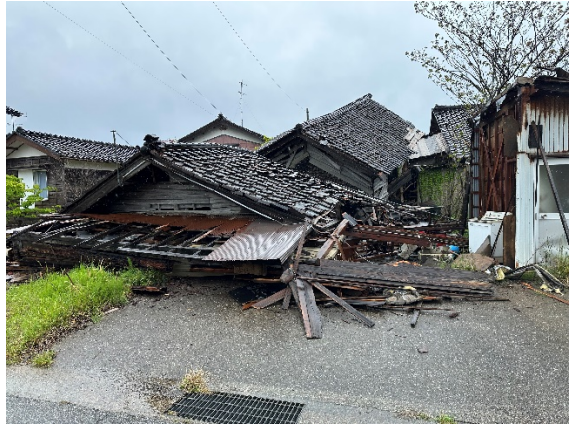
写真 6.2.4 写真 6.2.1 近傍の倒壊住宅 2
