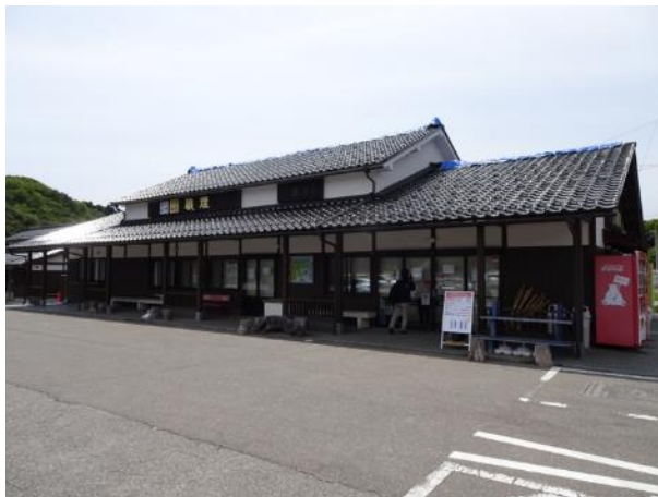
写真 8.3.1 建築物の外観
