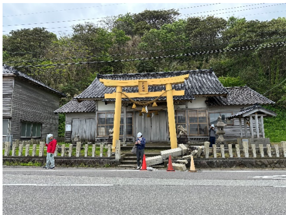
写真 7.3.3 石棒状の柵等の倒壊・社殿無被害
