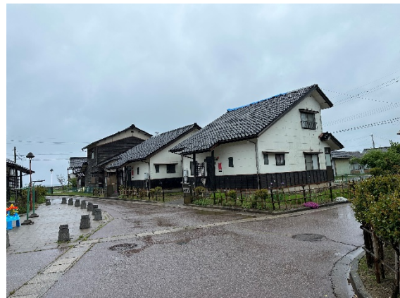
写真 6.2.8 屋根瓦に被害を受けた公営住宅
