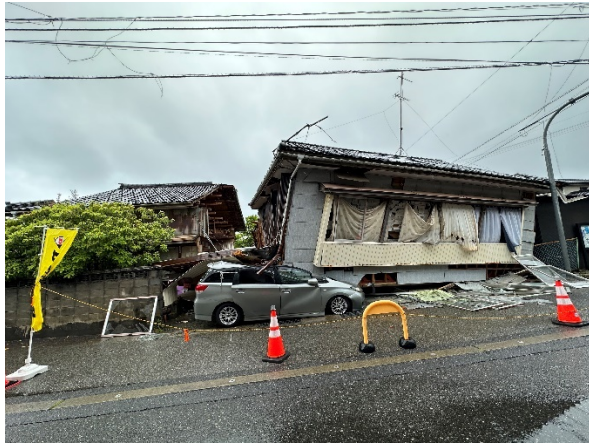
写真 6.1.1 倒壊した住宅全景
