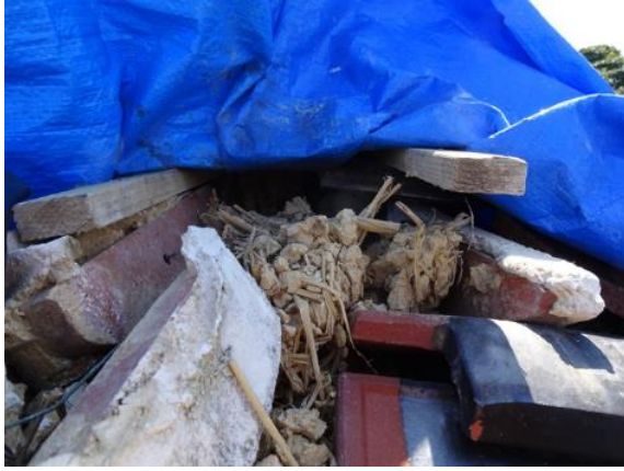
写真 8.2.5 棟部の施工状況
