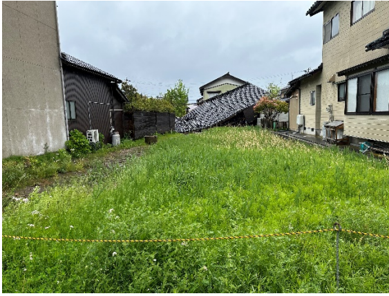
写真 6.2.3 写真 6.2.1 近傍の倒壊住宅 1
