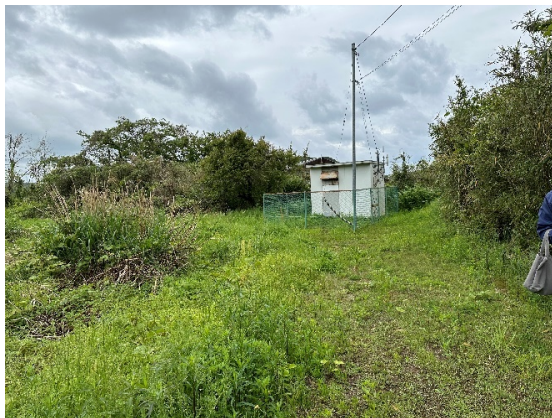
写真 7.3.1 地震計設置状況
