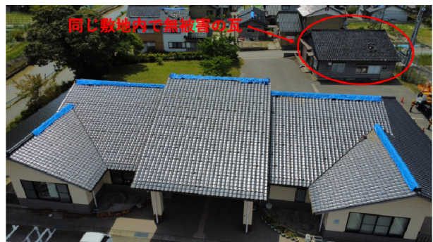
写真 8.2.2 屋根全体と古い倉庫(右上)
