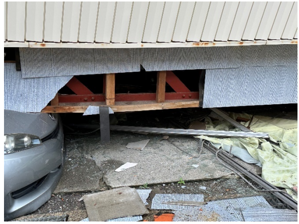
写真 6.1.2 横架材に使用されている鋼製部材
