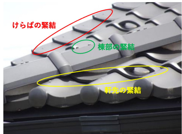
写真 8.4.2 軒先・けらば・棟部の緊結状況
