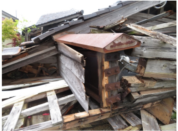
写真 6.2.6 写真 6.2.4 の住宅に用いられていた鋼製はり
