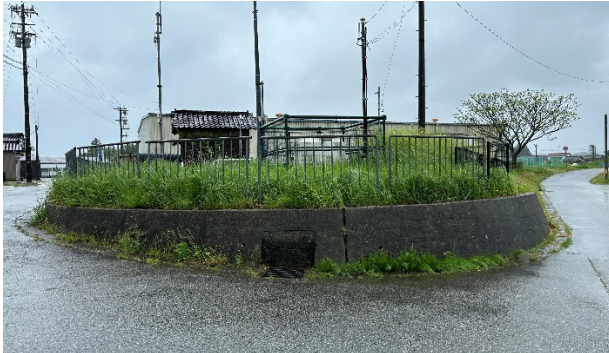
写真 7.1.1 地震計設置状況
