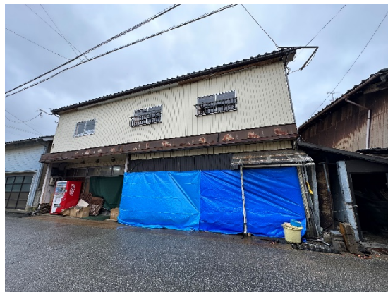
写真 6.2.2 写真 6.2.1 北隣の傾いた店舗併用住宅
