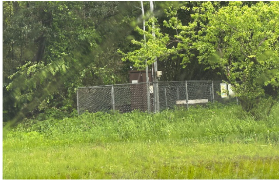
写真 7.2.1 地震計設置状況
