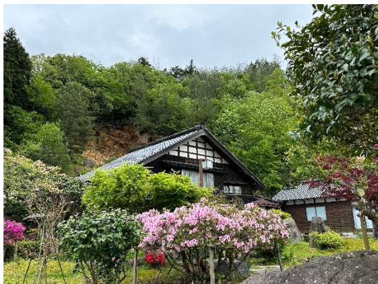
写真 6.2.23 大規模な斜面崩壊で危険な住宅
