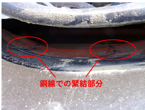
写真 8.2.3 平瓦の緊結状況
