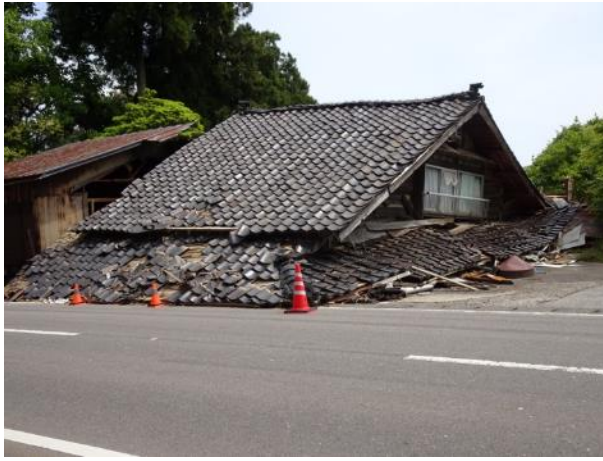
写真 8.5.7 倒壊した建築物 (珠洲市三崎町)
