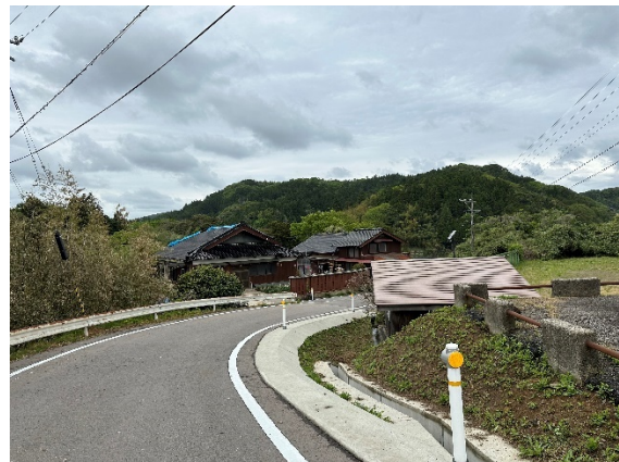
写真 7.3.2 近隣の屋根瓦の被害
