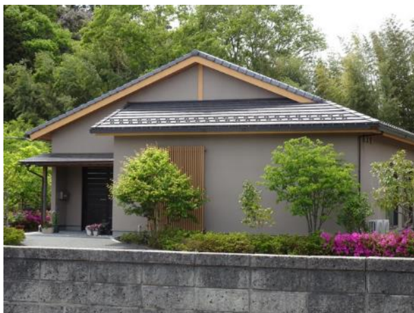
写真 8.4.3 住宅 B の外観
