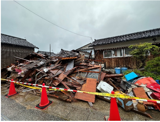
写真 6.2.9 余震で倒壊した木造廃工場建築
