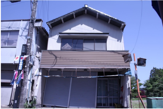
写真 6.5.3 店舗併用住宅の傾斜 1/10rad
