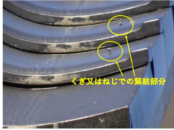
写真 8.2.6 けらばの緊結状況
