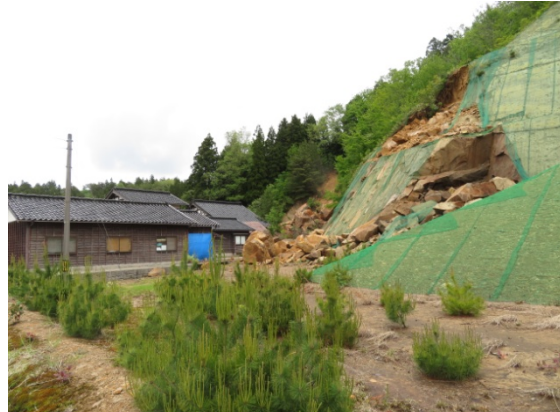
写真 6.2.24 写真 6.2.23 の住宅の裏側
