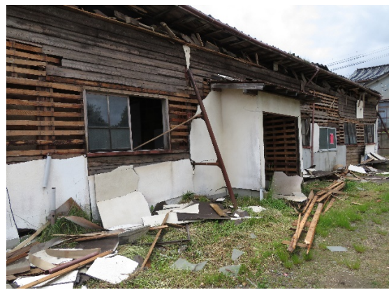
写真 6.2.17 写真 6.2.16 の倉庫の鋼製バットレス
