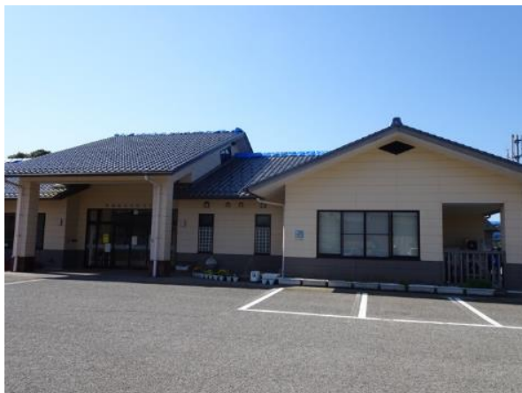
写真 8.2.1 建築物の外観
