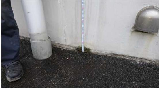
写真5-70 外壁周りでの地盤沈下
