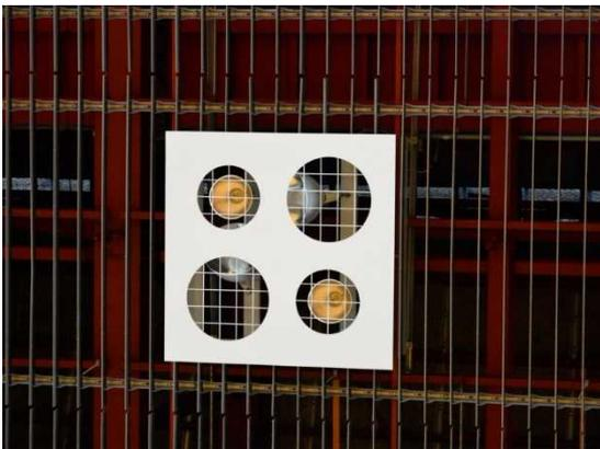
写真5-39 天井設置の照明器具のずれ (写真内の右上と左下の照明が定位置からずれている)
