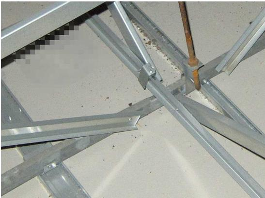
写真5-23 ねじどめした接合部の詳細
