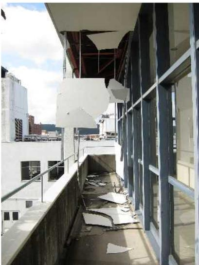
写真5-25 前写真と対角位置での軒天井の被害
