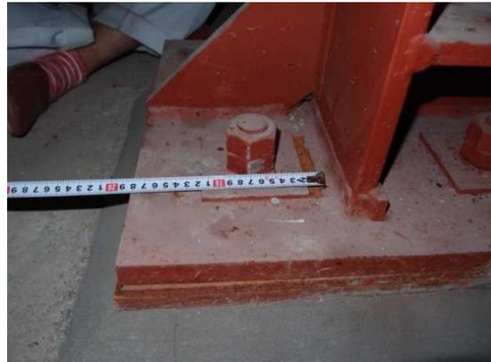
写真5-30 鉄筋コンクリート造架構と鉄骨造トラス屋根の接合部のずれ
