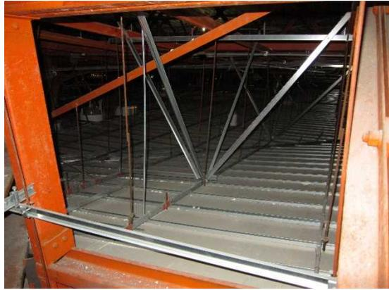
写真5-22 天井裏 (鋼製下地材による天井)
