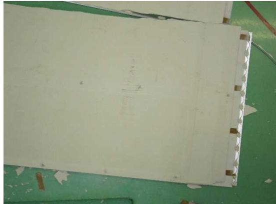
写真5-63 脱落した壁ボード（同）
