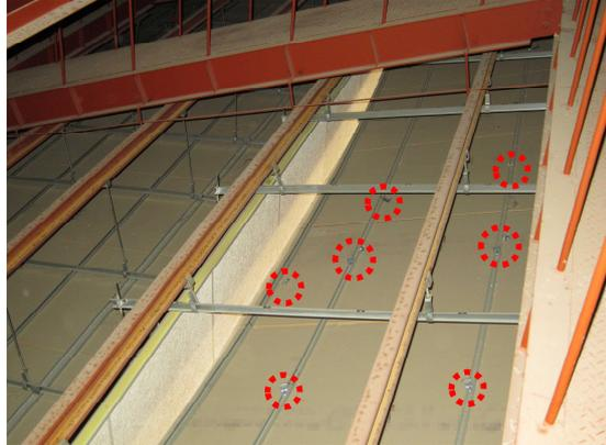
写真5-38 天井面垂れ下がり箇所の天井裏でのクリップの外れ (赤円内が外れたクリップ)
