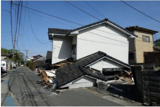
写真 2.13 倒壊した木造住宅
