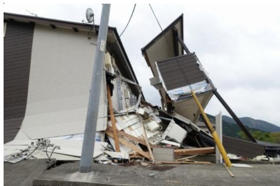
写真 4.32 鉄骨階段と木造部分の分離
