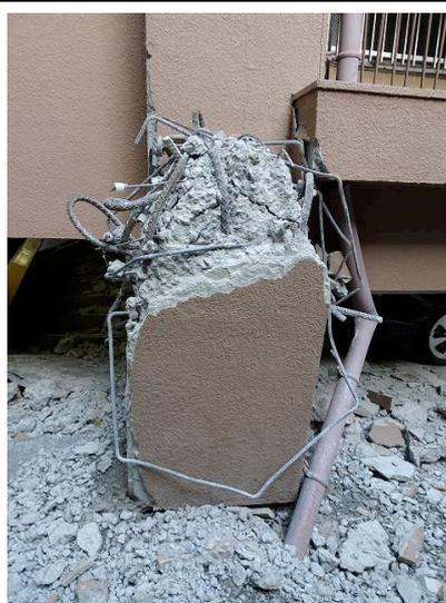
写真 3.1.10-4 南北軸住棟の西側柱
