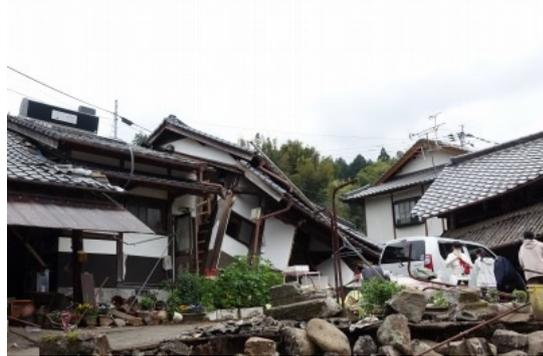
写真 3.18 倒壊した木造住宅
