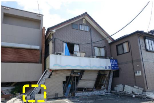
写真 2.9 大きく傾斜したS造店舗併用住宅
