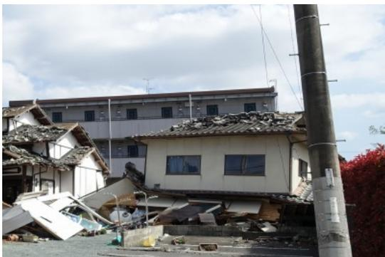
写真 2.17 倒壊した木造住宅
