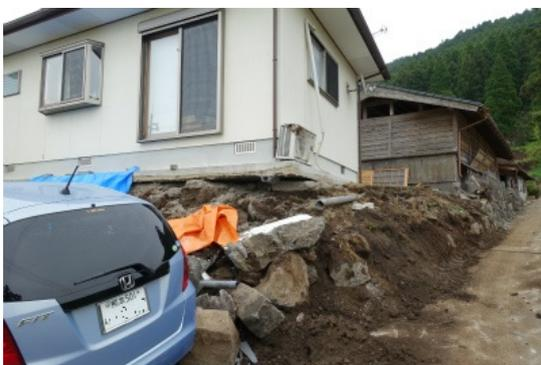
写真 3.9 崩壊した擁壁
