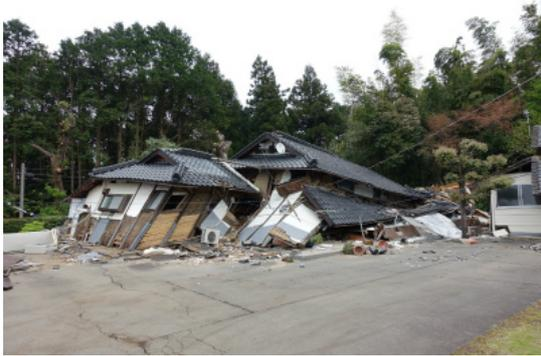
写真 3.17 倒壊した木造住宅
