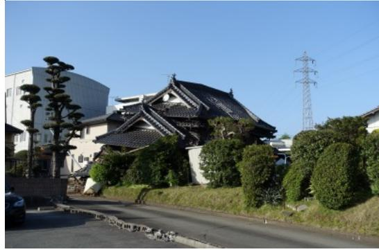
写真 2.30 大きく傾斜した木造住宅
