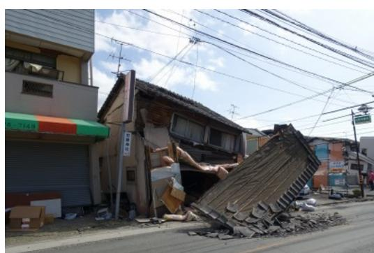
写真 2.4 倒壊した木造住宅
