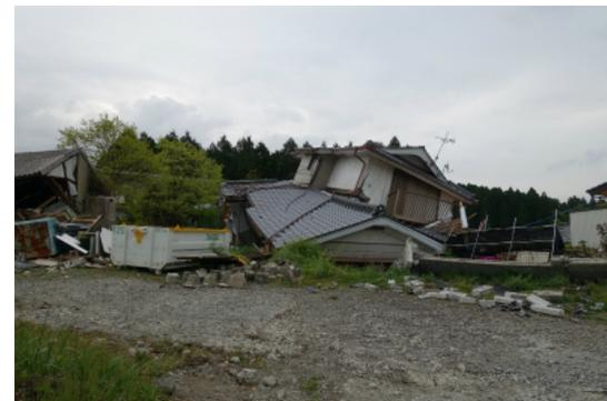
写真 4.14 倒壊した木造住宅
