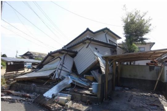
写真 2.15 倒壊した木造住宅
