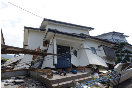
写真 2.11 倒壊した木造住宅
