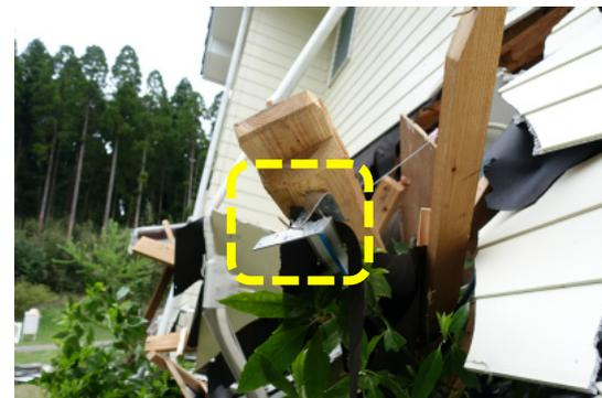
写真 4.16 写真 4.15 の住宅の柱頭部
