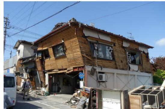
写真 2.8 2階が大きく傾斜した1階鉄骨造+2階木造の店舗併用住宅
