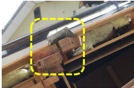
写真 2.22 写真 2.21 の住宅の柱脚部
