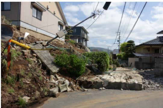
写真 2.27 崩壊した擁壁
