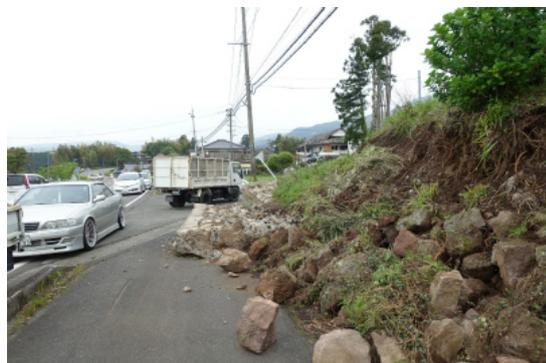
写真 3.8 崩壊した擁壁
