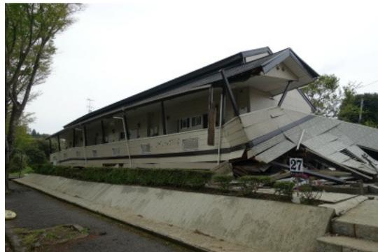
写真 4.24 倒壊したアパート②
