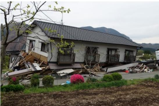
写真 4.5 倒壊した木造アパート
