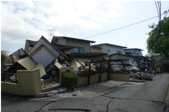
写真 2.21 倒壊した木造住宅
