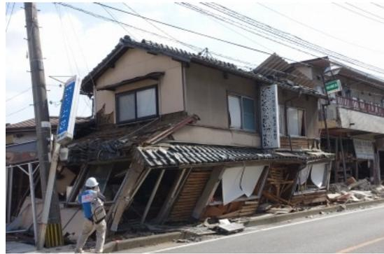
写真 2.6 大きく傾斜した店舗併用住宅
