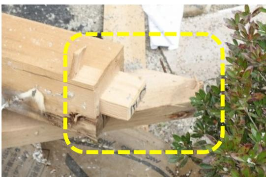
写真 4.25 柱頭部（釘打ちによる接合）
