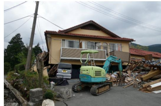
写真 4.12 倒壊した木造住宅
