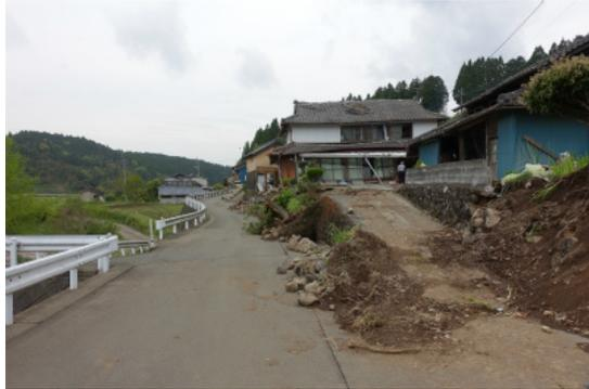
写真 3.20 崩壊した擁壁
