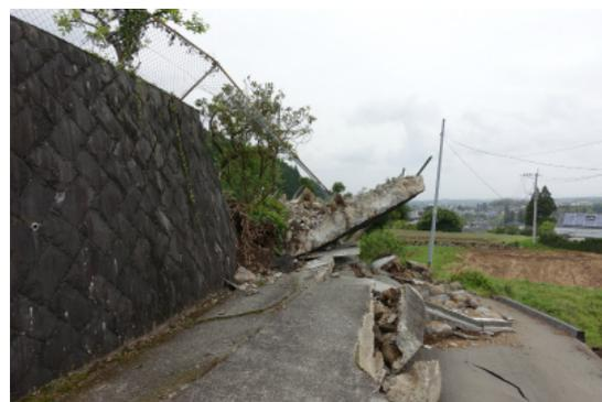
写真 3.10 崩壊した擁壁
