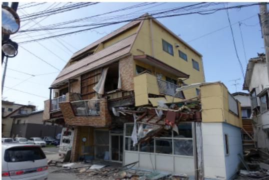
写真 2.7 2階が崩壊した鉄骨造の3階建て店舗併用住宅
