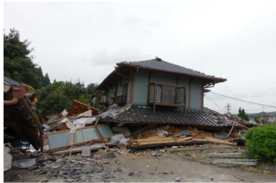
写真 3.4 倒壊した木造住宅
