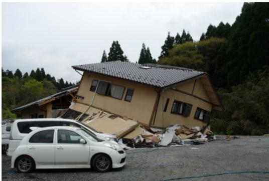
写真 4.11 倒壊した木造住宅
