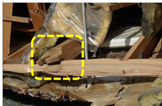
写真 2.20 写真 2.19 の住宅の柱頭部
