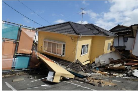
写真 2.14 倒壊した木造住宅
