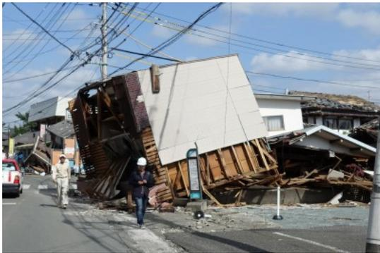
写真 2.5 倒壊した店舗併用木造住宅
