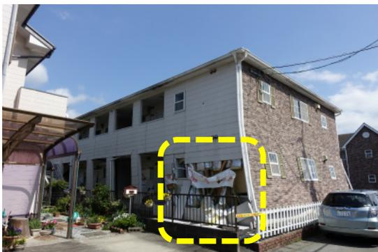
写真 2.23 大きく傾斜した木造アパート
