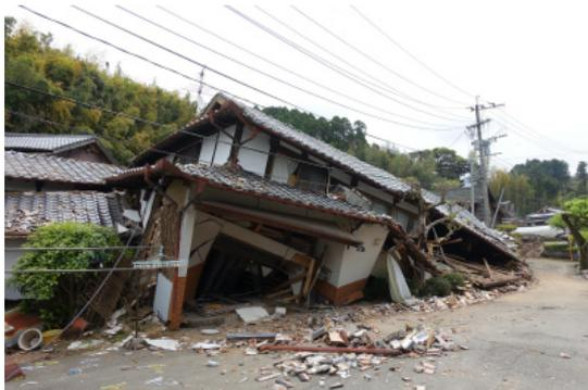
写真 3.15 倒壊した木造住宅
