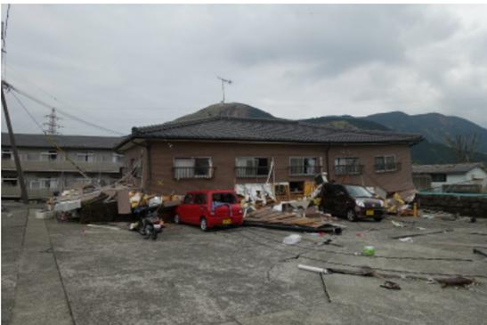
写真 4.3 倒壊した木造アパート
