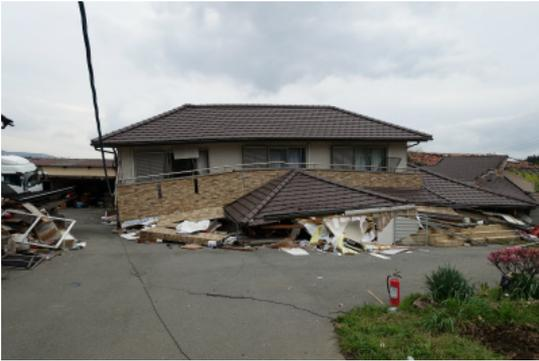
写真 4.16 倒壊した木造住宅（金物あり）
