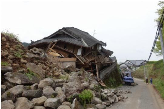
写真 3.19 倒壊した木造住宅
