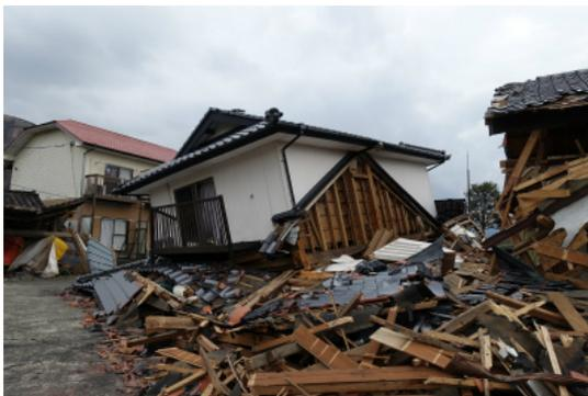
写真 4.13 倒壊した木造住宅
