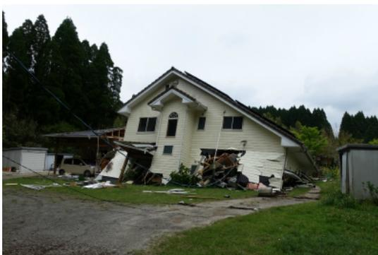
写真 4.15 倒壊した木造住宅（金物あり）
