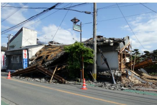
写真 2.3 倒壊した木造住宅
