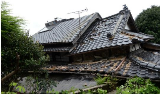
写真 3.3 倒壊した木造住宅
