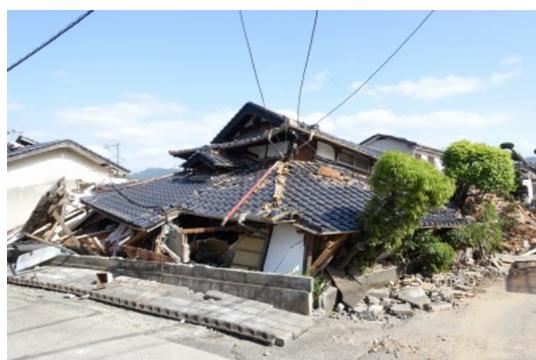
写真 2.2 倒壊した木造住宅
