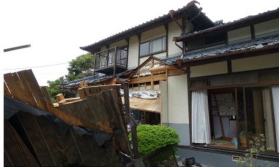
写真 3.6 玄関部分が部分破壊した木造住宅
