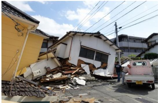
写真 2.16 倒壊した木造住宅
