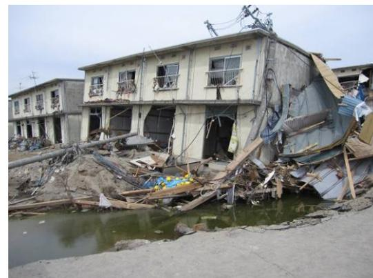
写真 6.3.11-28 周辺地盤の洗掘による建物傾斜
