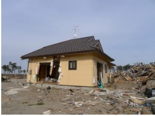
写真 6. 3. 11-58 残存した木造と鉄骨造住宅
