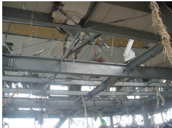
写真 6. 3. 11-47 内外装の破損
