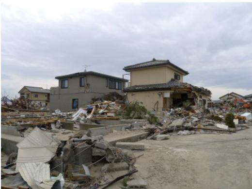
写真 6. 3. 13-27 残存する木造と鉄骨造住宅 (19)
