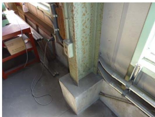
写真 4.4-16 根巻柱脚 (損傷なし)
