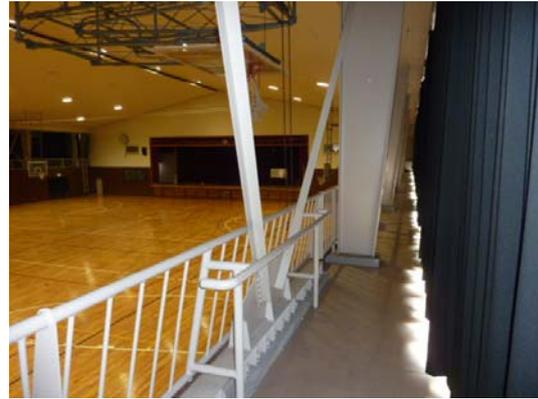
写真 4.4-2 耐震改修で導入された補強ブレース
