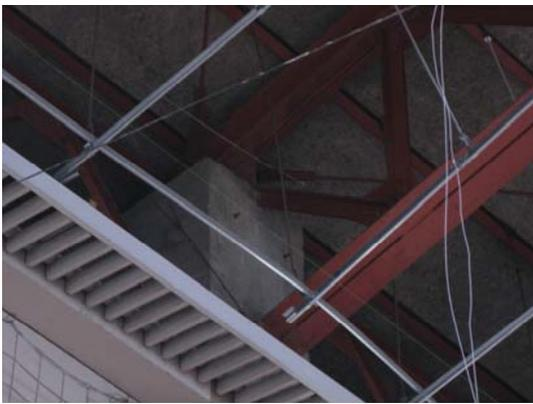
写真 4.2-30 屋根と RC 造柱の接合部分
