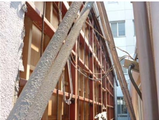
写真 4.2-22 外壁の脱落
