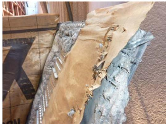
写真 4.2-23 脱落したラスモルタル外壁
