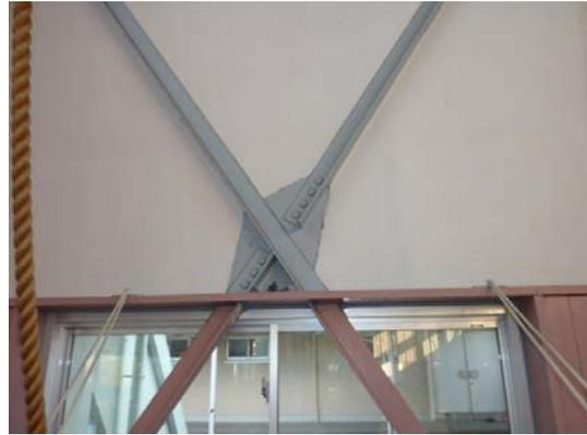
写真 4.4-27 ブレース (損傷なし)
