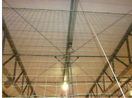
写真 4.4-12 屋根面水平ブレース (損傷なし)
