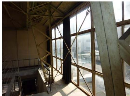
写真 4.4-4 ブレースおよびラチス柱
