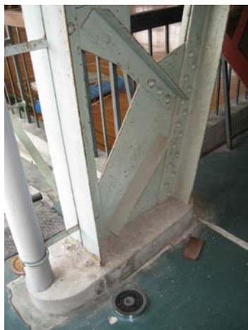
写真 4.2-47 柱脚 (損傷なし)
