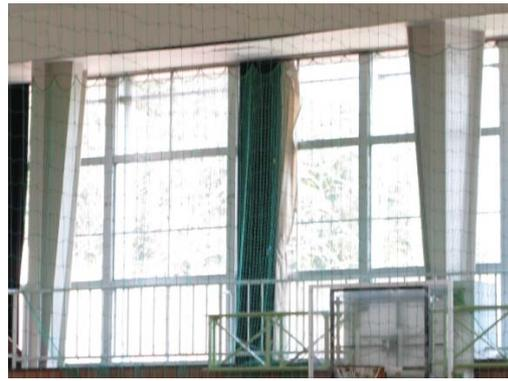
写真 4.1-2 桁行方向にラーメンを構成する柱
