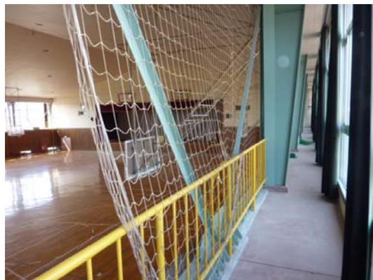
写真 4.4-6 耐震改修で導入された補強ブレース
