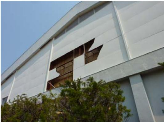
写真 4.2-17 外壁仕上材の脱落
