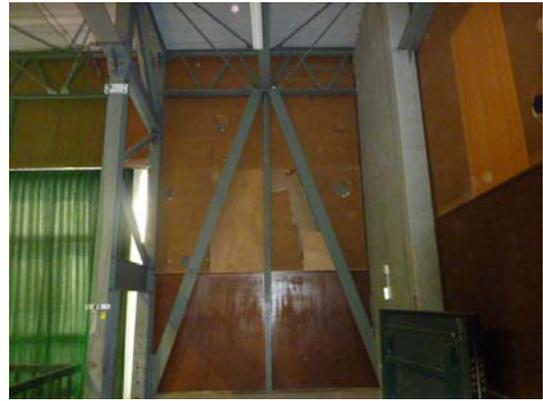
写真 4.4-10 ブレース (損傷なし)
