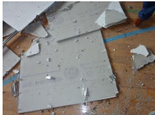
写真 4.2-33 脱落した天井 2
