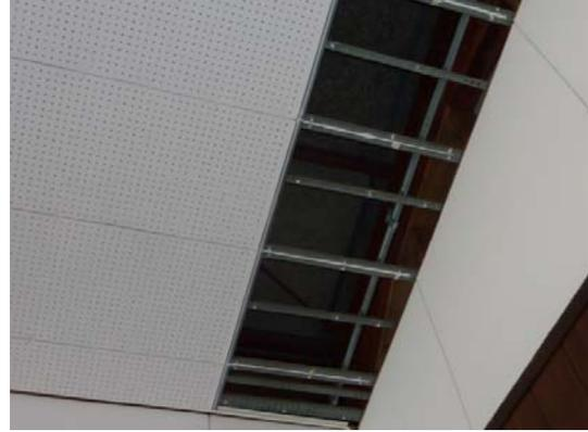
写真 4.2-39 天井板の外れ
