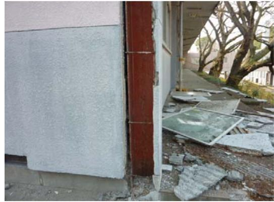
写真 4.2-19 H形鋼の柱（損傷なし）
