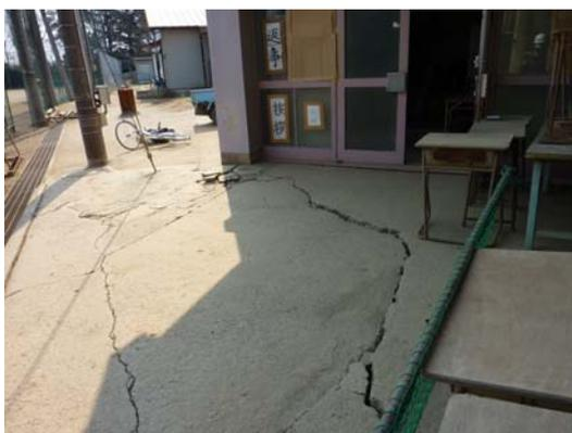
写真 4.2-27 地盤の割れ及び沈下
