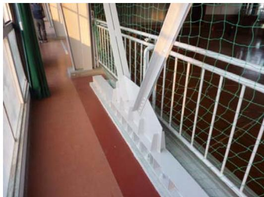
写真 4.2-49 耐震改修で導入された補強ブレース
