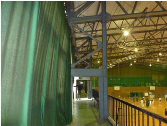
写真 4.4-11 ラチス柱 (損傷なし)
