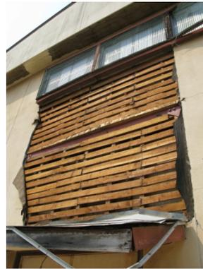
写真 4.1-12 外壁仕上げの落下
