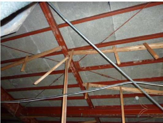
写真 4.2-20 屋根面水平ブレース（損傷なし）
