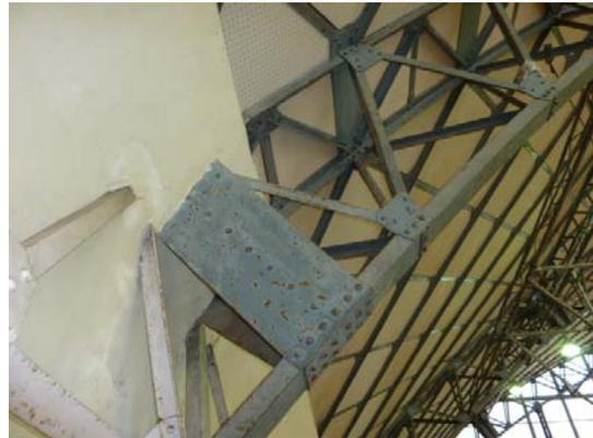
写真 4.4-21 屋根面トラス（損傷なし）
