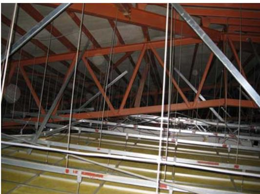
写真 4.2-5 振れ止めの外れ（天井裏の様子）
