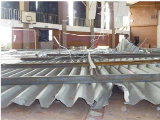
写真 4.2-32 脱落した天井 1
