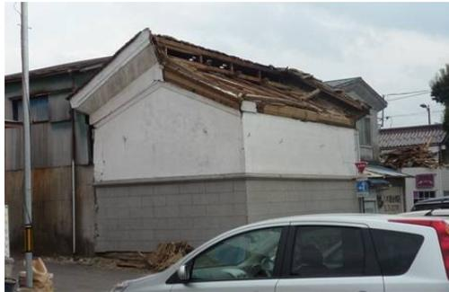
写真 54 屋根だけが崩壊した土蔵
