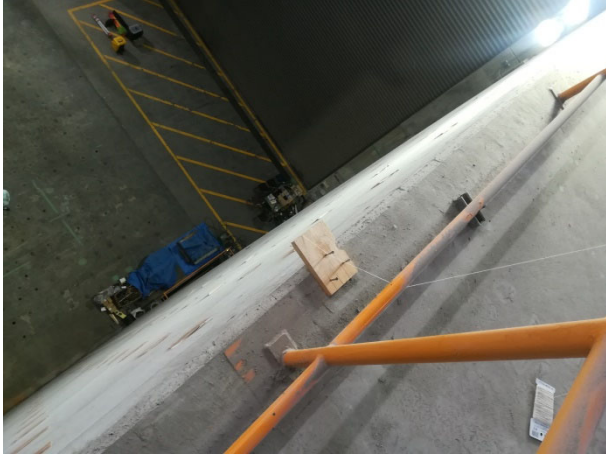
図 A3.4 下げ振りの設置状況
