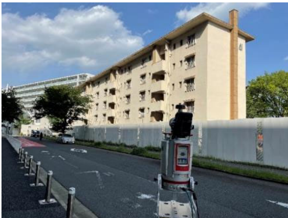
写真 A6.1 対象建築物外観と用いた計測装置
