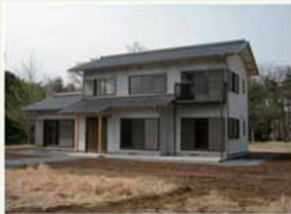
写真1 実験用建て住宅 (建築研究所)
