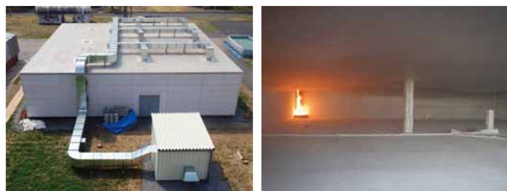
■ 写真2 建築研究所に建設された煙実験装置（左：全景、右：煙が180㎡の室内を広がる様子）
