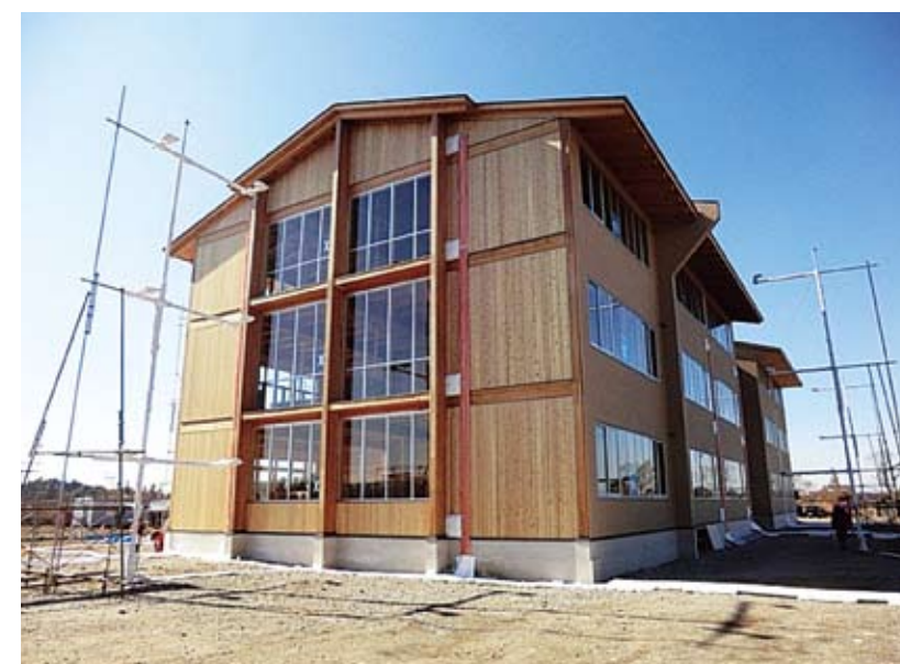
写真2 火災実験のために建てられた木造3階建て学校
