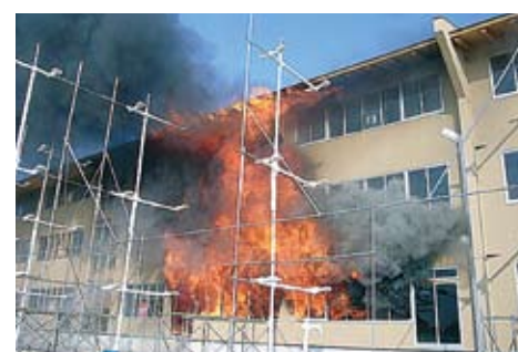
■写真4 噴出火災による上階延焼(6分後)
