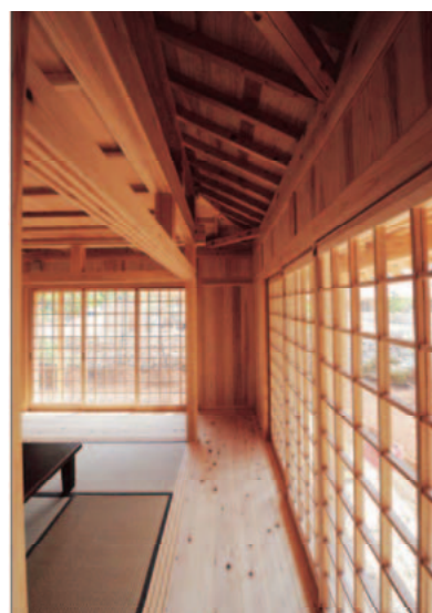
■写真2 かたあきの里の各棟は、十分な通風を常時確保するため、鍵のかかる網戸を備えた格子戸を開閉口に備えている。
