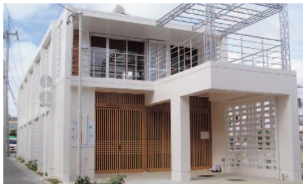
写真3 間口の狭い市街地内の敷地にあわせて建設された「エコハウス：市街地型」
