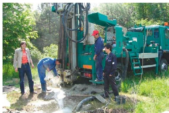
■写真4 ボーリングマシンによる地盤調査
