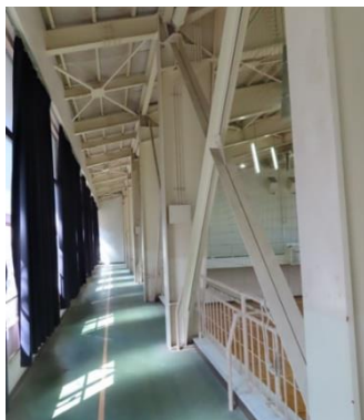
写真 5.5-147 第二体育館 山形鋼ブレ ース (2丁合わせ)
