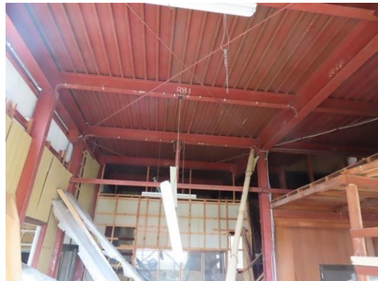
写真 5.5-71 柱梁接合部の状況
