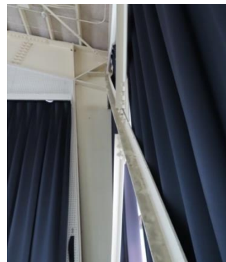
写真 5.5-148 第二体育館 山形鋼ブ レース (1丁)
