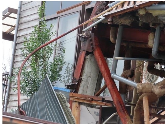
写真 5.5-8 1階の山形鋼ブレース
