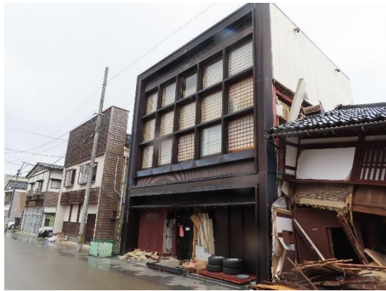
写真 5.5-90 隣接建築物との衝突
