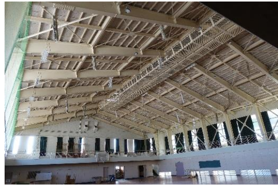
写真 5.5-144 第二体育館 内観
