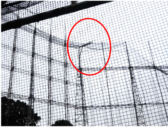
写真-8.7.2.16 先端部の被害状況(2) (南側)
