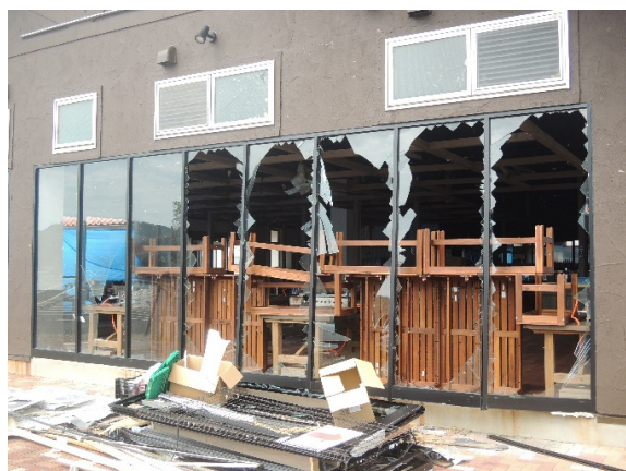
写真-8.4.2.1 屋外に面する建具の損壊(1)
