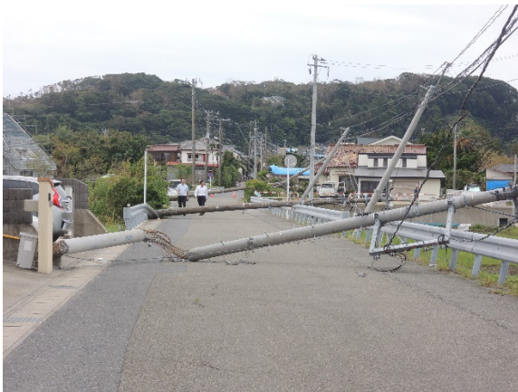
写真-8.4.2.13 電柱の折損
