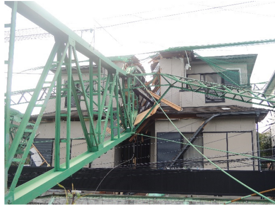
写真-8.7.1.11 近隣の住宅の被害(1)
