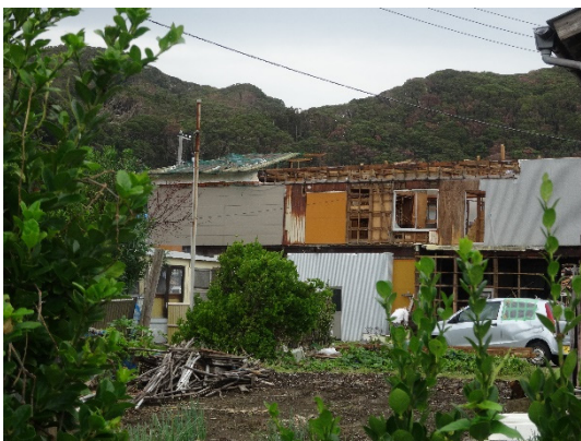
写真-8.4.2.37 木造住宅の屋根と外壁の被害
