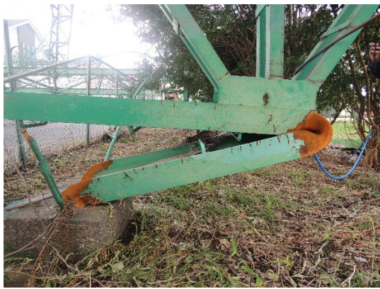
写真-8.7.1.6 鉄柱を構成する H形鋼の変形(2)
