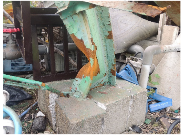
写真-8.7.1.5 鉄柱を構成する H形鋼の変形(1)
