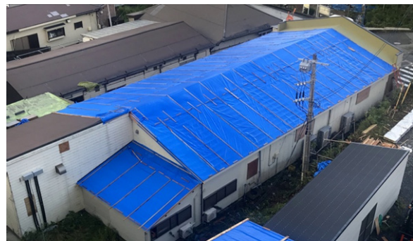
写真-8.5.1.24 ブルーシートで覆われた 店舗 A の屋根(2)
