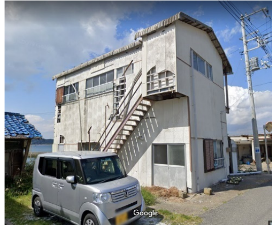
写真-8.4.3.16 漁港施設 A の被災前の状況*
