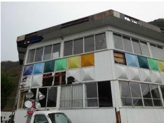
写真-8.4.2.15 公園施設 A の外壁・軒天井の被害状況
