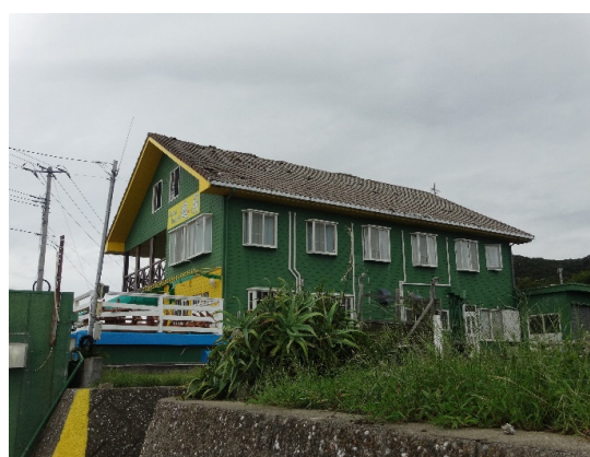
写真-8.4.2.26 屋根瓦の被害(風下側)
