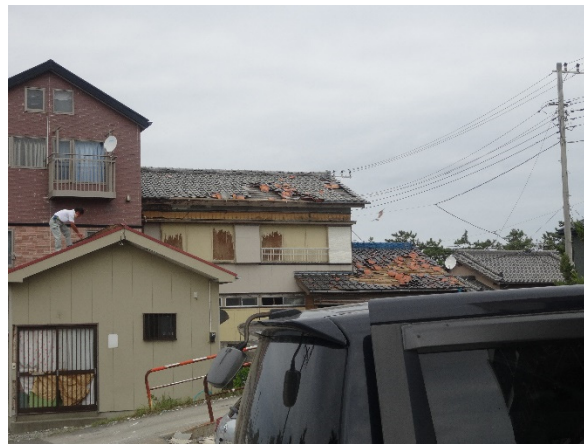
写真-8.4.3.8 隣接する住宅での瓦の被害
