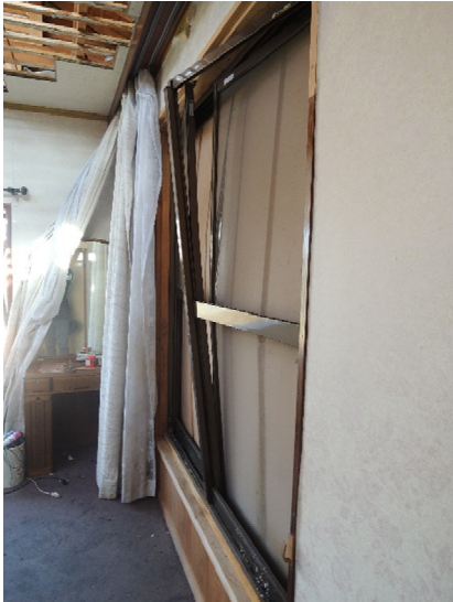
写真-8.6.1.37 室内側に変形した雨戸と サッシ
