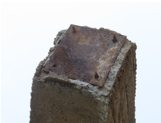
写真-8.7.2.4 ベースプレートと アンカーボルト(1)
