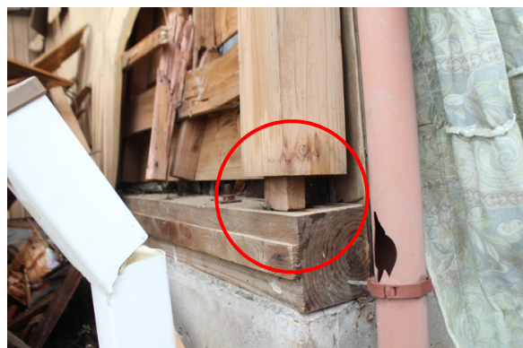
写真-8.6.1.12 抜け出した柱のほぞ
