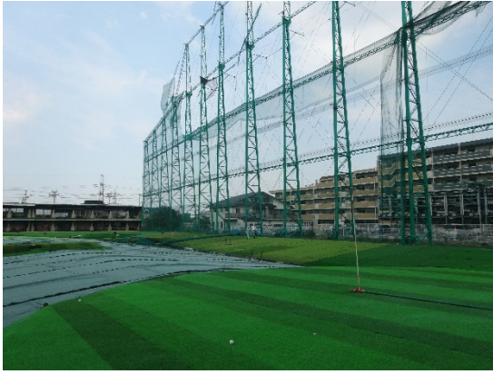
写真-8.7.1.10 敷地をはさんで倒壊した鉄柱の反対側にある鉄柱の状況
