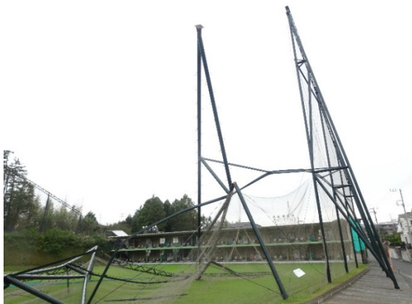
写真-8.7.2.2 鉄柱の倒壊状況(2)
