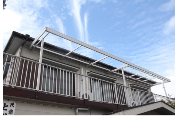
写真-8.5.1.43 住宅の底の被害
