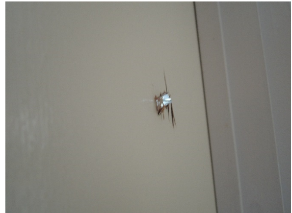
写真-8.4.1.21 窓ガラス破片のドアへの貫通（廊下側から見る）
