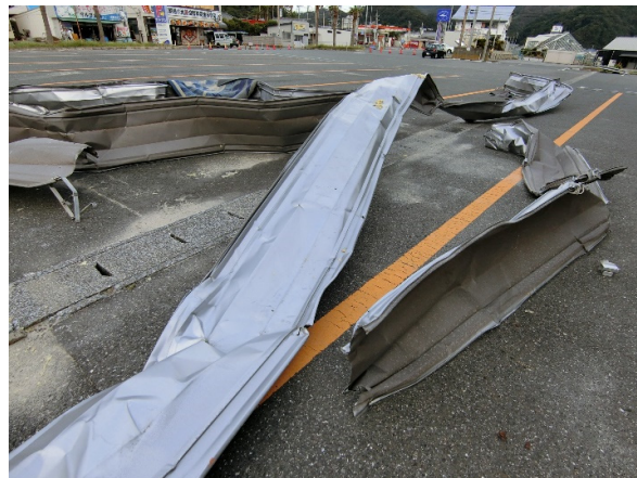
写真-8.4.1.2 飛散した屋根ふき材
