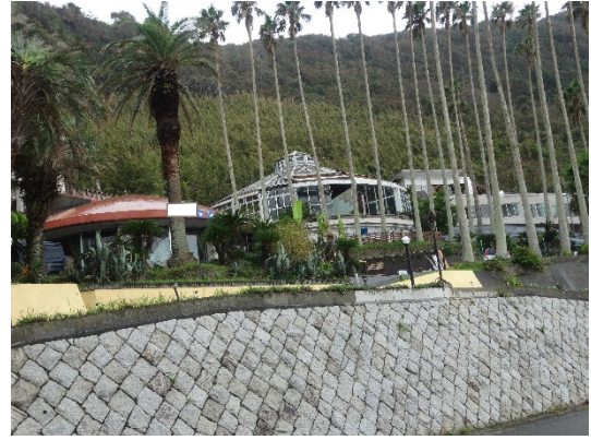
写真-8.4.2.18 宿泊施設 A の屋根・ 窓ガラスの被害状況
