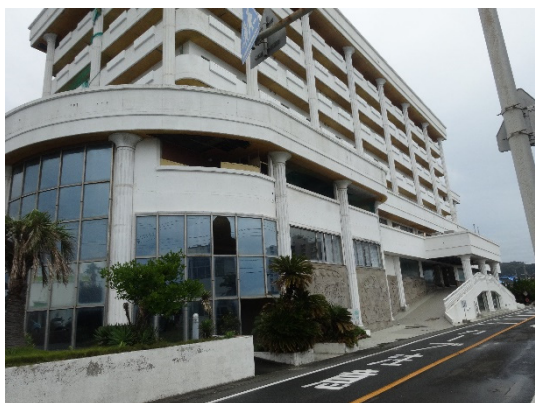
写真-8.4.2.21 屋根・軒天井の被害 (被災後)
