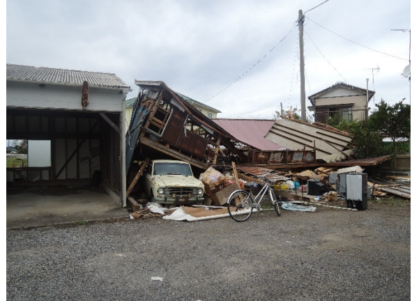
写真-8.4.2.12 老朽化した倉庫の倒壊
