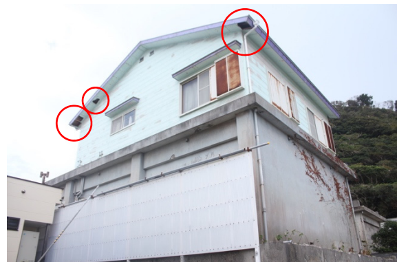
写真-8.5.2.17 住宅の軒被害
