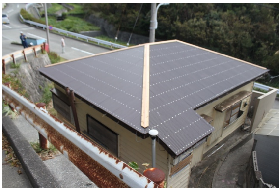
写真-8.5.1.45 応急的な処置をした住宅の屋根
