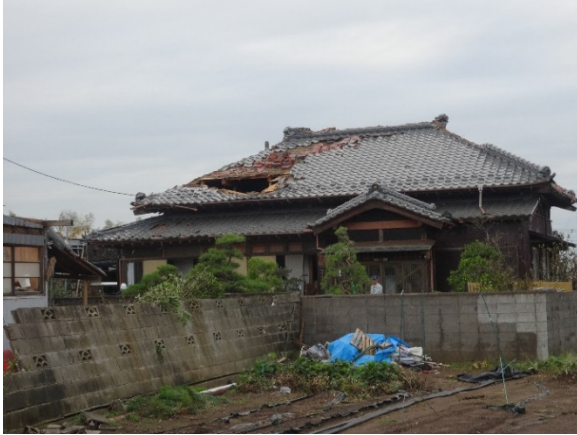
写真-8.6.1.48 住宅 K の屋根の状況 (南東側)
