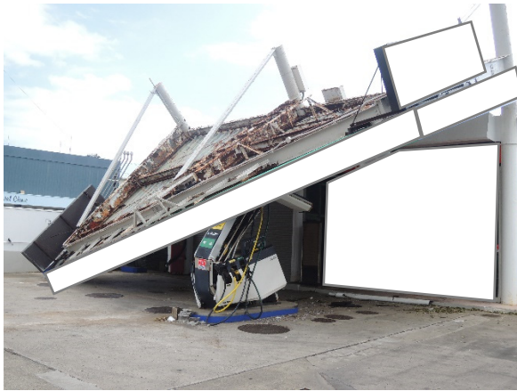
写真-8.4.3.19 キヤノピーの落下
