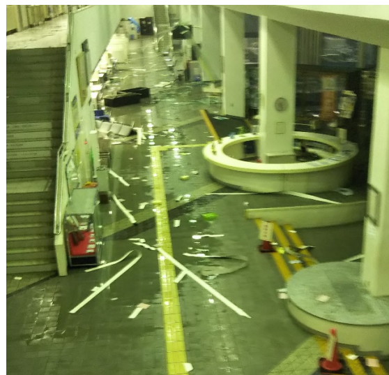
写真-8.3.5 第2庁舎南面入り口付近の被災直後の状況(2) (市原市提供)
