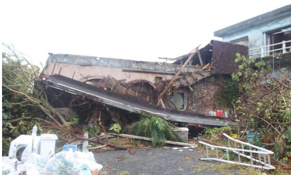
写真-8.5.2.24 倒壊した店舗 D
