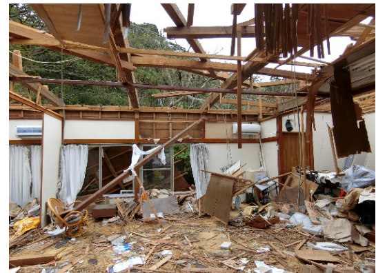
写真-8.4.3.57 宿泊施設 H の屋根の飛散
