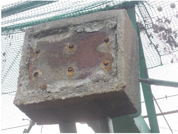
写真-8.7.1.4 柱脚アンカーボルト の破断(2)
