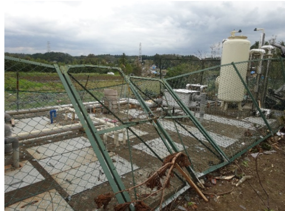
写真-8.6.2.10 フェンスの倒壊
