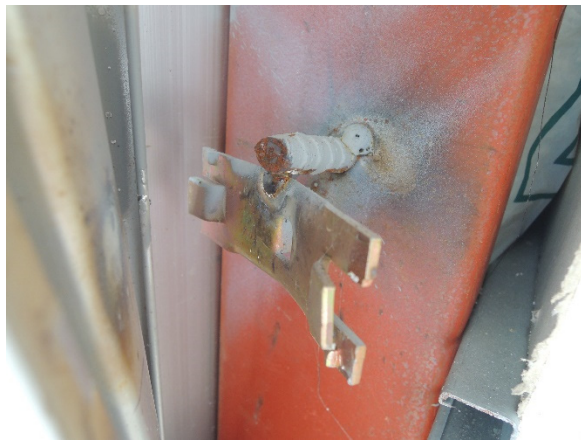
写真-8.4.3.11 建具と鋼製支持部材との接合部(1)
