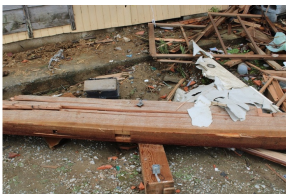
写真-8.6.1.11 落下した梁
