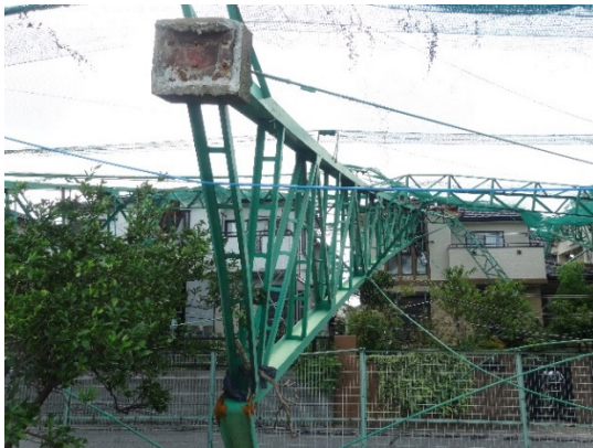
写真-8.7.1.8 隣接する住宅への倒壊状況
