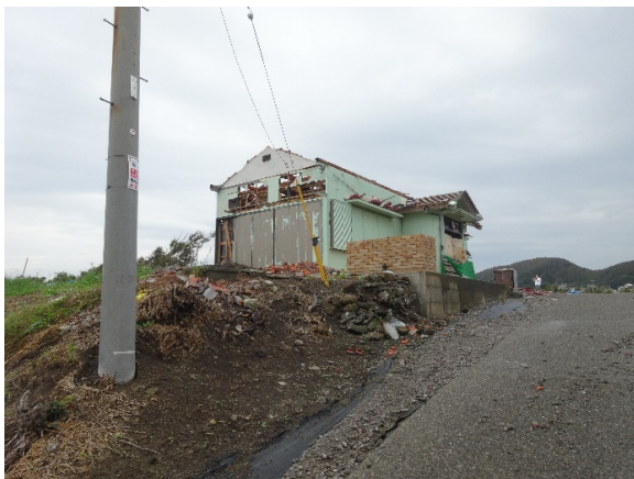
写真-8.4.2.32 屋根と外壁の被害
