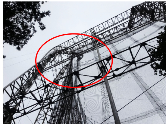
写真-8.7.2.19 先端部の変形 (北側の鉄柱)
