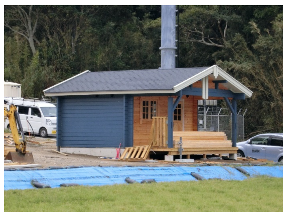
写真-8.4.3.59 被害が軽微であった ログハウス
