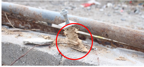
写真-8.5.1.38 土台の蟻害
