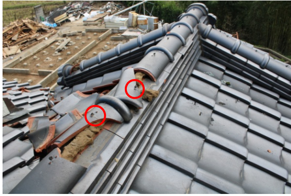
写真-8.6.1.27 棟瓦の割れ（丸印は銅線）
