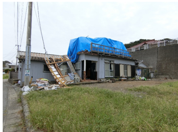
写真-8.4.3.44 南西へ壁が脱落した 2階建て木造住宅
