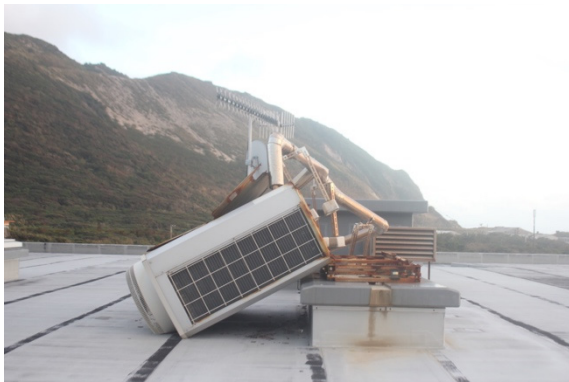
写真-8.5.2.42 西から東に転倒した 介護施設の室外機
