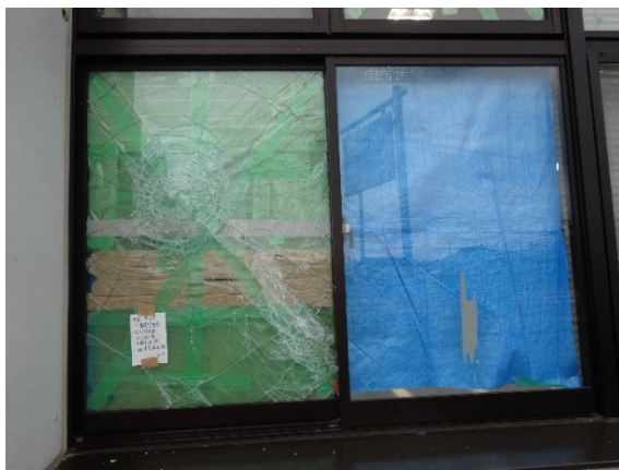
写真-8.6.2.15 窓ガラスの被害と養生状況
