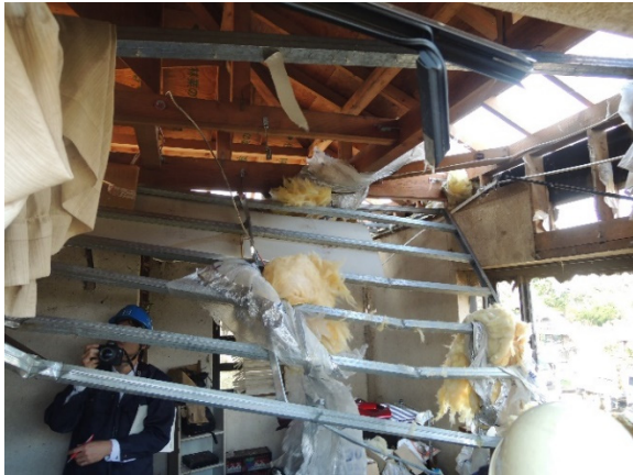
写真-8.6.1.45 天井材の落下
