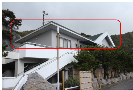
写真-8.5.1.55 温泉施設の屋根被害
