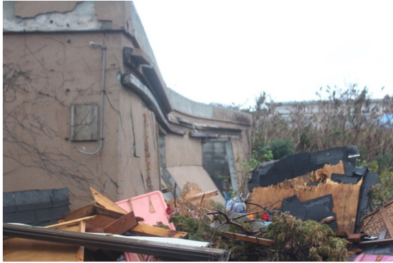
写真-8.5.2.22 倒壊した倉庫 B
