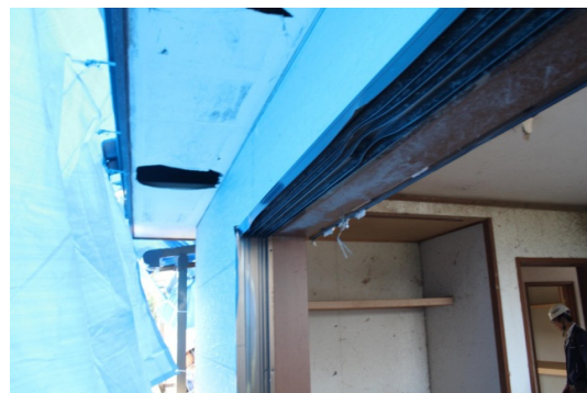
写真-8.6.1.26 2 階南側の窓と軒天井
