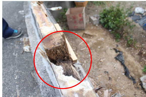
写真-8.5.1.28 ゴミ捨て場の土台の 腐朽・蟻害
