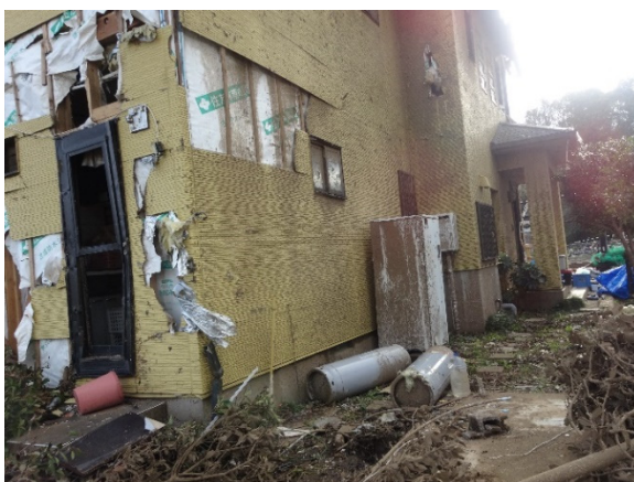
写真-8.6.1.41 外壁材の剥離 (北側)
