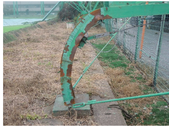
写真-8.7.1.7 鉄柱を構成する H形鋼の変形(3)
