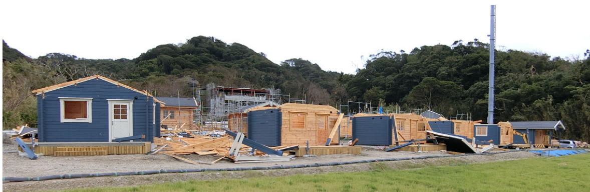
写真-8.4.3.58 建築途中の 12 棟のログハウスの被害状況
