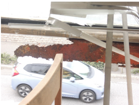
写真-8.4.3.7 腐食によって板厚が減少した鋼製部材
