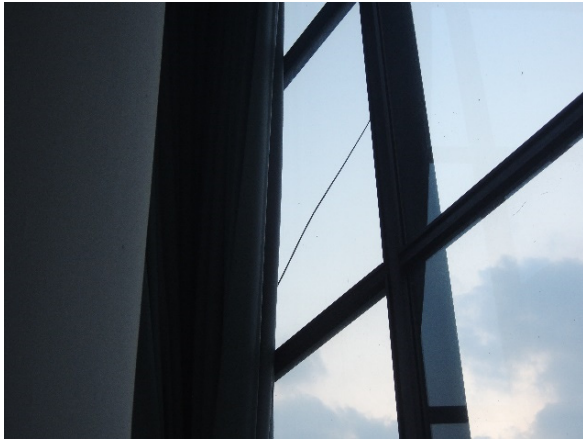
写真-8.3.12 議会棟ラウンジの ガラスのひび割れ
