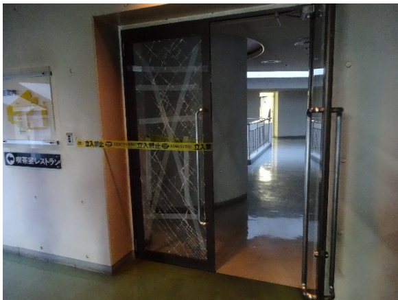
写真-8.3.10 議会棟入り口の扉の損傷
