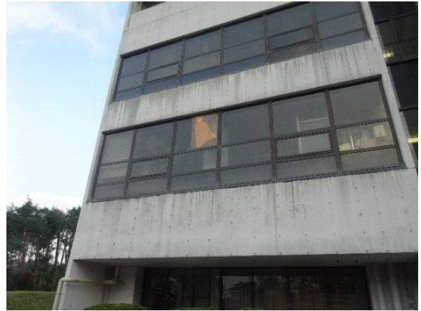
写真-8.3.7 第2庁舎西面での ガラスの破損
