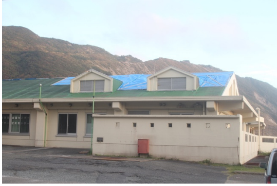
写真-8.5.2.40 介護施設の屋根被害 (建物南東面)
