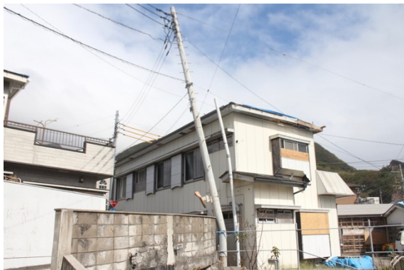
写真-8.5.1.40 住宅の屋根被害と 折れた電柱
