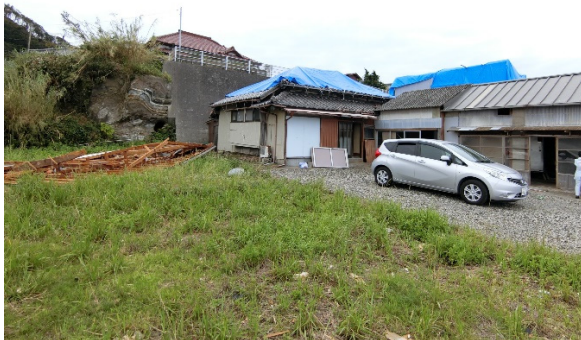
写真-8.4.3.43 北西へ吹き飛んだ 木造住宅の屋根
