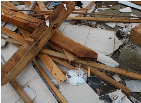
写真-8.4.1.24 木造倉庫に用いられていた筋かい
