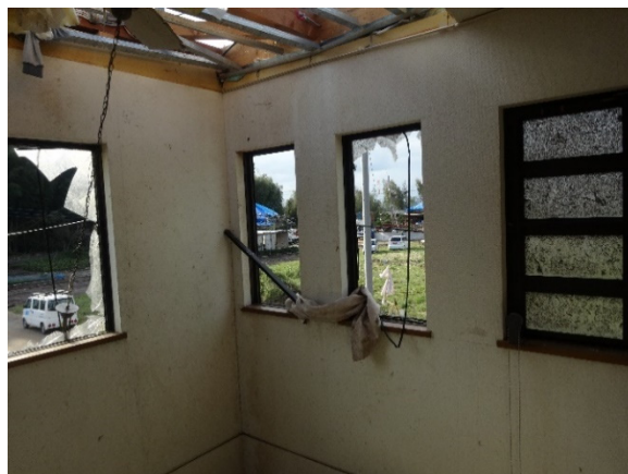
写真-8.6.1.44 吹き抜けでのガラス の破損
