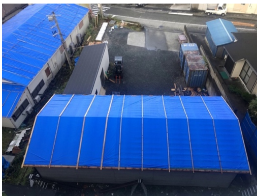
写真-8.5.1.33 補修された宿泊施設 A の倉庫
