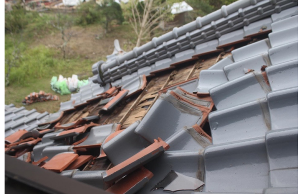
写真-8.6.1.20 屋根瓦の脱落
