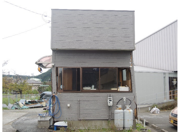
写真-8.4.1.10 小規模木造建築物の 残留変形
