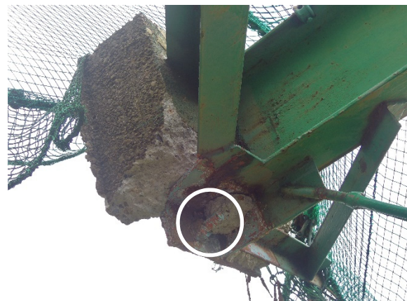
写真-8.7.1.3 柱脚アンカーボルトの破断(1)
