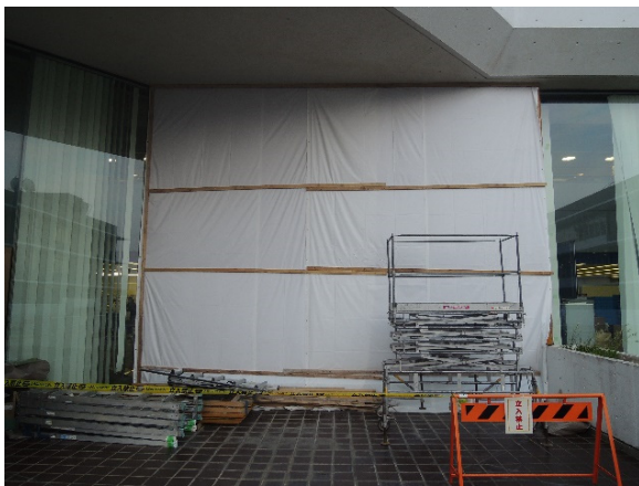
写真-8.3.2 第2庁舎南面入り口付近で破損したガラスの応急復旧状況(屋外側)
