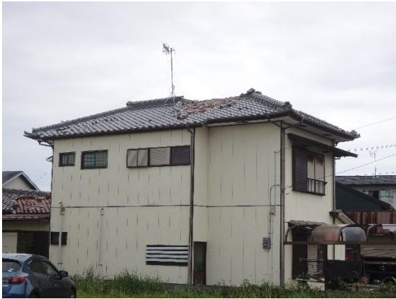
写真-8.4.2.11 木造住宅の棟瓦の脱落
