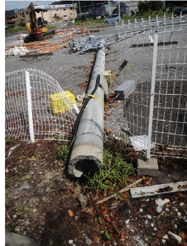
写真-8.4.2.8 電柱の折損
