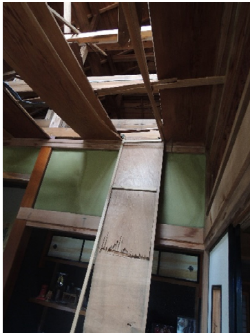
写真-8.6.1.54 室内側の被害(2)
