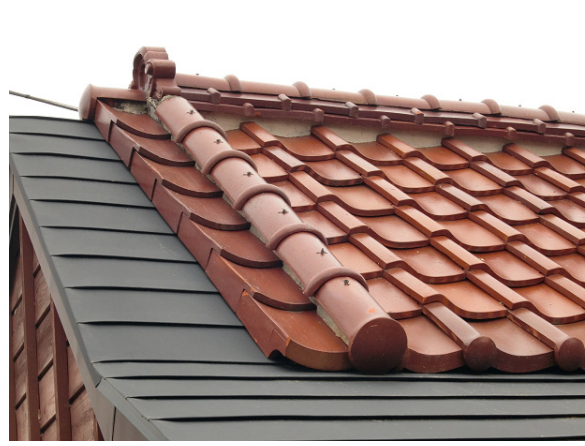
写真-8.4.3.36 緊結され、無被害であった 隅棟部の瓦
