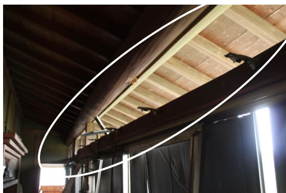
写真-8.6.1.15 脱落した欄間
