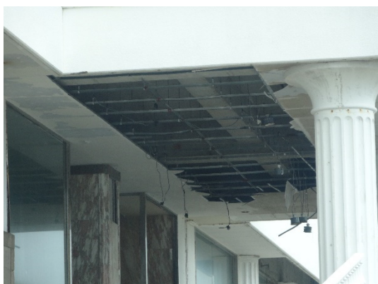
写真-8.4.2.23 エントランスの軒天井の被害
