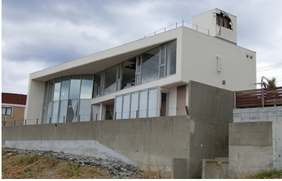
写真-8.4.3.71 海岸側の窓ガラスの破損
