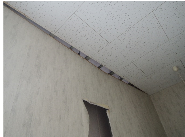
写真-8.4.1.19 階段室の壁材の変形
