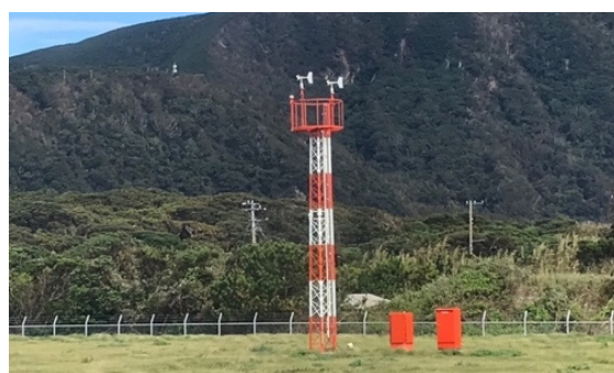
写真-8.5.2.2 新島空港の風速計（北側）
