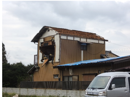
写真-8.6.1.57 北東側の外壁の損壊と北西側の屋根での野地板の飛散状況
