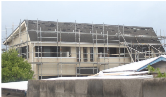
写真-8.5.2.14 住宅の屋根被害
