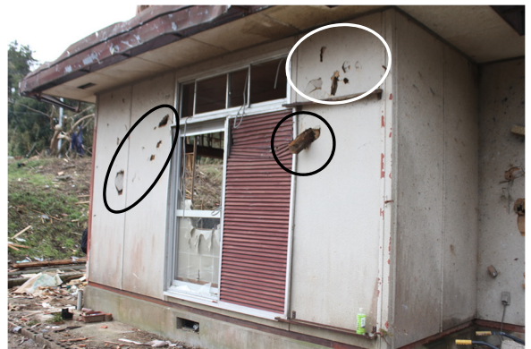
写真-8.6.1.6 飛来物の衝突や貫通 （東面 1F）
