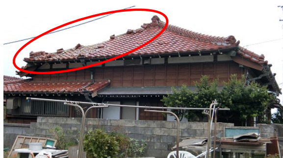
写真-8.4.3.31 寄棟における隅棟部の瓦の落下
