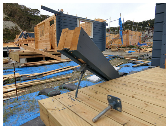
写真-8.4.3.60 オーバーハングの屋根を 支える柱の脚部
