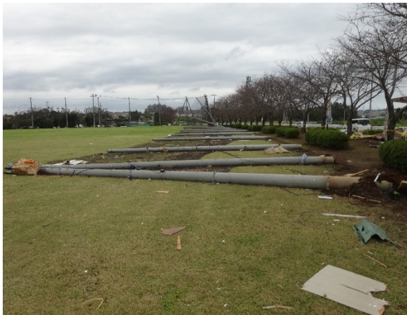
写真-8.6.3.18 コンクリート柱の倒壊状況
