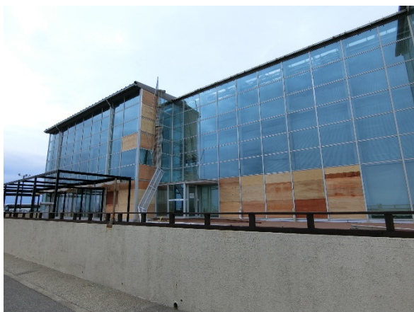
写真-8.4.1.1 破損した窓ガラスの状況
