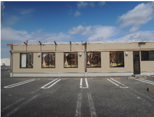
写真-8.4.2.5 小屋組が飛散した 店舗 F の外観
