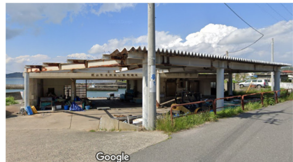
写真-8.4.3.18 建屋の被災前の状況*
