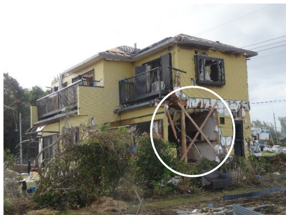
写真-8.6.1.40 住宅 J の外観 (2) (東側)
