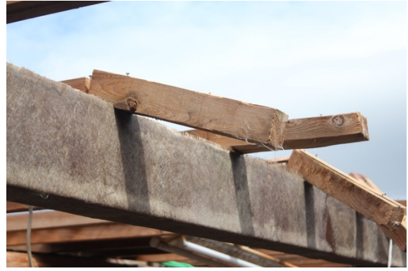
写真-8.5.1.13 木造の元造船所 B の FRP で覆われた横架材と垂木
