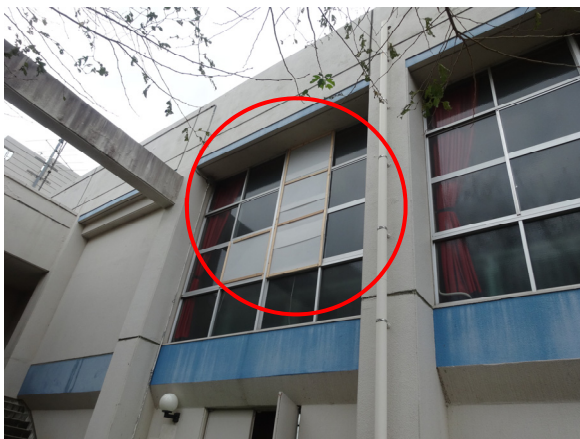
写真-8.6.2.7 体育室の破損した窓ガラス
