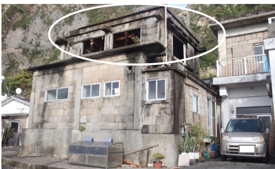
写真-8.5.2.34 住宅の屋根被害(1)
