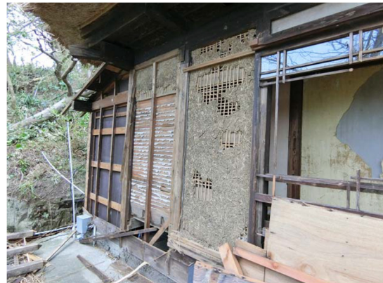
写真-8.4.3.55 写真-8.4.3.54 の住宅の外壁の被害
