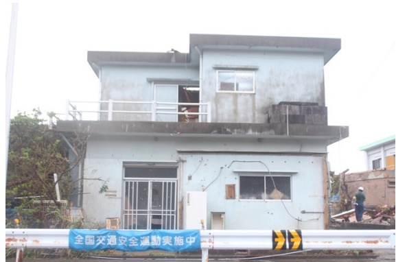
写真-8.5.2.25 住宅の屋根被害
