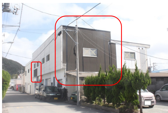
写真-8.5.2.8 住宅の外壁被害の 応急的な補修
