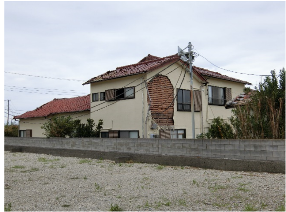
写真-8.4.3.38 モルタル外壁が剥落した 宿泊施設 E
