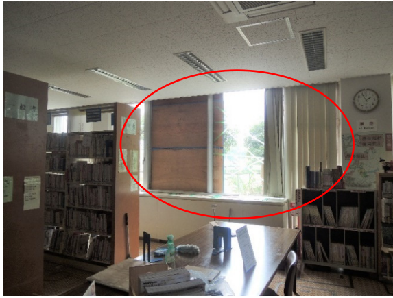
写真-8.6.2.3 写真-8.6.2.2 に示す ガラスの養生状況
