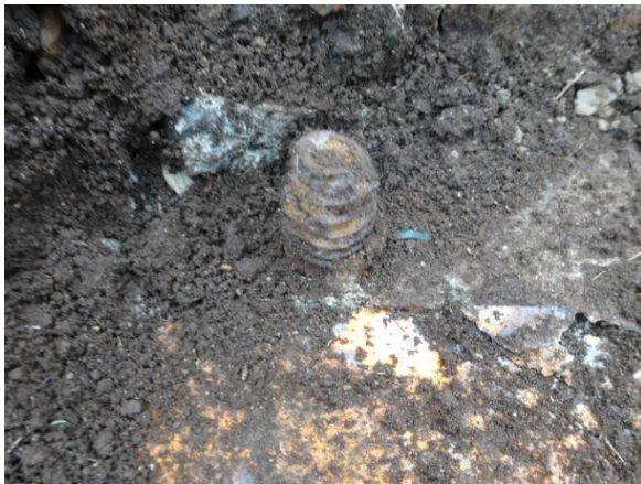
写真-8.7.2.8 破断したアンカーボルト
