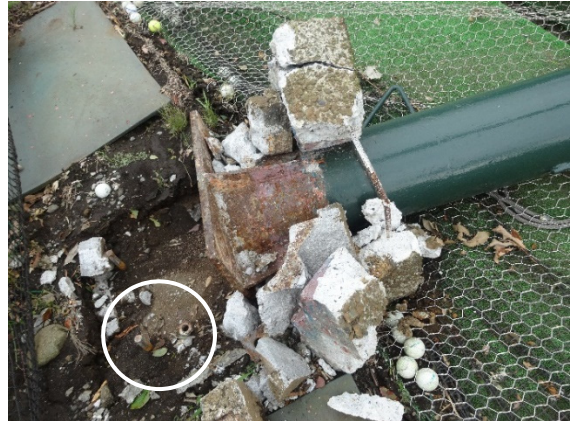
写真-8.7.2.7 柱脚のコンクリートの破壊 (丸印は写真-8.7.2.6のアンカーボルト)
