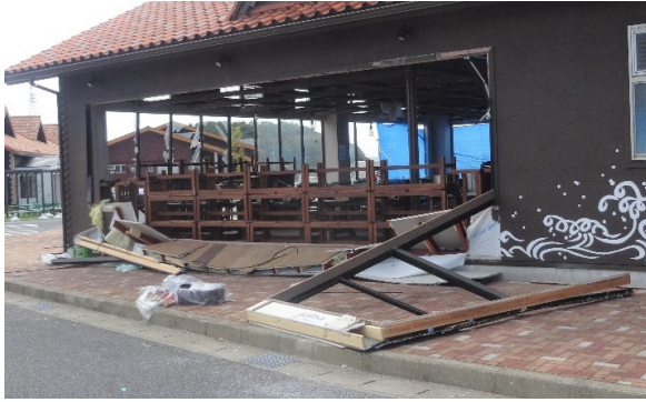
写真-8.4.2.3 屋外に面する建具の損壊と 腰壁の転倒
