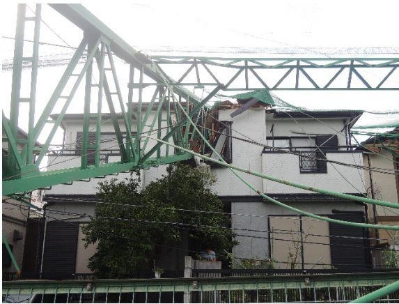
写真-8.7.1.12 近隣の住宅の被害(2)
