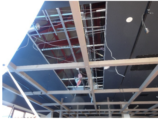
写真-8.4.2.4 屋内の天井仕上げ材の被害
