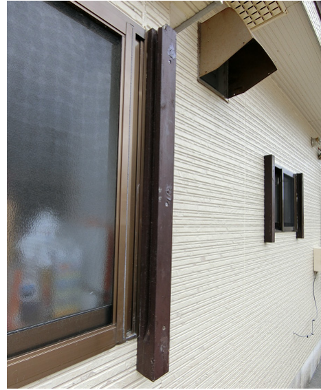
写真-8.5.1.22 開口部の防御板の受け材
