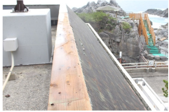
写真-8.5.1.57 屋根ふき材の飛散によって露出した下地材
