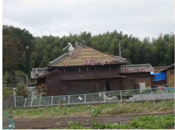
写真-8.6.1.49 住宅 K の屋根の状況 (北東側)
