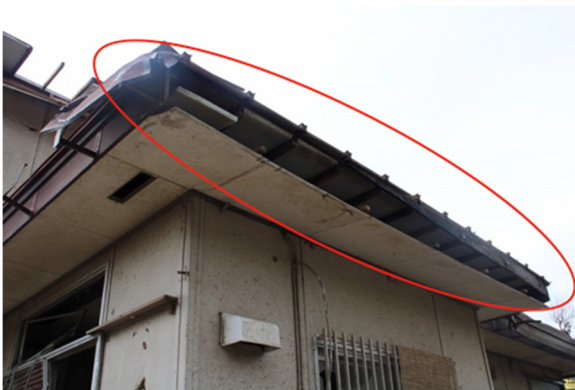
写真-8.6.1.5 屋根軒先部の損傷状況
