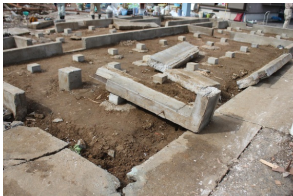
写真-8.6.1.31 残った無筋基礎 （南東側で折損）
