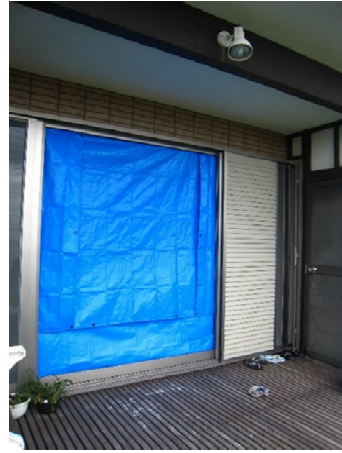
写真-8.4.3.75 写真-8.4.3.74 の1階の 掃き出し開口
