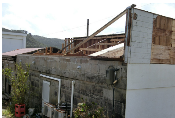
写真-8.5.2.11 店舗Cの屋根の被害
