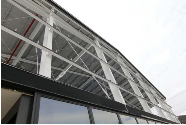
写真-8.4.1.13 外壁材の留め付け部分
