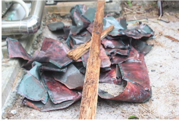
写真-8.5.1.56 脱落した屋根ふき材
