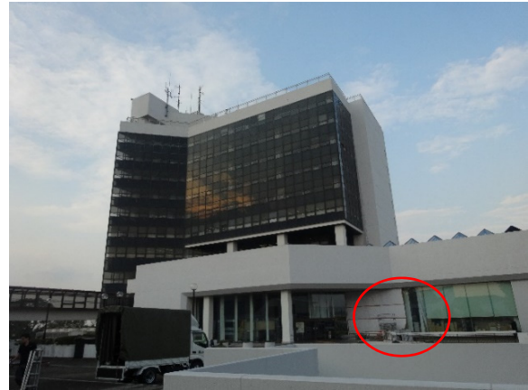
写真-8.3.1 第2庁舎の外観
