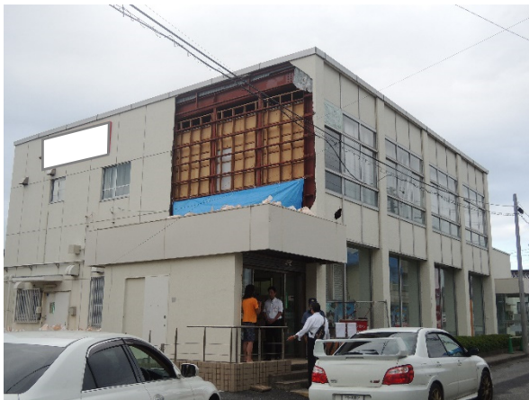
写真-8.4.1.7 店舗Cの外壁の被害状況
