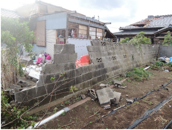
写真-8.6.3.12 ブロック塀の被害(1)
