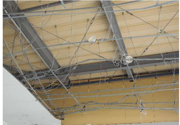
写真-8.4.3.2 軒天井の鋼製下地材の状況
