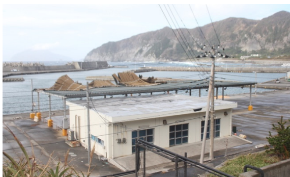
写真-8.5.2.30 漁港施設 A の屋根被害
