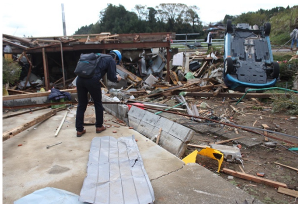
写真-8.6.3.3 飛散した車庫 A と転覆した自動車 (北面から)
