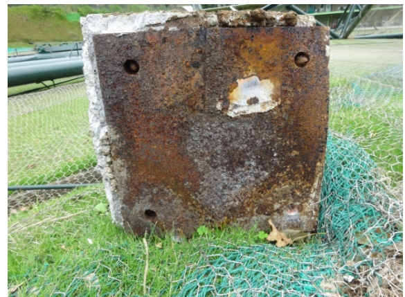
写真-8.7.2.5 ベースプレートと アンカーボルト(2)
