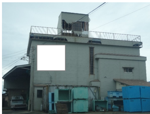
写真-8.4.2.29 塔屋の被害
