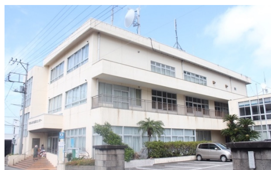
写真-8.5.2.3 新島村住民センターの屋上に設置されている風速計
