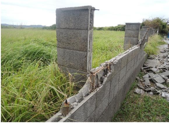
写真-8.4.3.25 ブロック塀の倒壊
