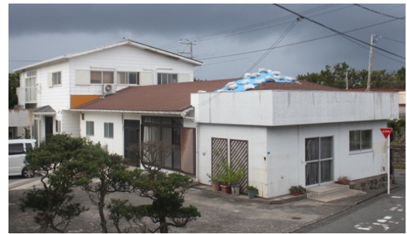
写真-8.5.2.15 住宅兼作業場の屋根被害
