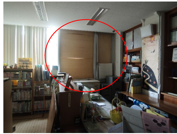
写真-8.6.2.6 台風第15号の強風で 破損した窓ガラスの範囲
