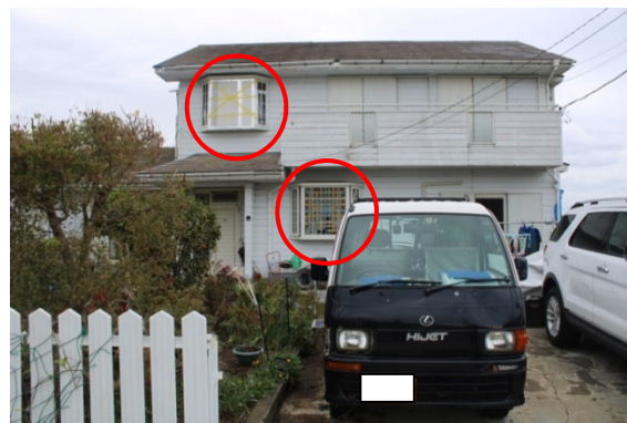
写真-8.6.1.24 南面の窓の被害
