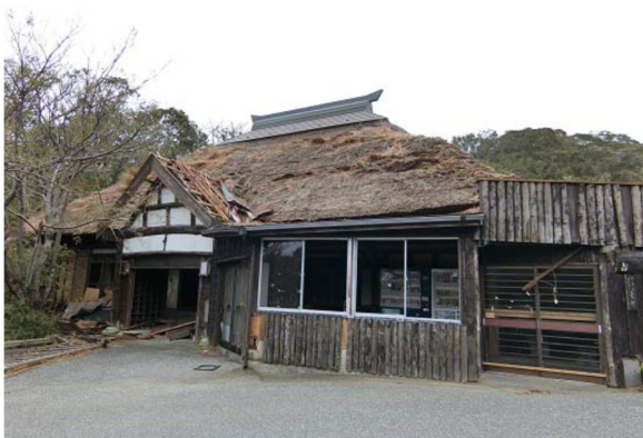
写真-8.4.3.54 茅葺き屋根の古民家の外観
