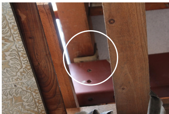
写真-8.6.1.7 小屋組のL型金物
