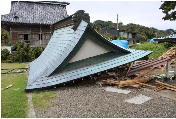
写真-8.4.3.48 倉庫の倒壊
