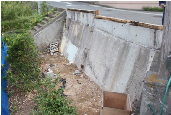
写真-8.5.1.27 倒壊して撤去された ゴミ捨て場の跡
