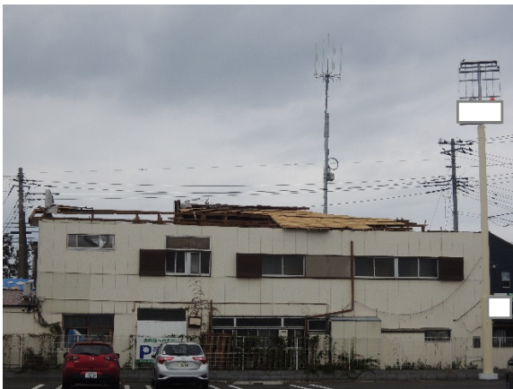
写真-8.4.2.9 店舗 G の小屋組の損壊(1)
