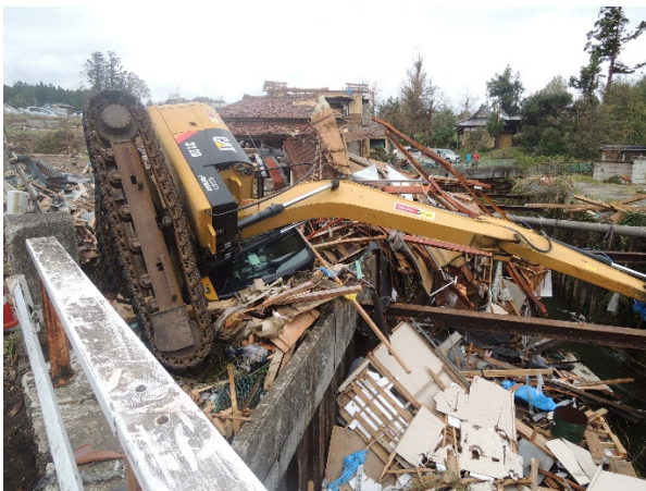
写真-8. 6. 3. 28 重機の被害
