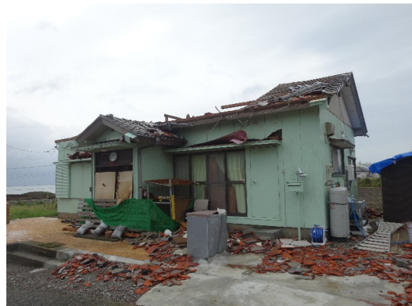
写真-8.4.2.33 屋根の被害状況
