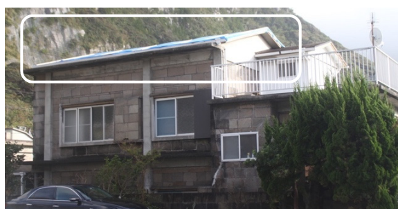
写真-8.5.2.35 住宅の屋根被害(2)
