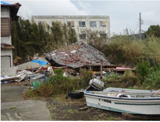
写真-8.4.2.34 倒壊した倉庫(被災後)
