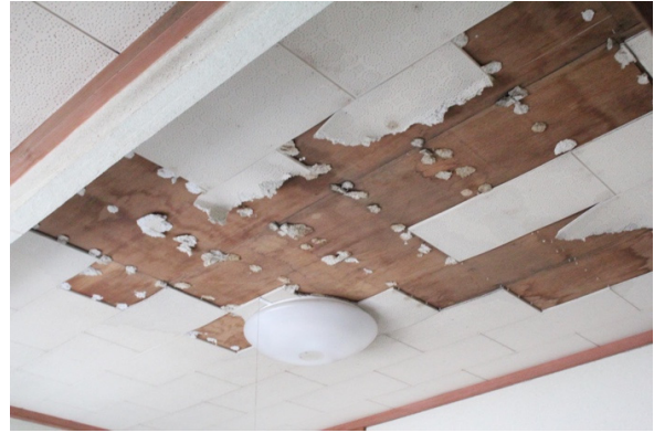
写真-8.6.1.18 天井の雨漏り被害
