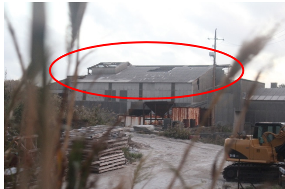
写真-8.5.2.43 工場の屋根と外壁の被害
