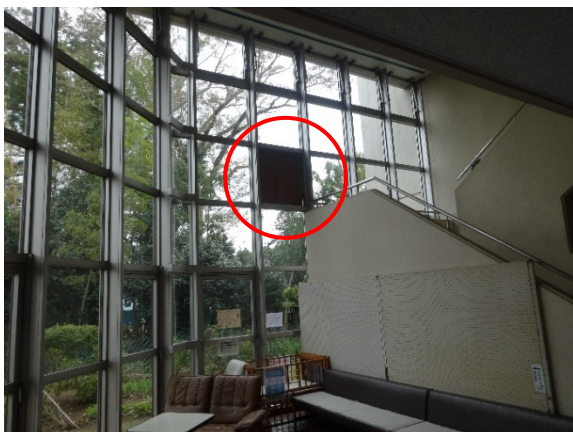
写真-8.6.2.1 破損した窓ガラスの状況
