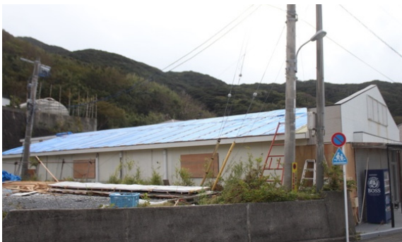
写真-8.5.1.23 ブルーシートで覆われた 店舗 A の屋根(1)
