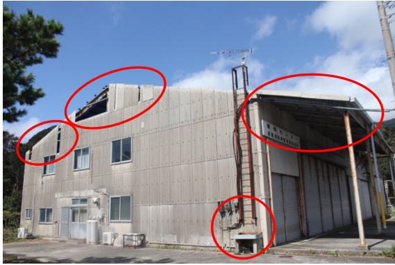
写真-8.5.2.4 空港の近くの工場の被害
