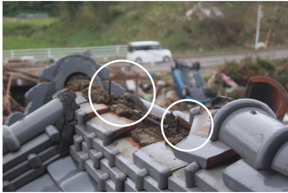
写真-8.6.1.19 鉄筋で留め付けられた棟瓦
