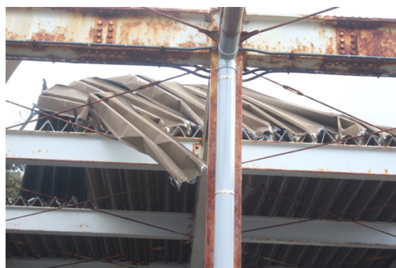
写真-8.5.2.33 風で捲れた屋根材
