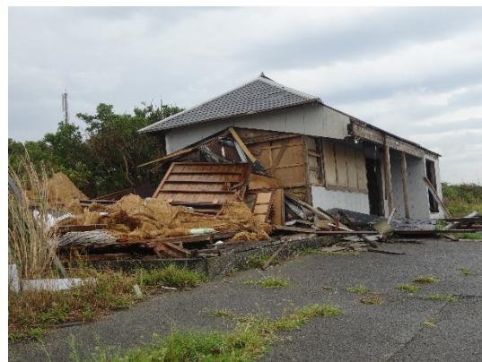
写真-8.4.2.38 木造住宅の上部構造の倒壊
