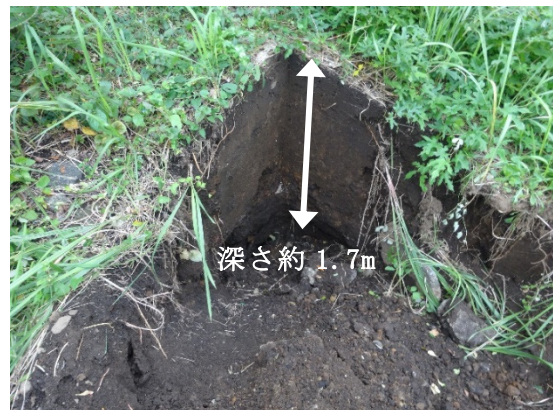
写真-8.7.2.11 柱脚の埋め込み跡
