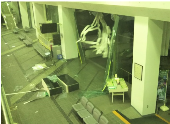
写真-8.3.4 第2庁舎南面入り口付近の被災直後の状況(1) (市原市提供)
