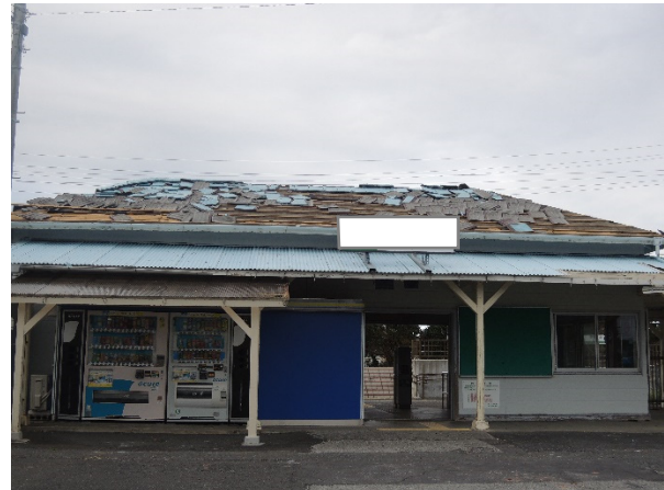
写真-8.4.1.8 駅舎での屋根瓦の被害
