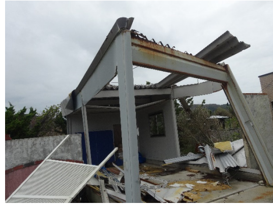
写真-8.4.2.40 軽量鉄骨造車庫の屋根の飛散と柱の倒壊
