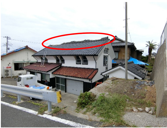
写真-8.4.3.35 最近改修したとみられる 瓦屋根の棟瓦の脱落
