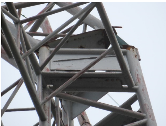
写真-8.7.2.20 被害部分の拡大写真(1) (北側の鉄柱)
