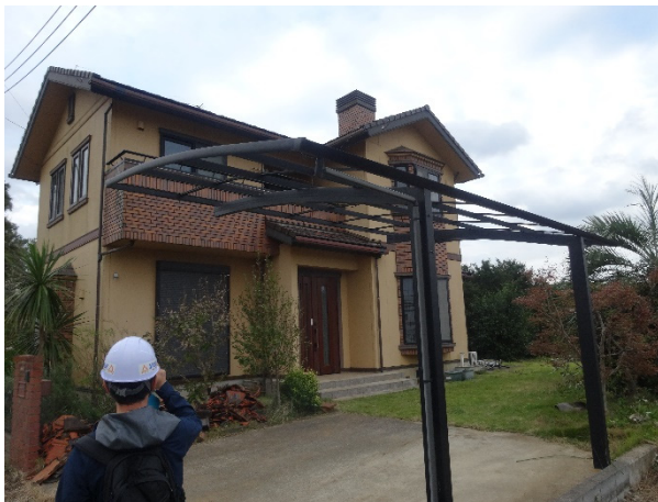
写真-8.6.3.22 カーポートの被害
