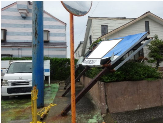
写真-8.4.2.41 看板の転倒(1)
