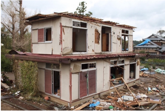
写真-8.6.1.1 住宅 A の外観（南西面）
