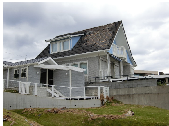
写真-8.4.3.73 屋根ふき材の脱落
