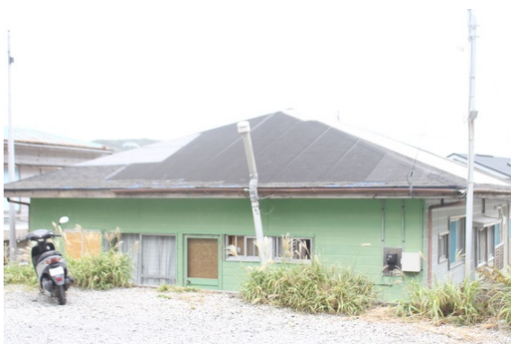
写真-8.5.1.51 屋根ふき材の被害
