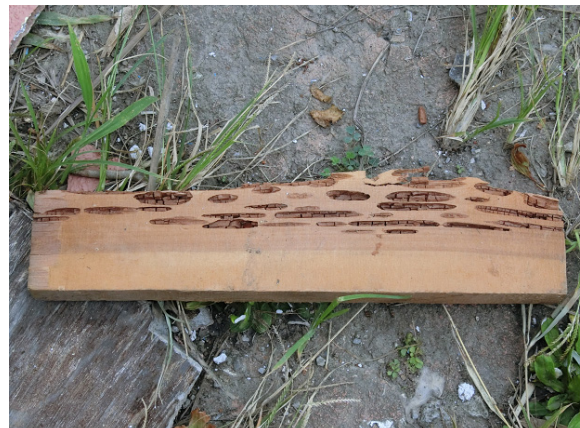
写真-8.4.3.66 写真-8.4.3.61 左側の住宅の蟻害を受けた部材
