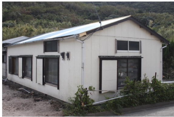
写真-8.5.1.32 屋根に被害を受けた住宅
