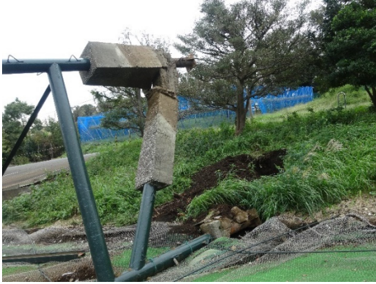
写真-8.7.2.12 写真-8.7.2.11の 引き抜け部分
