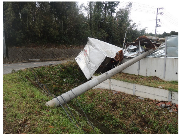
写真-8.6.3.23 電柱の折損
