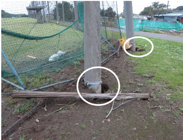
写真-8.6.3.20 支圧による柱のずれ
