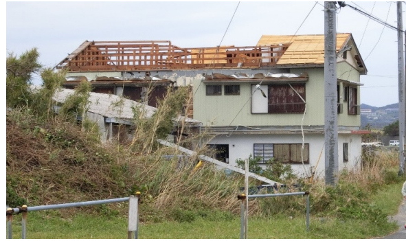
写真-8.4.3.42 小屋組の損傷状況
