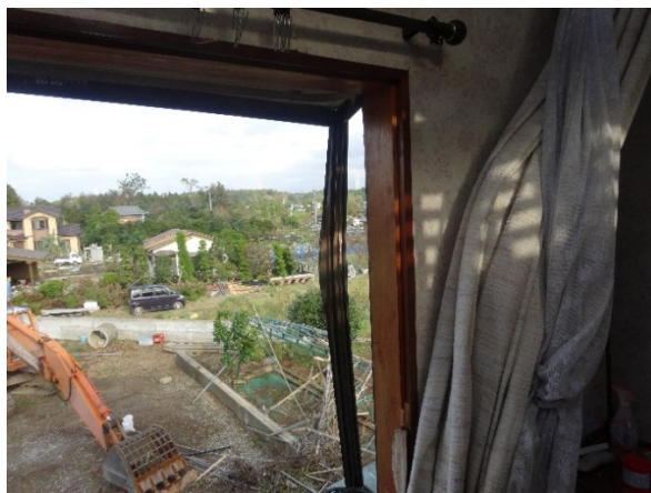
写真-8.6.1.36 サッシの変形
