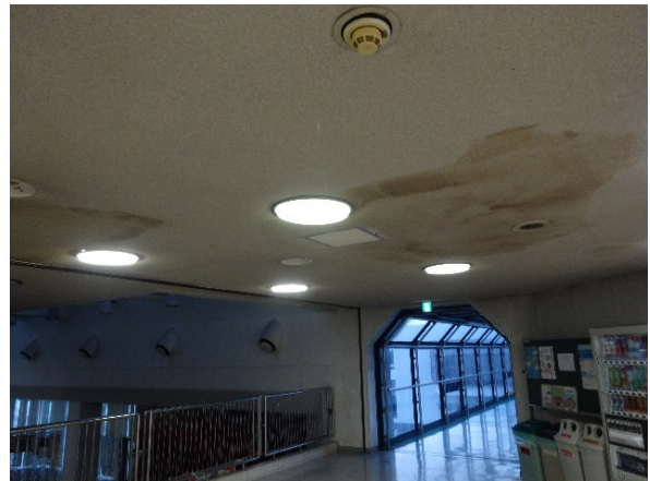
写真-8.3.9 天井の漏水痕
