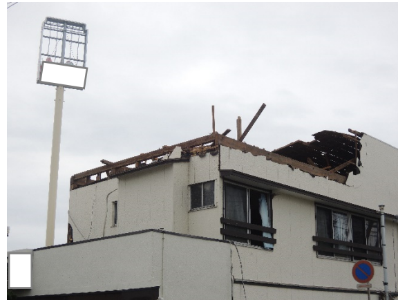
写真-8.4.2.10 店舗 G の小屋組の損壊(2)
