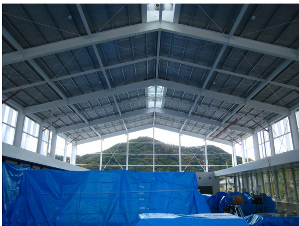
写真-8.4.1.15 店舗Dの内部の様子
