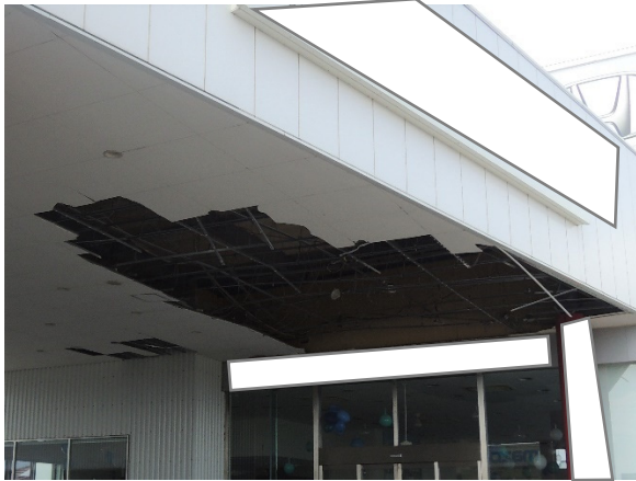
写真-8.4.3.1 店舗Hの軒天井の被害
