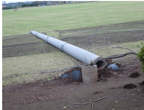
写真-8.6.3.19 柱の折損状況
