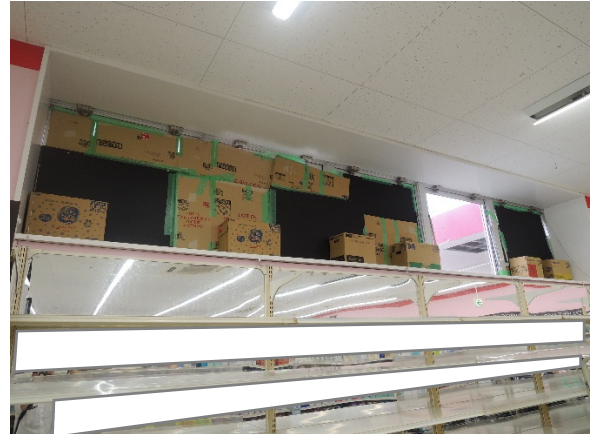
写真-8.4.1.6 破損したガラスの養生状況
