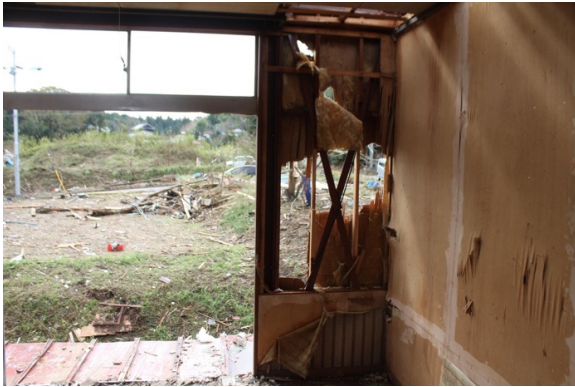
写真-8.6.1.3 窓ガラスや壁材が 飛散した室内の様子
