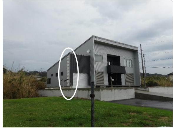
写真-8.4.2.31 住宅の隅角部での 被害状況(2)
