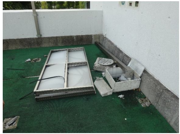
写真-8.3.13 屋外喫煙所の パーティションの倒壊
