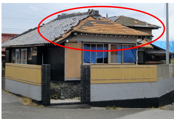
写真-8.4.3.29 寄棟の一面の瓦が全面的に落下した例
