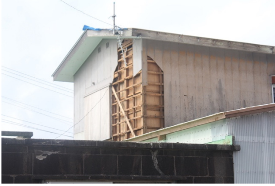
写真-8.5.2.12 店舗兼住宅の外壁被害
