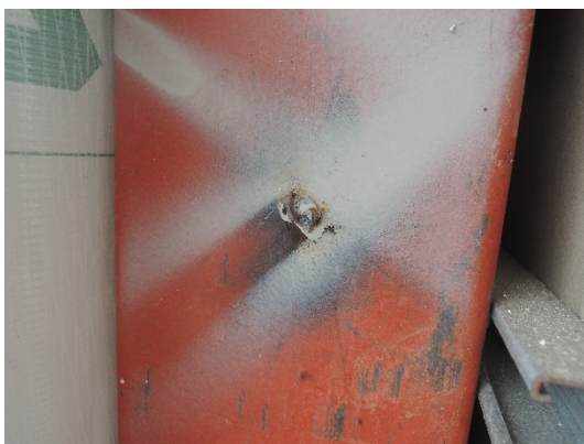
写真-8.4.3.13 建具と鋼製支持部材との接合部(3)
