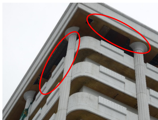
写真-8.4.2.24 最上階の軒天井の被害
