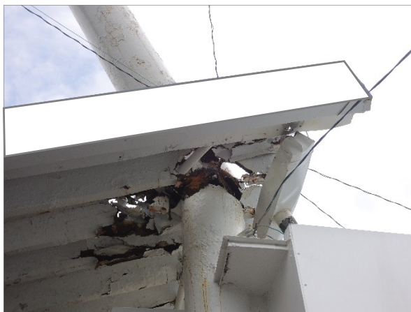
写真-8.4.3.21 キヤノピーを支持する 柱の折損(2)
