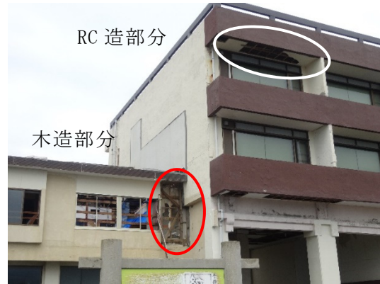
写真-8.4.2.20 外壁と軒天井の被害状況
