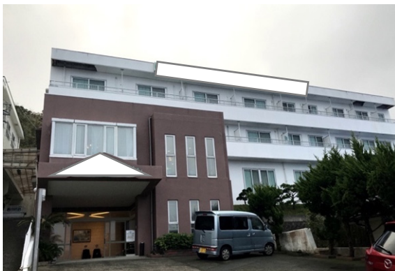
写真-8.5.1.29 軒下に被害を受けた 宿泊施設 A
