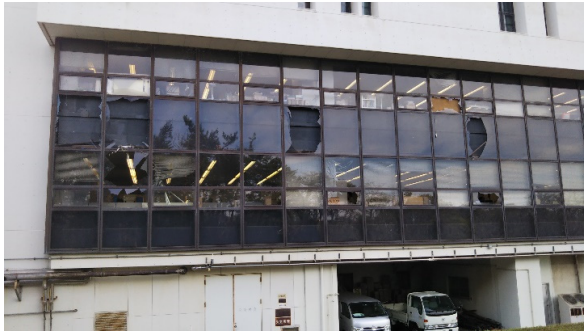
写真-8.3.6 第2庁舎北面での ガラスの破損（市原市提供）
