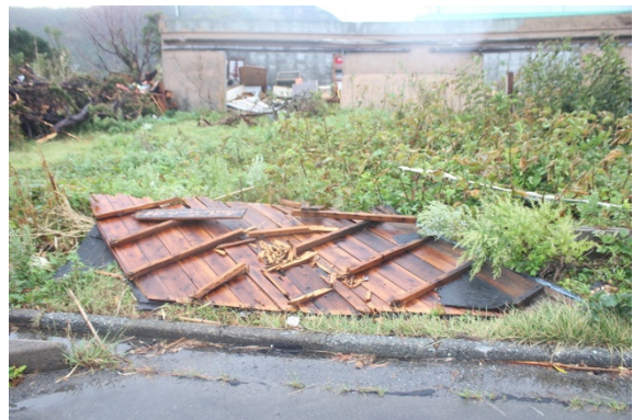
写真-8.5.2.27 飛散した屋根材
