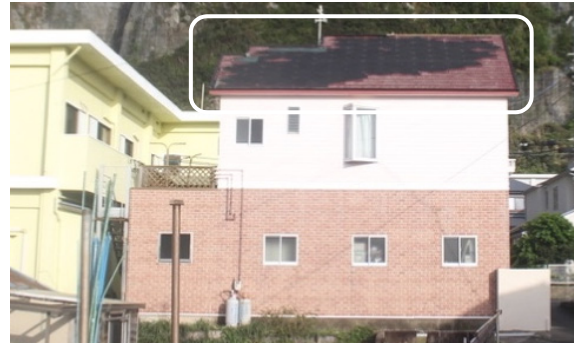
写真-8.5.2.37 住宅の屋根被害(4)
