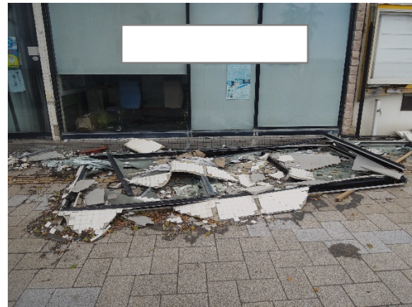
写真-8.4.3.4 建具の脱落
