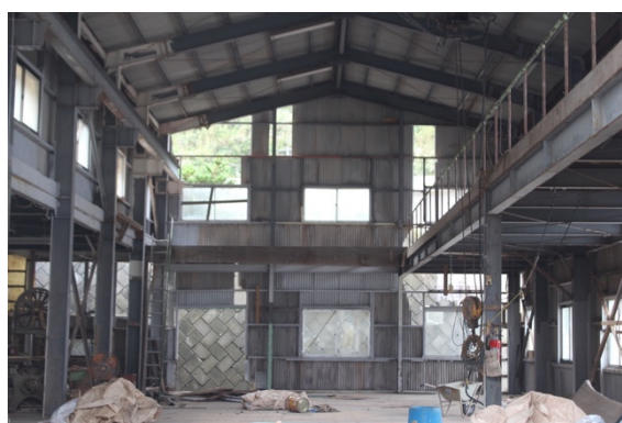
写真-8.5.1.9 鉄骨造の元造船所 A の被害（内部）
