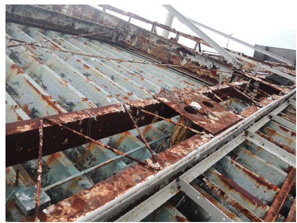
写真-8.4.3.22 キヤノピー上面の状況
