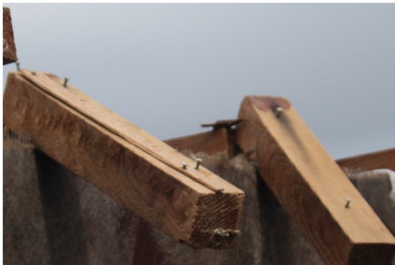
写真-8.5.1.14 屋根材を留め付けていた釘
