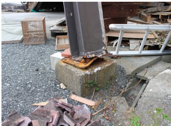
写真-8.4.1.26 鉄骨造倉庫の柱脚部
