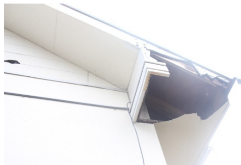
写真-8.5.2.29 写真-8.5.2.28 の住宅の 軒天井の被害
