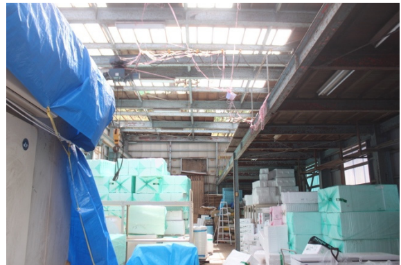
写真-8.5.1.15 鉄骨造の元造船所 C の被害
