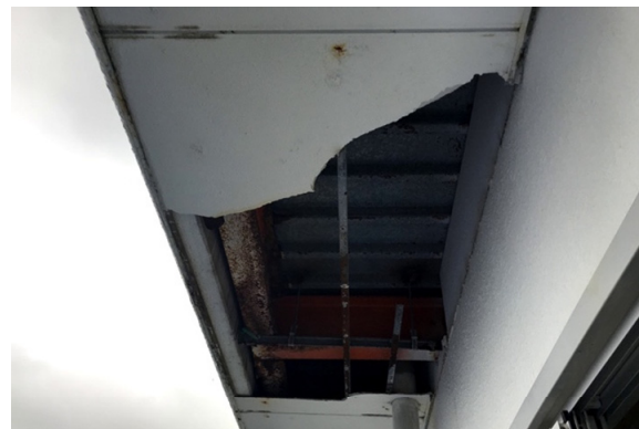
写真-8.5.1.30 宿泊施設 A の軒天井部材 の破損
