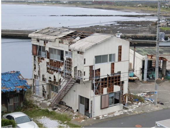
写真-8.4.3.15 漁港施設 A の外観
