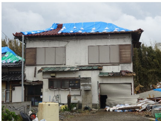
写真-8.4.2.36 倒壊した倉庫の隣の住宅
