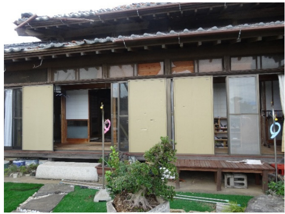
写真-8.6.1.51 住宅 K の壁面の被害 (南東側)
