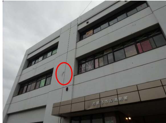
写真-8.6.2.14 外壁や窓ガラスの被害
