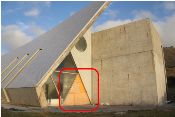
写真-8.5.2.38 西側の海岸に面する 美術館のガラスの破損
