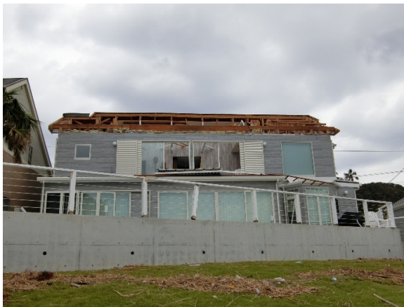
写真-8.4.3.72 屋根の飛散
