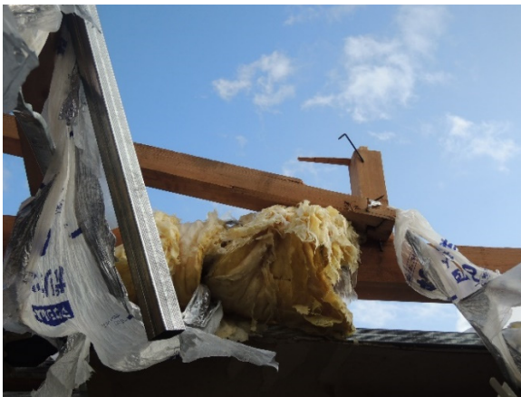
写真-8.6.1.47 小屋束の状況
