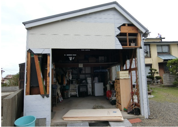
写真-8.4.3.37 外壁材が脱落した車庫
