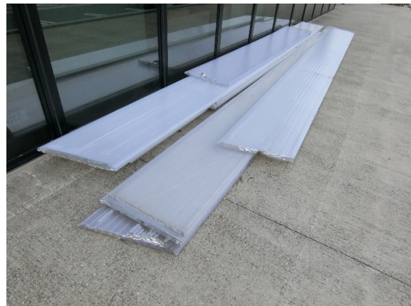
写真-8.4.1.12 脱落した外壁材
