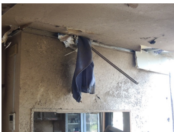
写真-8.6.1.43 写真-8.6.1.42 の室内側 の状況
