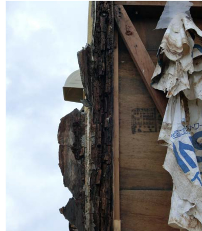
写真-8.4.3.62 写真-8.4.3.61 右側の躯体の生物劣化
