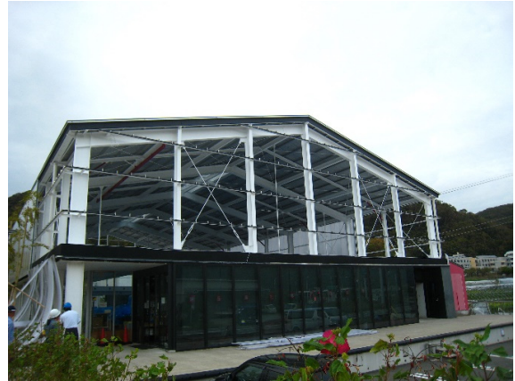
写真-8.4.1.14 全ての外壁材が 飛散した妻面
