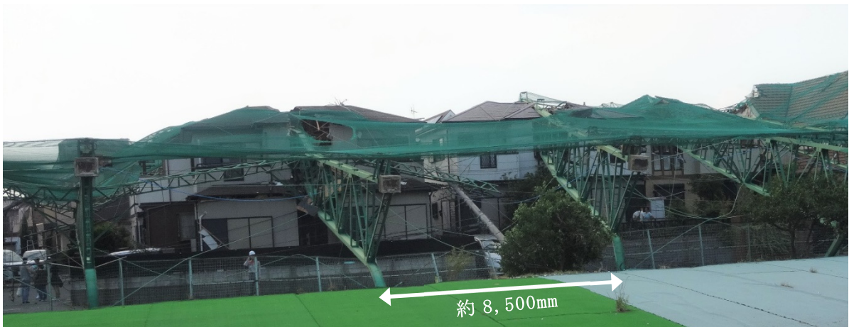
写真-8.7.1.1 鉄柱の倒壊状況
