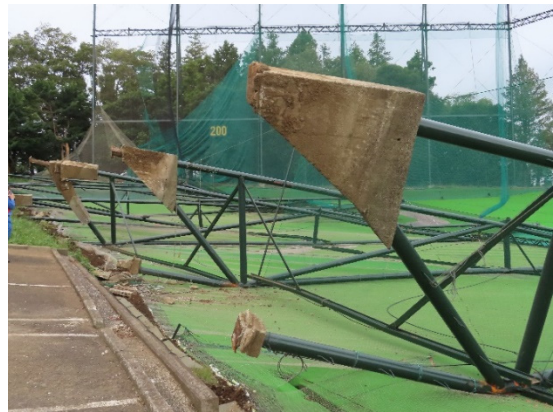
写真-8.7.2.9 引き抜けた柱脚(1)
