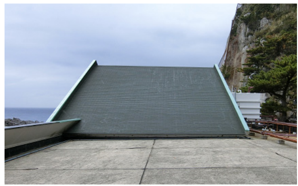
写真-8.5.1.59 既にアスファルトシングルへの葺き替えが終わった三角屋根部分
