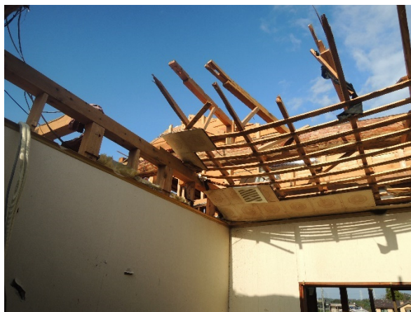
写真-8.6.1.34 小屋組ごと飛散した 屋根の範囲の状況
