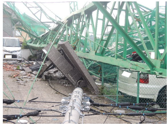
写真-8.7.1.13 ブロック塀、電柱、乗用車の被害
