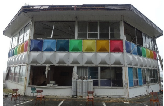
写真-8.4.2.16 公園施設 A のサッシ・窓ガラスの被害状況
