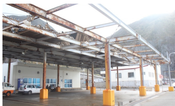
写真-8.5.2.31 漁港施設 A の屋根被害
