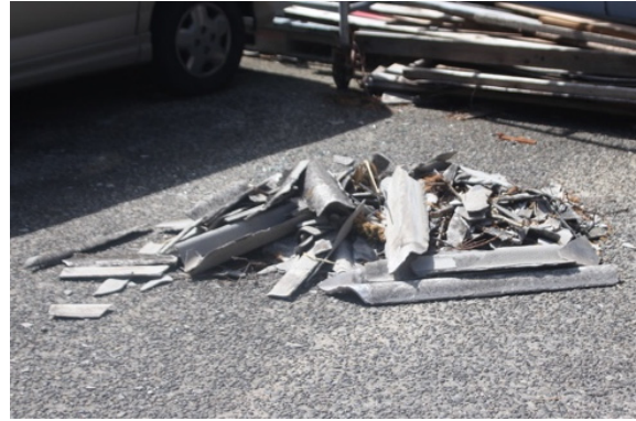
写真-8.5.2.5 脱落した屋根材
