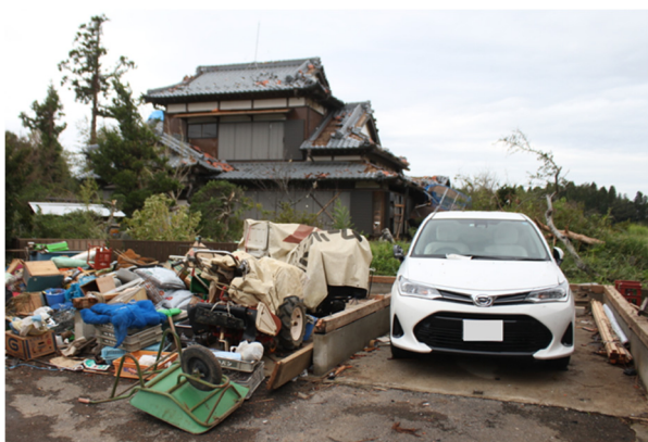
写真-8.6.3.5 倒壊した車庫 B
