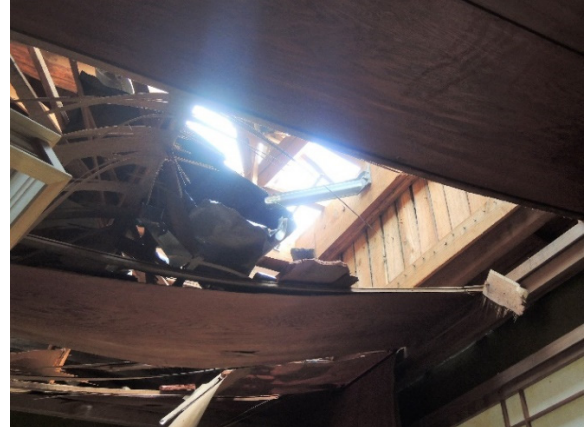
写真-8.6.1.53 室内側の被害(1)
