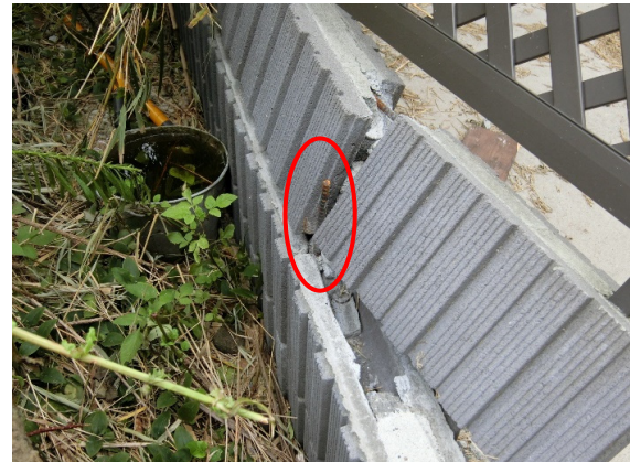
写真-8.4.3.28 ブロック塀の破壊部分 から見える鉄筋
