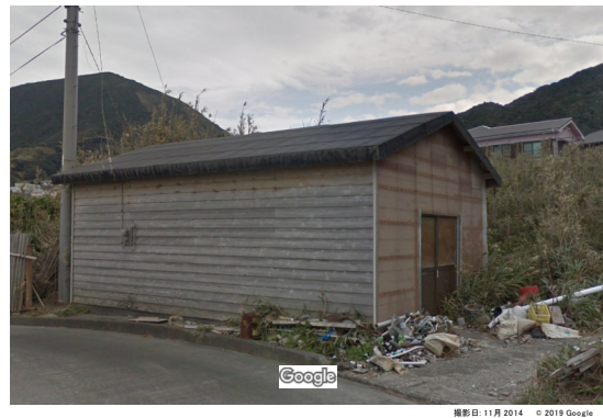
写真-8.5.1.36 被災前の倉庫 A (google ストリートビュー (2014 年 11 月撮影) より)
