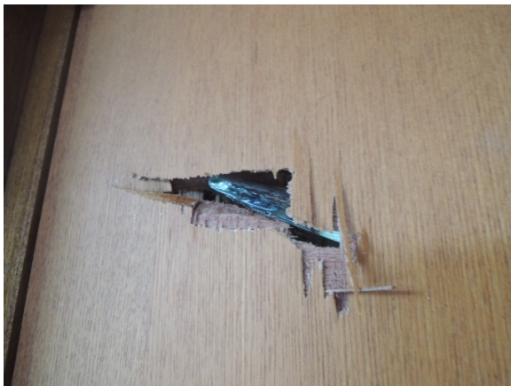
写真-8.4.1.20 窓ガラス破片のドアへの貫通（室内側から見る）
