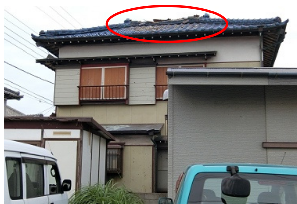
写真-8.4.3.30 棟瓦のみが落下した例
