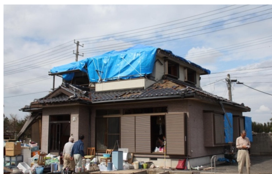
写真-8.6.1.25 南東側から見た雨戸、瓦の被害
