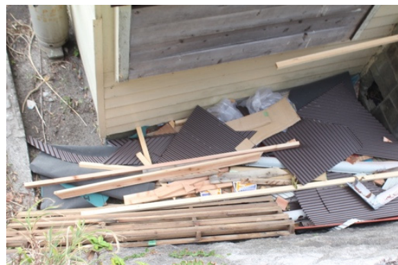
写真-8.5.1.46 飛散した屋根材
