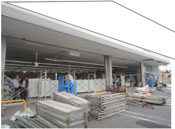
写真-8.4.3.9 脱落した建具の応急復旧に向けた準備状況
