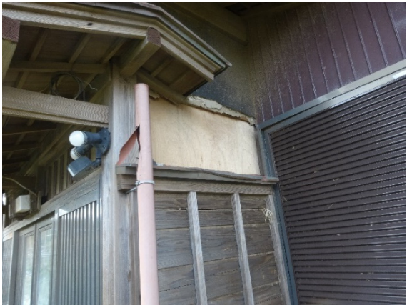
写真-8.6.1.52 玄関脇の被害
