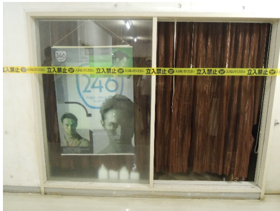
写真-8.3.8 第2庁舎地下1階 中央部のガラス
