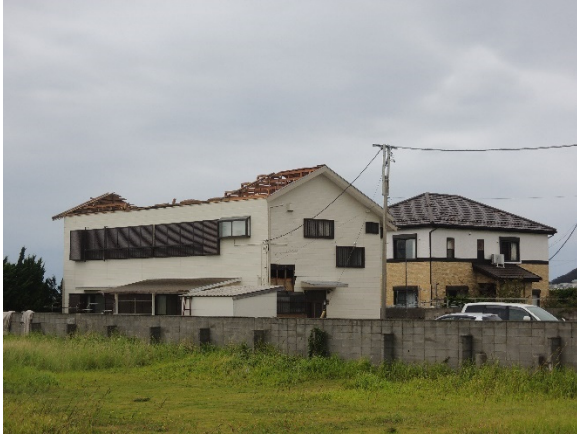
写真-8.4.3.23 木造住宅の小屋組の損壊(1)
