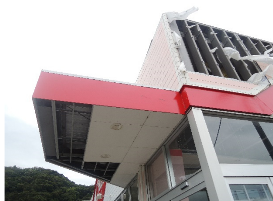
写真-8.4.1.4 軒天井の仕上げ材と隅角部 での外壁材の脱落・飛散
