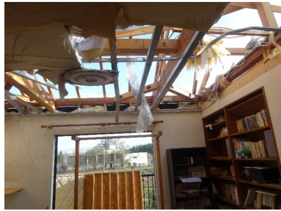
写真-8.6.1.46 野地板の飛散と 天井材の破損
