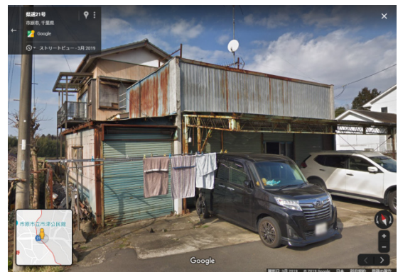
写真-8.6.1.22 倒壊した住宅
