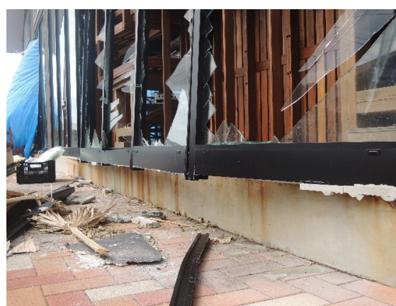
写真-8.4.2.2 屋外に面する建具の損壊(2)
