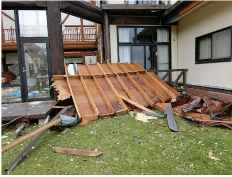
写真-8.4.3.52 脱落した屋根
