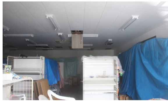
写真-8.5.1.26 屋根被害を受けた 店舗 A の内部
