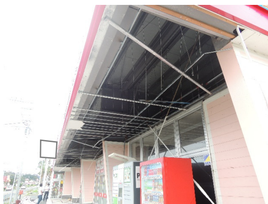
写真-8.4.1.3 軒天井の仕上げ材 の脱落・飛散
