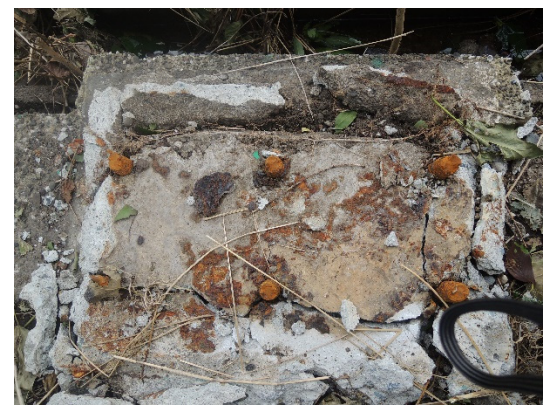
写真-8.7.1.9 柱脚ベースプレートの設置跡
