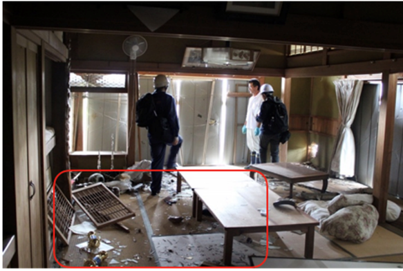
写真-8.6.1.17 ガラス等が飛散した室内
