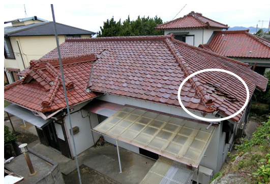
写真-8.4.3.32 平瓦の部分的なずれ又は破損
