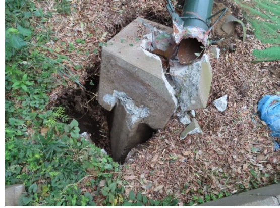
写真-8.7.2.13 柱脚の折損
