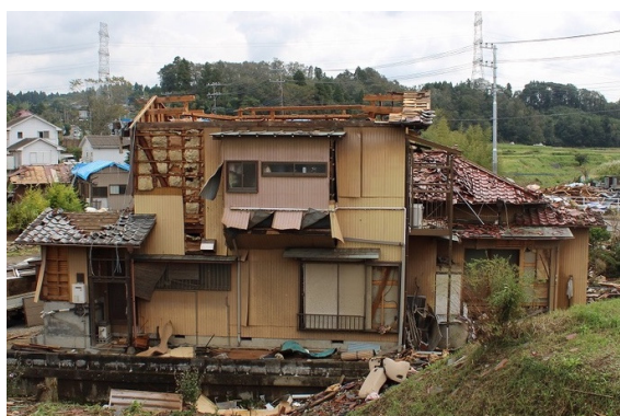
写真-8.6.1.9 住宅Bの外観 (北面)
