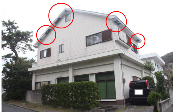
写真-8.5.2.16 住宅の軒被害
