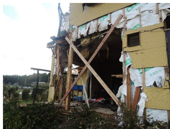
写真-8.6.1.42 損壊した壁面の 応急措置の状況
