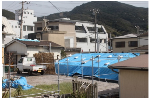
写真-8.5.1.41 住宅の屋根の被害
