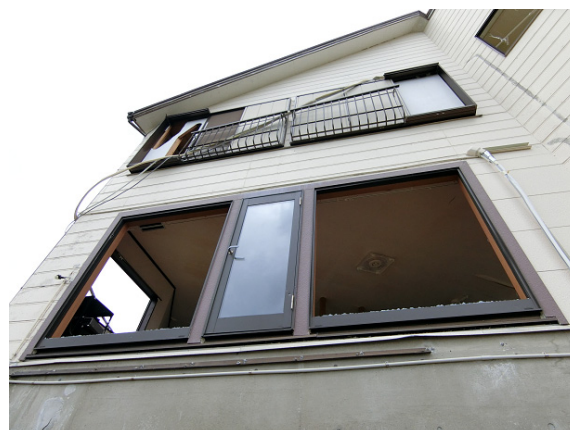
写真-8.4.3.68 海側の窓ガラスの破損と脱落したアルミ製バルコニーの設置部分
