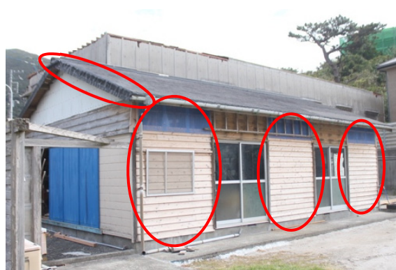
写真-8.5.1.20 壁の波板材と木ずり板による補修と屋根けらば部の防水シートによる補修
