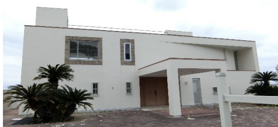
写真-8.4.3.69 無被害のように見える鉄骨造建築物
