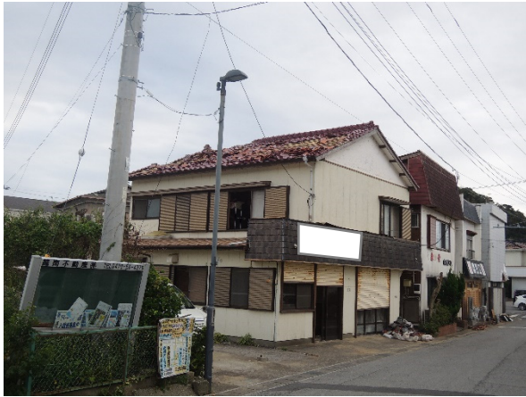
写真-8.4.1.9 店舗併用住宅での 屋根瓦の被害
