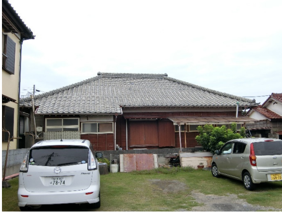
写真-8.4.3.33 無被害に見える瓦屋根(1)
