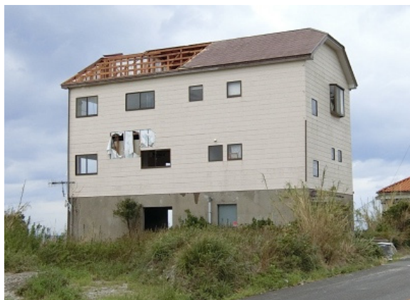
写真-8.4.3.67 屋根が飛散した海岸沿いの混構造 3 階建て住宅
