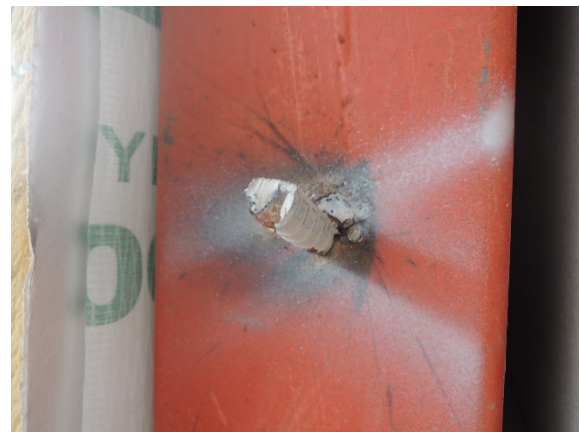
写真-8.4.3.12 建具と鋼製支持部材との接合部(2)
