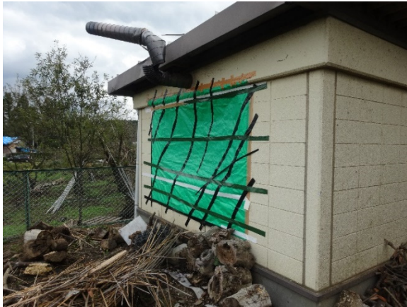
写真-8.6.2.9 陶芸室の窓ガラスの破損
