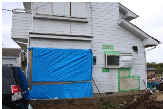
写真-8.6.1.23 東面の窓・壁の被害
