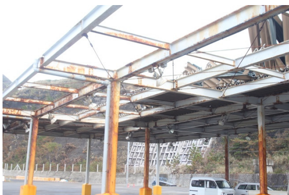
写真-8.5.2.32 漁港施設 A の屋根被害
