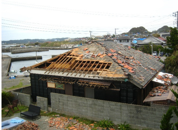
写真-8.4.3.45 野地板が飛散した木造住宅
