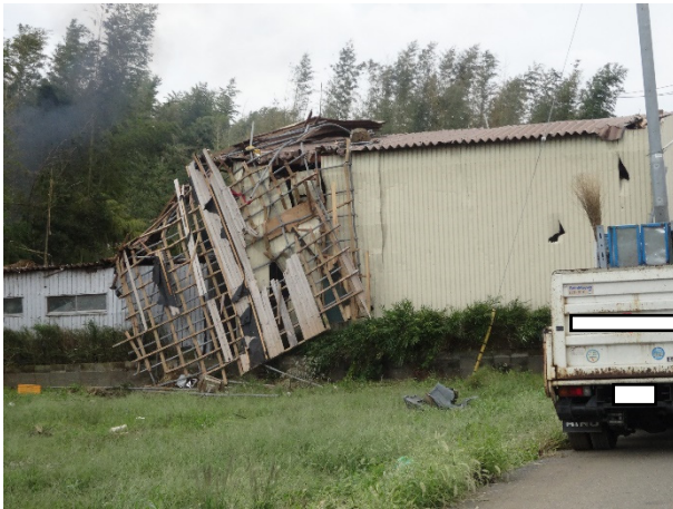
写真-8.6.3.11 倉庫 B の外観
