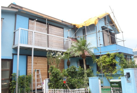
写真-8.5.1.19 住宅の屋根の被害（開口部には防御板が嵌められている）
