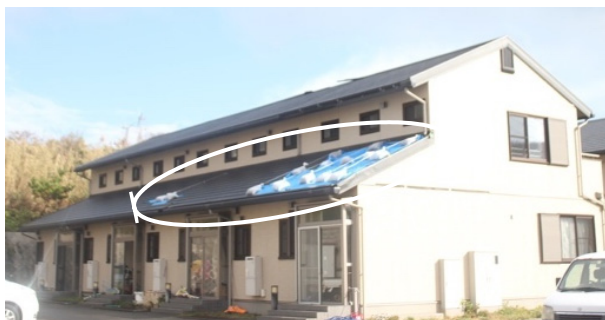
写真-8.5.2.28 共同住宅の屋根と 軒の被害
