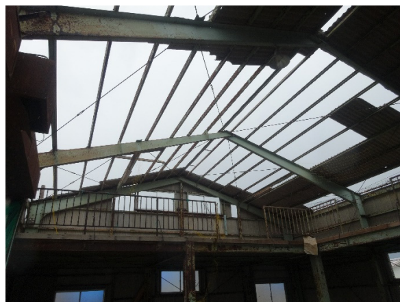
写真-8.4.2.28 屋根・窓ガラスの被害
