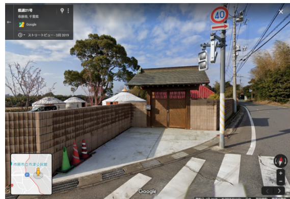
写真-8.6.3.16 倒壊した門の被災前の状況 (Google ストリートビュー(2019年3月撮影)より)
