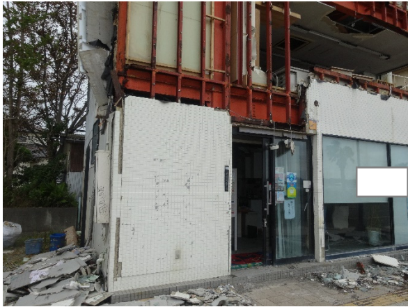
写真-8.4.3.5 外壁の脱落
