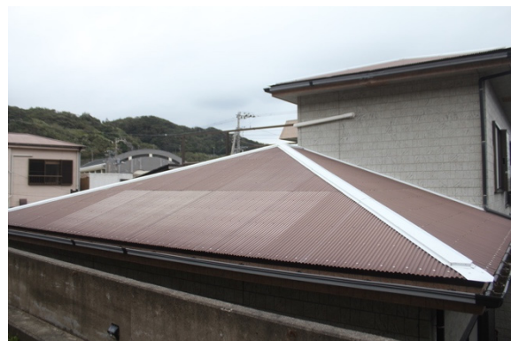
写真-8.5.1.34 補修された住宅の屋根
