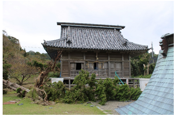
写真-8.4.3.49 社殿の残留変形
