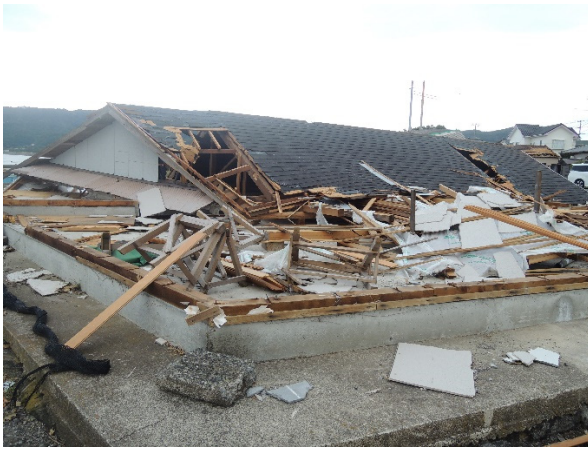
写真-8.4.1.22 木造倉庫の倒壊
