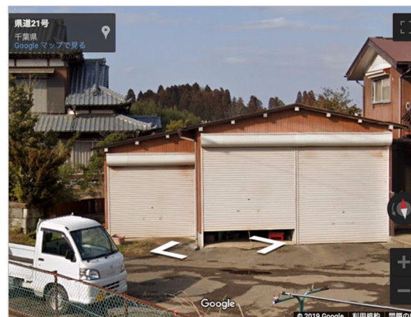
写真-8.6.3.6 倒壊した車庫 B
