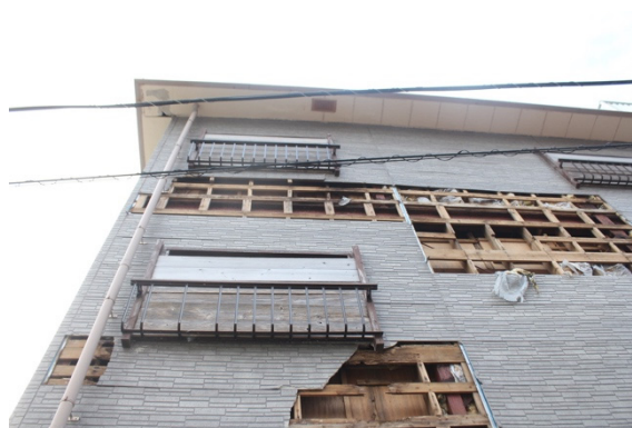
写真-8.5.1.54 外壁材の脱落
