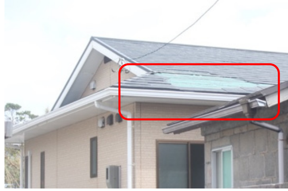
写真-8.5.2.13 住宅の屋根被害
