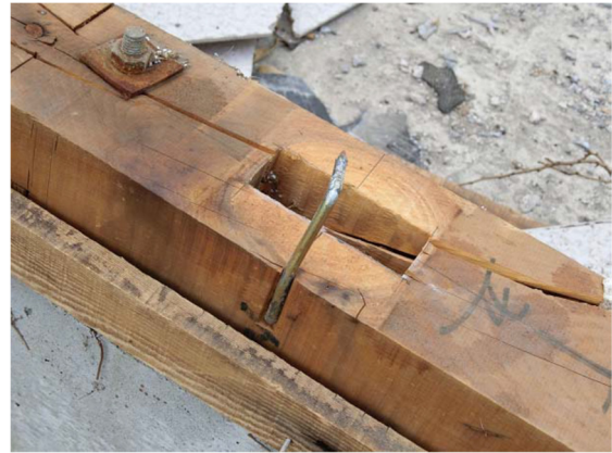
写真-8.4.1.23 木造倉庫のアンカーボルトと柱脚のかすがい
