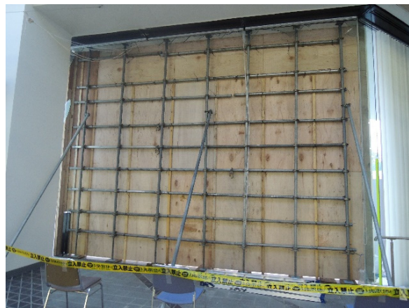
写真-8.3.3 第2庁舎南面入り口付近で破損したガラスの応急復旧状況(室内側)
