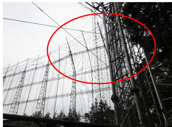
写真-8.7.2.15 先端部の被害状況(1) (北側)
