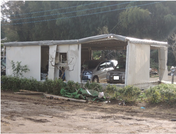
写真-8.6.3.8 車庫 C の損傷状況
