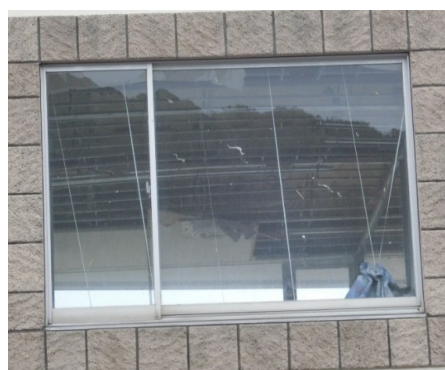
写真-8.4.3.70 窓越しに見える天井仕上げ材の脱落
