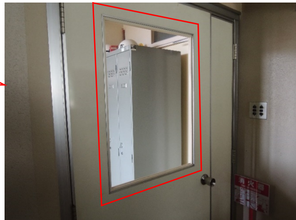
写真-8.6.2.12 市津支所内部のドアに はめ込まれたガラスの破損箇所
