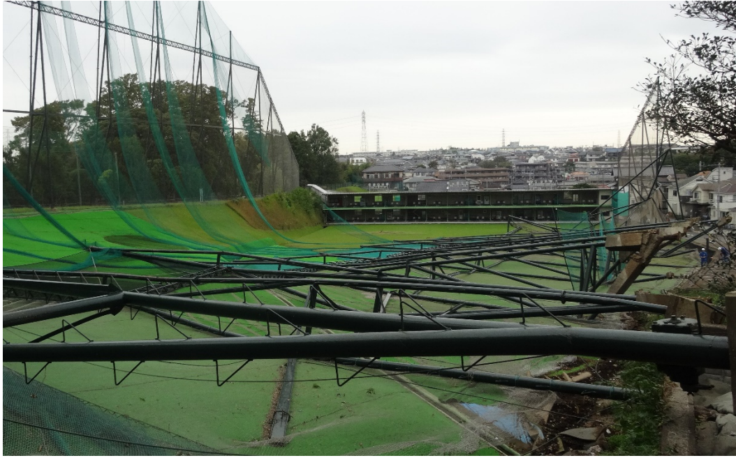
写真-8.7.2.1 鉄柱の倒壊状況(1)
