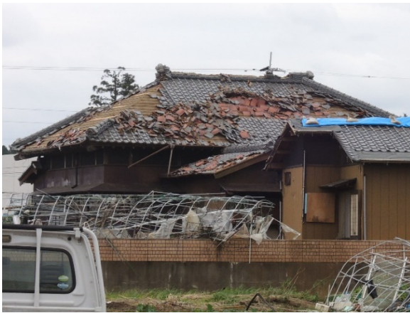
写真-8.6.1.50 住宅 K の屋根の状況 (北西側)
