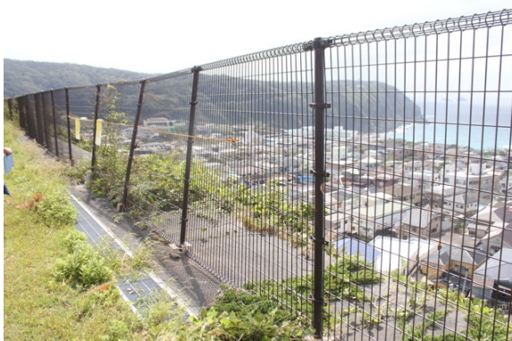
写真-8.5.1.7 フェンスの被害
