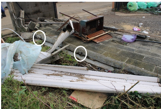
写真-8.6.3.14 ブロック塀の被害(3) (丸囲みは縦筋)
