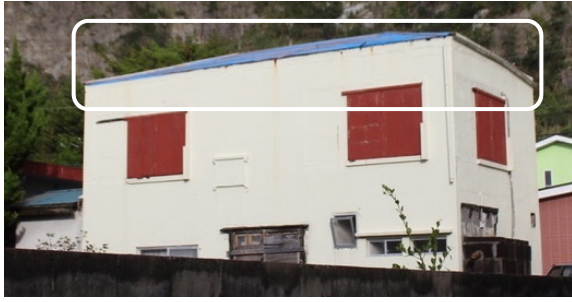
写真-8.5.2.36 住宅の屋根被害(3)
