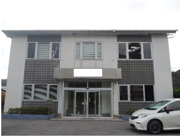
写真-8.4.1.16 事務所 A の外観
