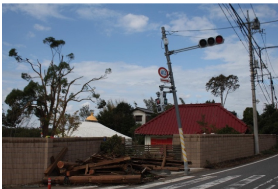
写真-8.6.3.15 倒壊した門
