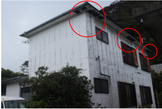
写真-8.5.2.18 住宅の軒被害
