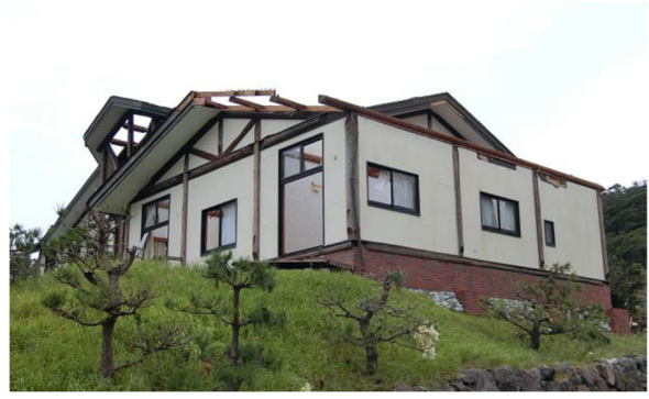
写真-8.4.3.53 連続する宿泊室部分の屋根の飛散
