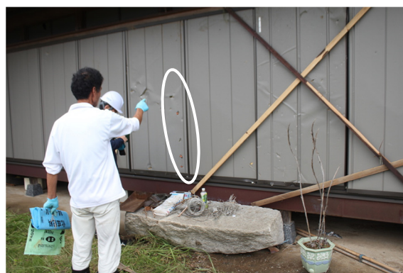
写真-8.6.1.16 瓦が突き刺さった雨戸
