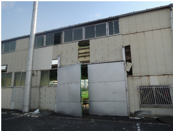
写真-8.7.1.14 ゴルフ練習場 A の建築物の外壁等被害
