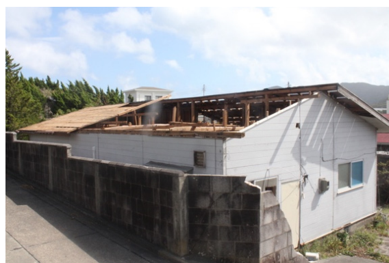
写真-8.5.2.9 住宅の屋根被害
