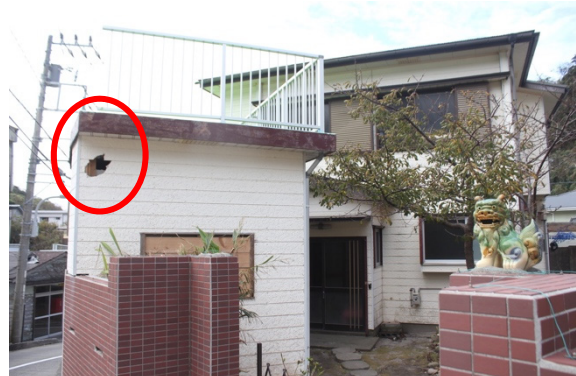
写真-8.5.1.48 飛来物による東面の壁の破損
