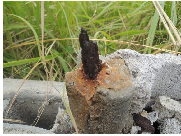
写真-8.4.3.26 鉄筋の状況
