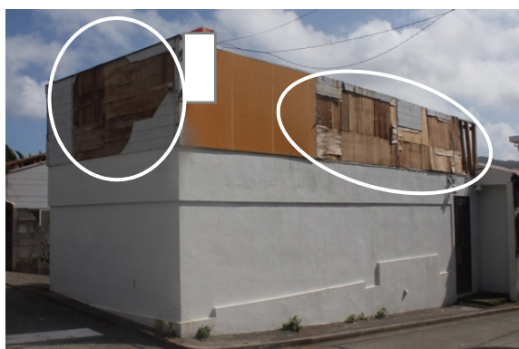
写真-8.5.2.10 店舗Cのパラペットの被害
