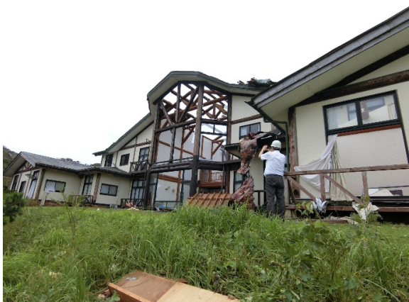
写真-8.4.3.50 窓ガラスの破損
