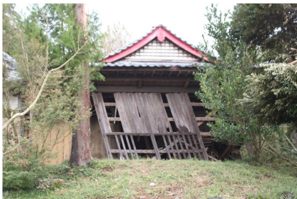
写真-8.6.3.1 本殿の被害状況
