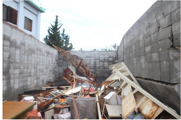
写真-8.5.2.23 倒壊した倉庫 B の内部
