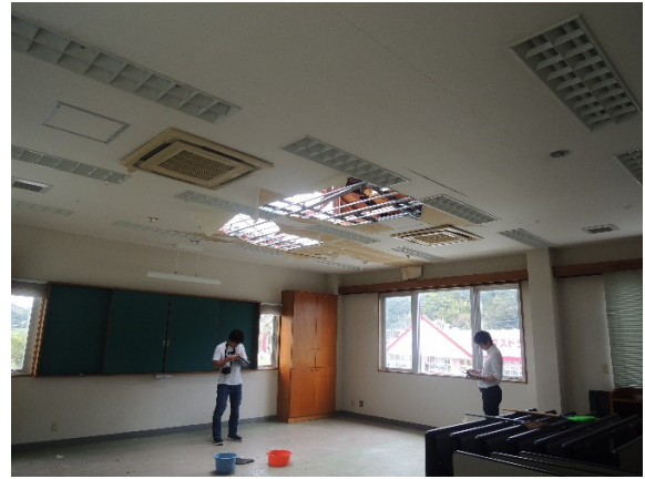
写真-8.4.1.17 2階天井の被害状況
