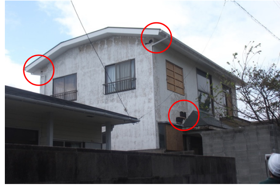
写真-8.5.2.19 住宅の軒と外壁被害
