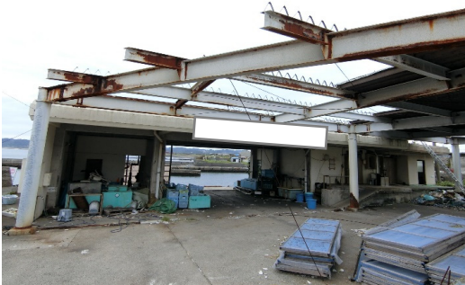
写真-8.4.3.17 漁港施設 A と同じ敷地内にある建屋
