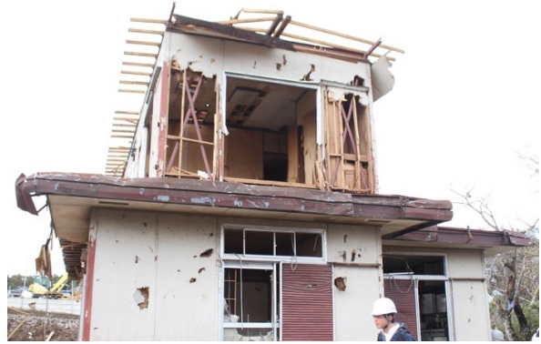
写真-8.6.1.2 住宅 A の外観（東面）
