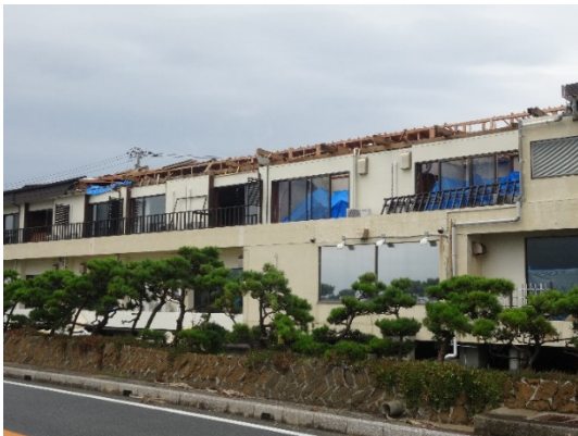
写真-8.4.2.19 木造部分の屋根とベランダ の被害状況
