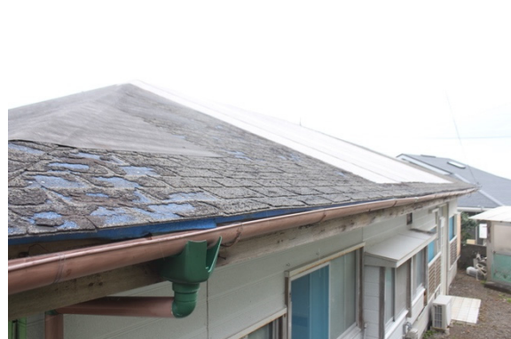
写真-8.5.1.52 屋根ふき材の被害
