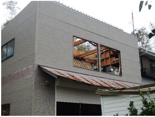
写真-8.6.3.9 倉庫 A の外観
