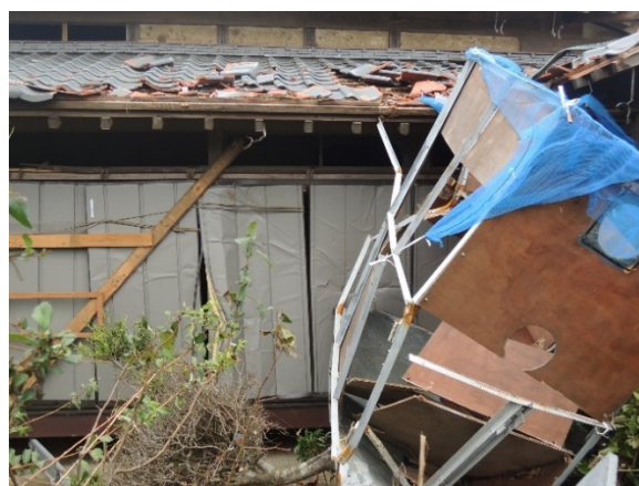
写真-8.6.1.14 農業用工作物の雨戸への衝突状況
