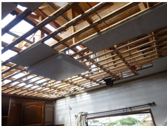
写真-8.6.1.35 小屋組が残っている 屋根の範囲の状況
