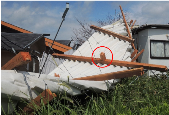
写真-8.4.2.7 飛散した小屋組
