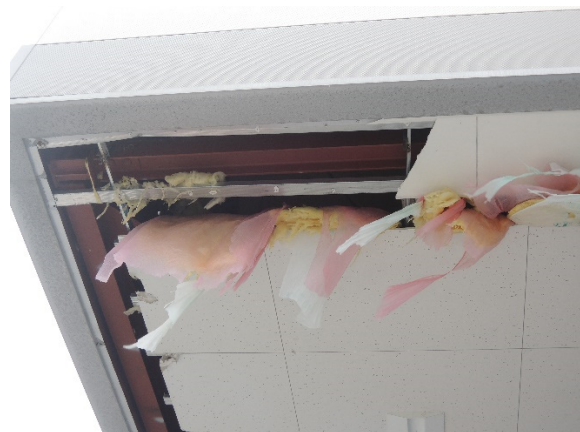
写真-8.4.3.14 軒天井の損傷
