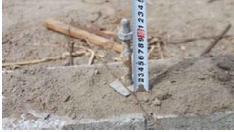
写真-8.5.1.37 基礎に残った アンカーボルト
