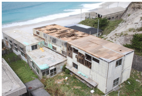
写真-8.5.1.11 元造船所の被害（手前が元造船所 A、奥が元造船所 B）
