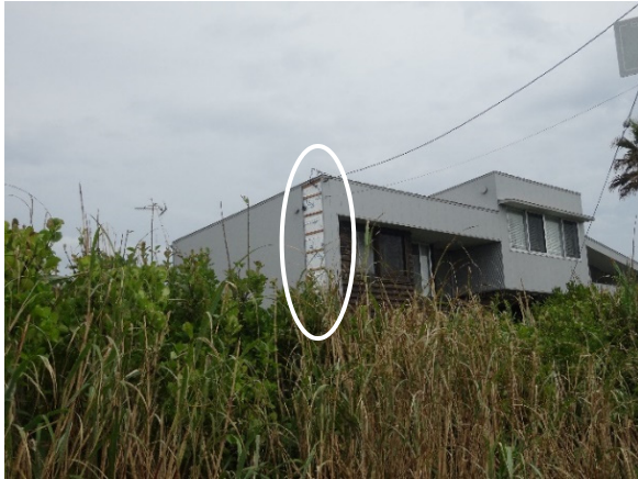
写真-8.4.2.30 住宅の隅角部での 被害状況(1)
