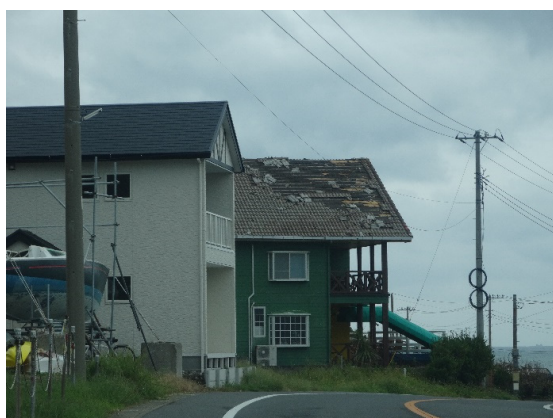
写真-8.4.2.25 屋根瓦の被害(風上側)
