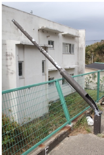
写真-8.5.1.17 飛来物の衝突により破損したと思われる街灯
