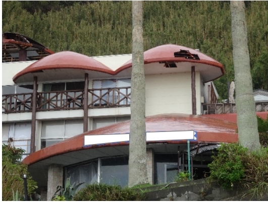
写真-8.4.2.17 宿泊施設 A の屋根・ 軒天井の被害状況
