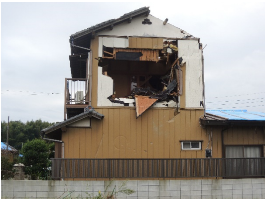
写真-8.6.1.56 北東側の外壁の損壊状況
