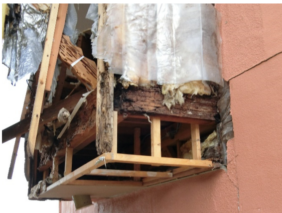
写真-8.4.3.65 躯体に生じた著しい腐朽・蟻害
