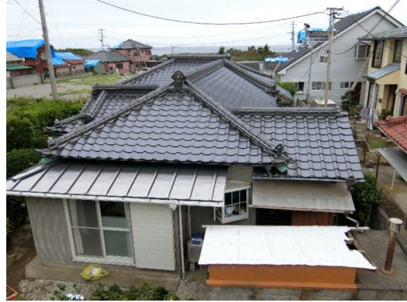
写真-8.4.3.34 無被害に見える瓦屋根(2)
