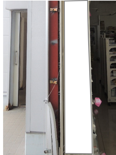
写真-8.4.3.10 建具が接合されていた鋼製支持部材
