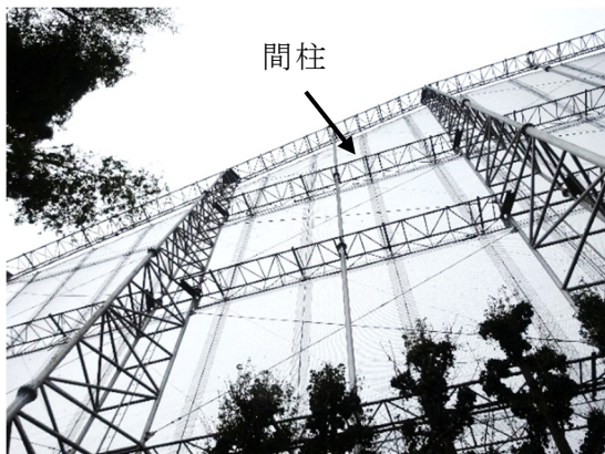
写真-8.7.2.14 無被害の鉄柱と間柱
