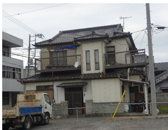
写真-8.4.1.28 隣接する住宅の被害状況
