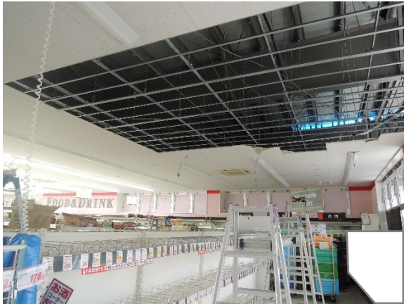
写真-8.4.1.5 店舗内部の天井仕上げ材の被害
