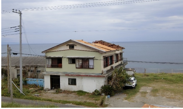
写真-8.4.3.41 屋根が飛散した 海沿いの木造住宅
