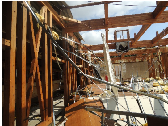
写真-8.4.2.6 店舗 F の屋内の状況
