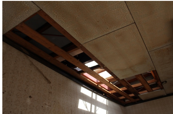
写真-8.6.1.4 天井材の損傷状況
