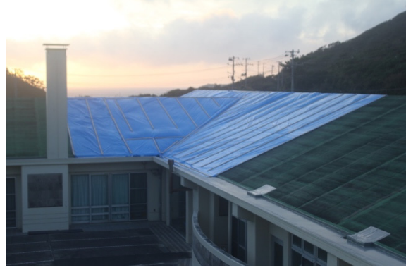
写真-8.5.2.41 介護施設の屋根被害 (写真-8.5.2.40 を東側から見た様子)
