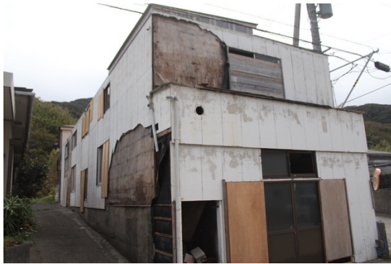
写真-8.5.1.31 壁に被害を受けた住宅
