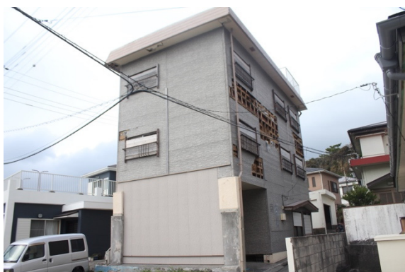
写真-8.5.1.53 住宅の壁被害
