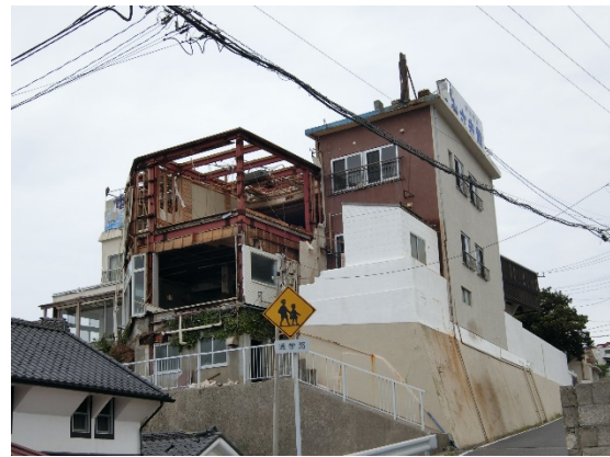
写真-8.4.3.40 宿泊施設 F の外壁の 脱落状況
