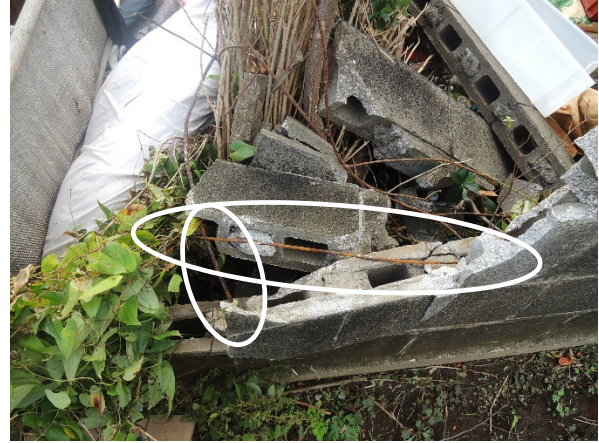
写真-8.6.3.13 ブロック塀の被害(2) (丸囲みは縦筋と横筋)
