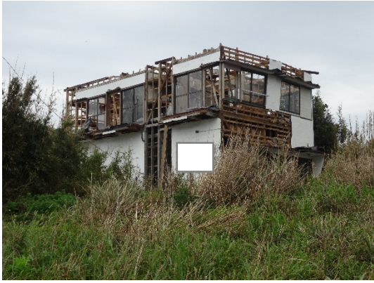
写真-8.4.2.39 木造住宅の屋根の飛散と外壁の被害
