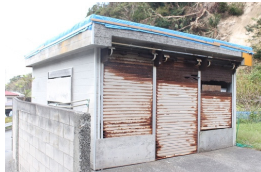
写真-8.5.1.44 倉庫の屋根被害
