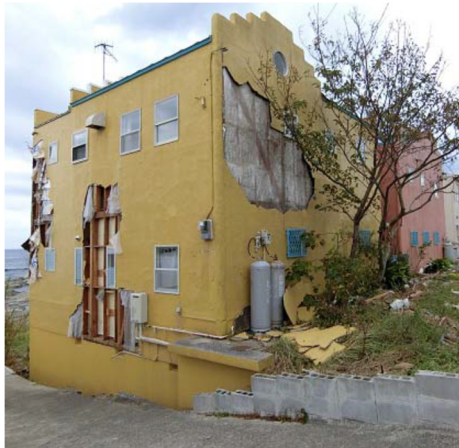
写真-8.4.3.63 写真-8.4.3.61 右側の住宅の被害状況
