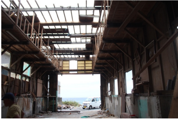
写真-8.5.1.12 木造の元造船所 B の被害 (内部)
