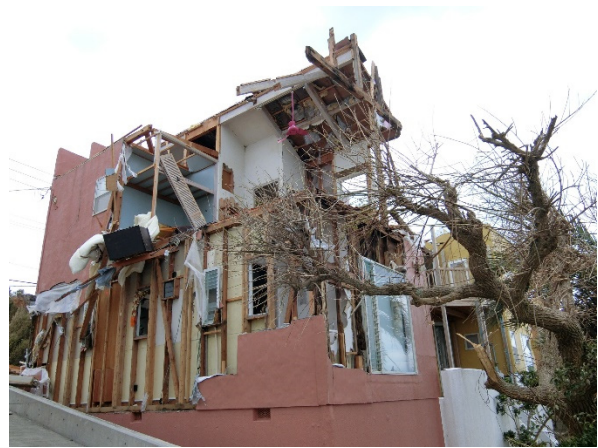
写真-8.4.3.64 写真-8.4.3.61 左側の住宅の外壁の崩落
