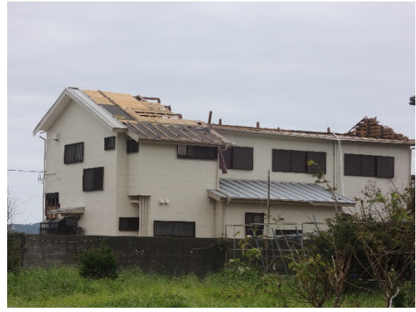
写真-8.4.3.24 木造住宅の小屋組の損壊(2)
