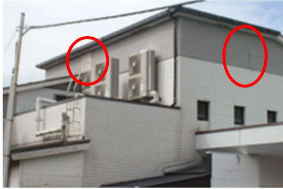
写真-8.5.1.42 RC造の病院に増築された木造部分の外壁・軒の被害
