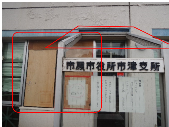
写真-8.6.2.11 市津支所の屋外に面する ガラスの破損
