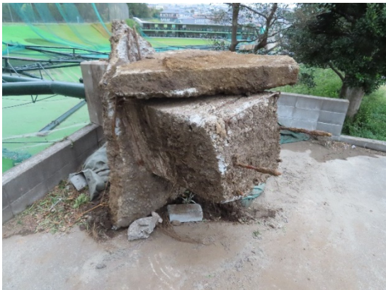
写真-8.7.2.10 引き抜けた柱脚(2)
