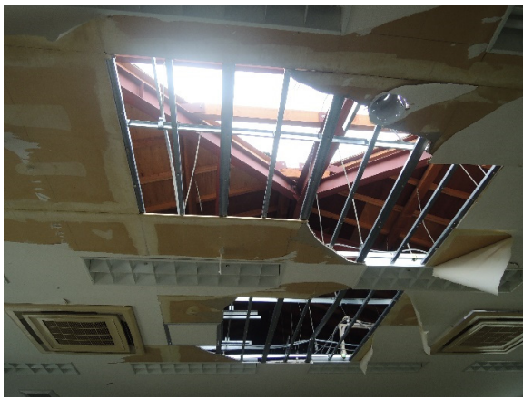
写真-8.4.1.18 2階天井と野地の被害状況
