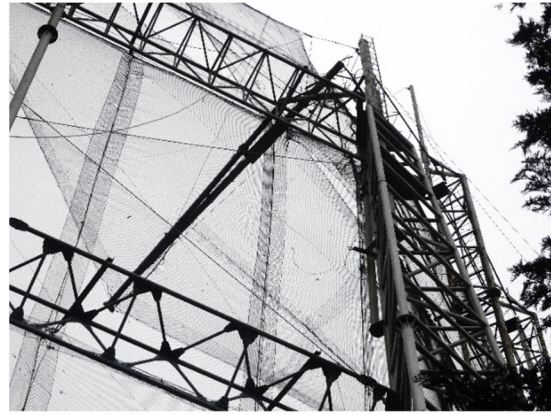
写真-8.7.2.17 折損した鉄柱(1) (南側の鉄柱)
