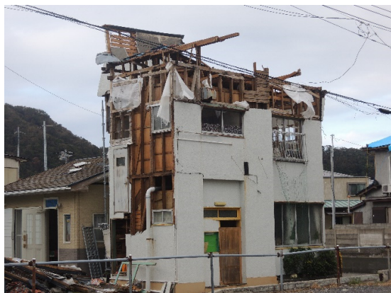
写真-8.4.1.27 木造住宅の被害状況
