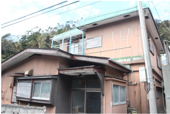
写真-8.5.1.47 南面の通気口の脱落
