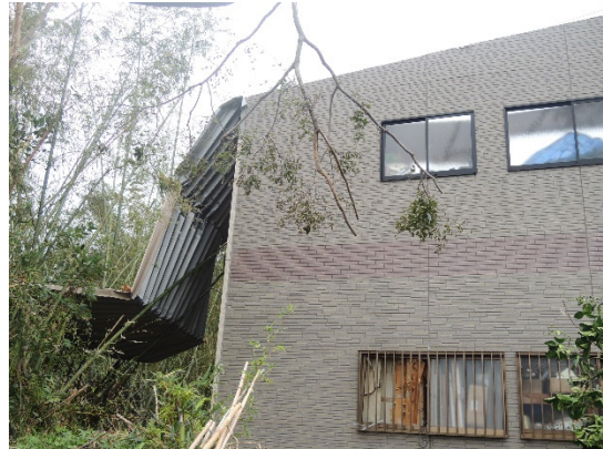
写真-8.6.3.10 折板屋根材の状況
