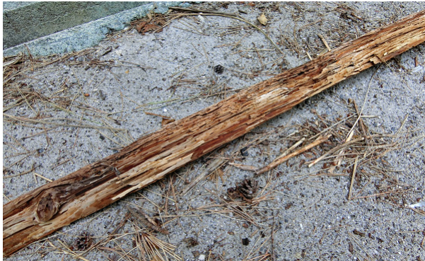
写真-8.5.1.58 受け材の蟻害
