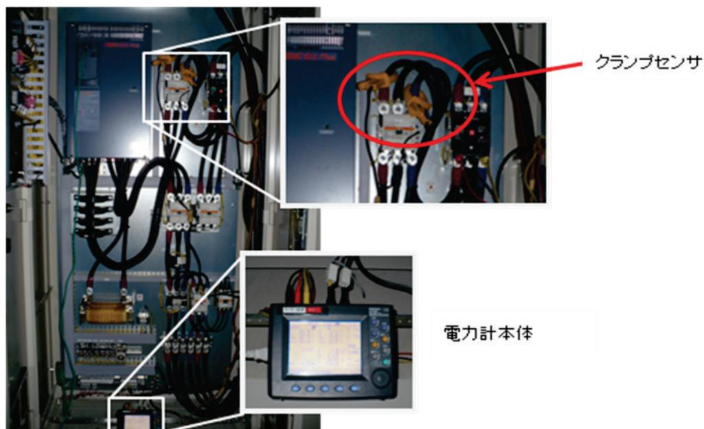
図Ⅱ.2.2.1 電力計の設置状況 (動力盤)
