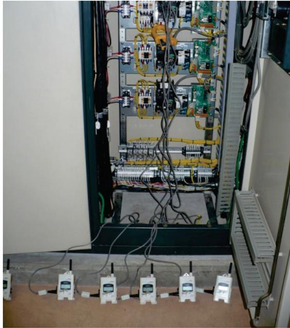
図Ⅱ.2.2.2 クランプ電流ロガーの設置状況（動力盤）
