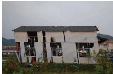
写真20 骨組の残留変形 (つくば市)
