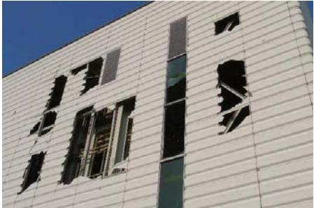
写真16 外壁材とガラスの損傷 (つくば市)
