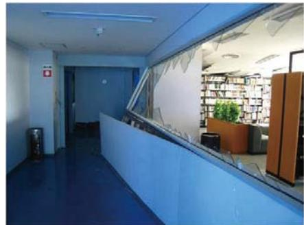
写真 24 内装材の被害 (つくば市)
