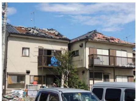
写真3 屋根ふき材の脱落・飛散 (越谷市)
