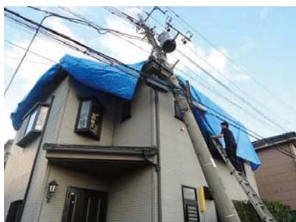
写真32 電柱の折損による屋根の被害 (越谷市)
