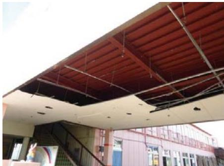
写真19 ピロティの天井の被害 (越谷市)
