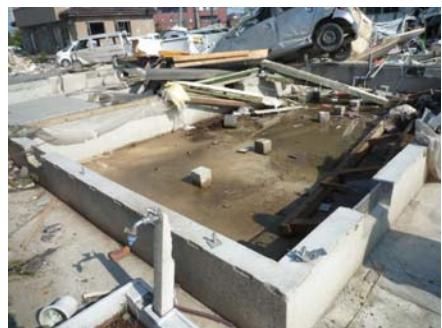
写真 12 土台を含む上部構造の飛散 (つくば市)
