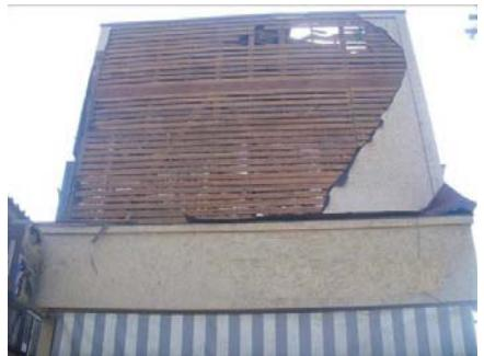
写真4 モルタル外壁の脱落 (つくば市)
