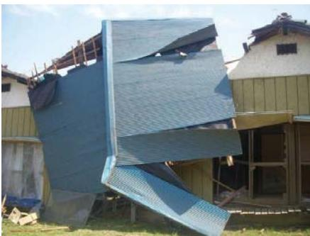
写真28 飛来物(屋根)の衝突 (つくば市)
