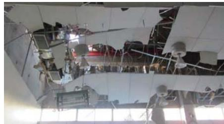
写真18 写真17に示す施設の天井の破壊 (越谷市)
