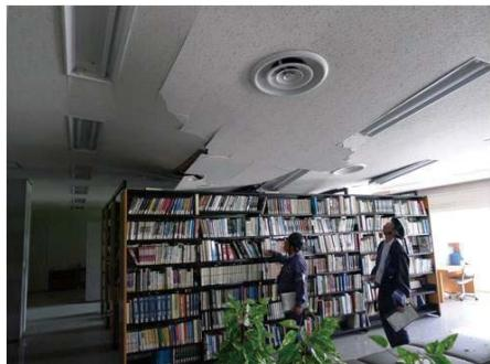
写真 25 内装材(天井材)の被害 (つくば市)
