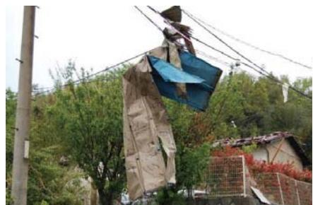
写真 26 電線に引掛けた飛来物(鋼板製屋根材) (つくば市)
