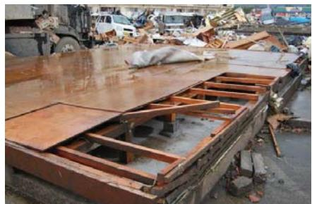
写真 13 上部構造の飛散 (つくば市)
