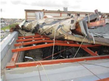
写真17 鋼板製の屋根ふき材及び母屋の破壊 (越谷市)
