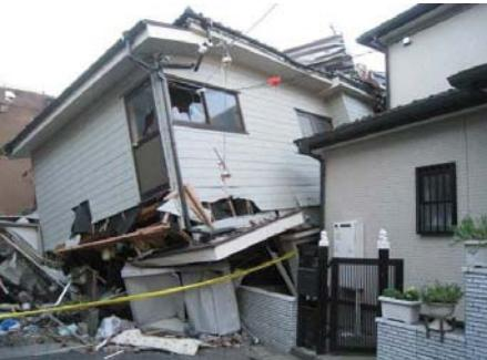
写真 11 上部構造の倒壊 (越谷市)
