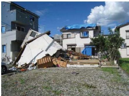
写真 10 上部構造の倒壊 (越谷市)
