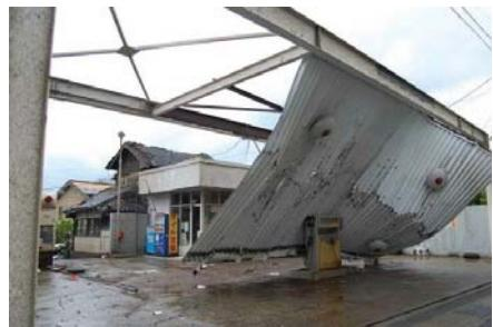
写真30 ガソリンスタンドの屋根の脱落 (つくば市)
