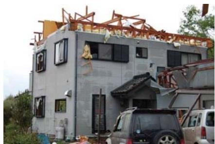
写真5 小屋組の破壊・飛散 (つくば市)
