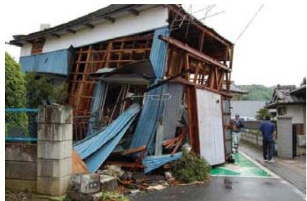
写真 14 上部構造の水平移動 (つくば市)
