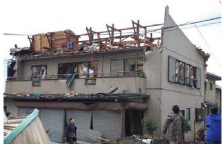
写真6 小屋組の破壊・飛散 (つくば市)
