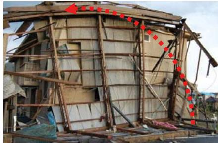
写真21 上部構造の転倒 (つくば市)
