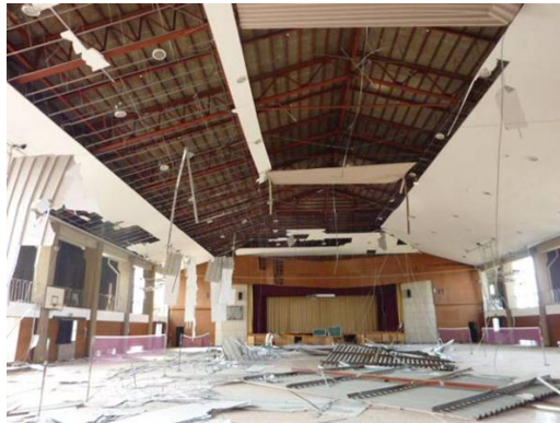
写真 1.1 体育館（在来工法の天井）の被害
