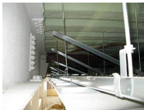
写真 2.4 斜め部材の溶接部の破断
