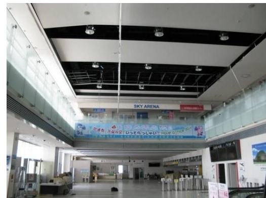
写真 1.4 空港ロビーの被害
