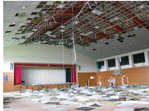
写真 1.2 体育館（システム天井）の被害
