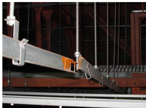
写真 2.2 野縁受けジョイントの外れ
