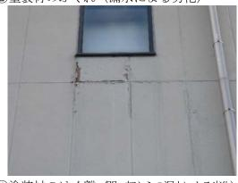
④塗装材のはく離 (開口部からの漏水による劣化)
