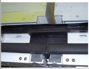
構法:ダブルシール→シーリング、ガスケット、併用など 特徴:地震時の慣性力や風による負圧をサッシに伝達する
