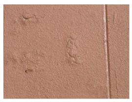
②塗装材のふくれ (漏水による劣化)
