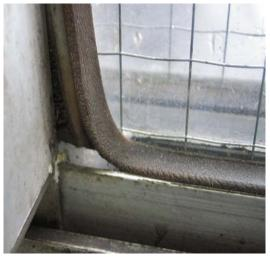
図 4.49 ガスケットの劣化事例と対策 (1/2)
