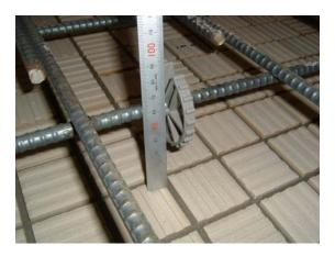
バイブレーターでタイルがずれる・割れる等の不具合が生じやすく、これに配慮してバイブレーターを控えめにすると豆板ができるなど品質管理が特に難しい。製造時の問題によりタイルのはく落につながる欠陥が多く生じるため、タイル先付けプレキャストコンクリート部材に適したコンクリート打ち込み方法の見直しなどが期待される。
