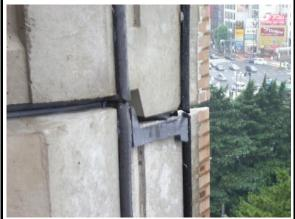
構法: [ダブルシール] -屋外側: シーリング 材、室内側: ガスケット
