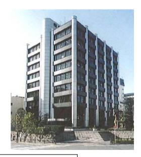
窓、外壁を、サッシ・パネルにて改修した例
