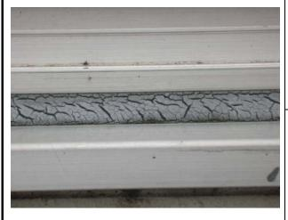
・特徴:シーリング材表面に微細なひび割 れが発生する現象
