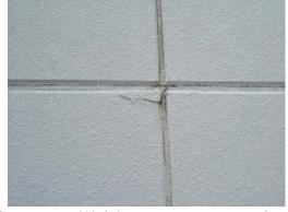
⑦シーリング接合部周辺の ALC のひび割れ(高接着力による部材破壊) 図 4.45 A L C 外壁の劣化事例
