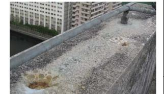
・特徴:建物の最上部等で、パネル小口の コンクリートを水平に露出させる ディテールにすると、コンクリート の経年劣化が著しく進行する。
