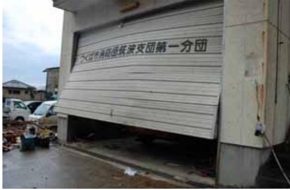
写真 3.4-37 消防団施設のシャッターの被害状況
