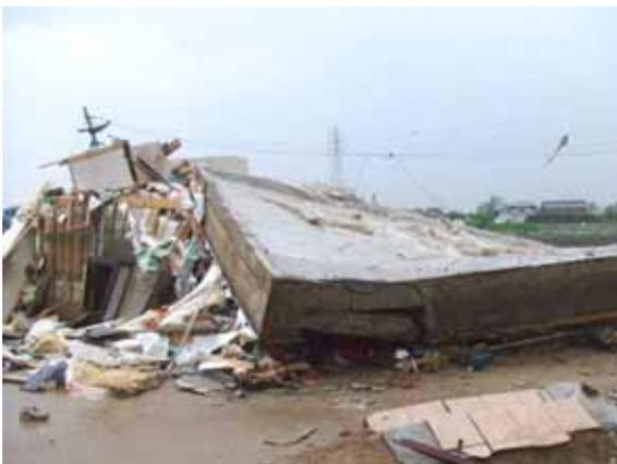
写真 3.1-3 写真 3.1-1 のべた基礎底面の露出
