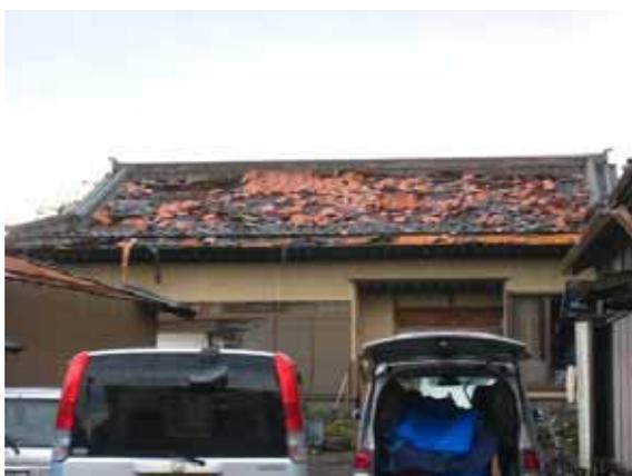
写真 3.4-1 屋根瓦の脱落
