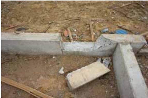
写真 3.1-19 写真 3.1-18 の無筋コンクリート基礎
