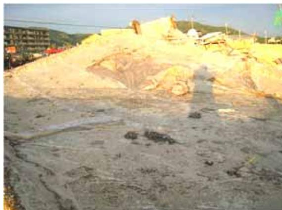
写真 3.1-4 写真 3.1-1 のべた基礎底面の防湿シート
