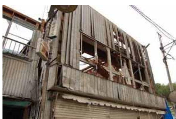
写真 3.4-14 外壁材の脱落
