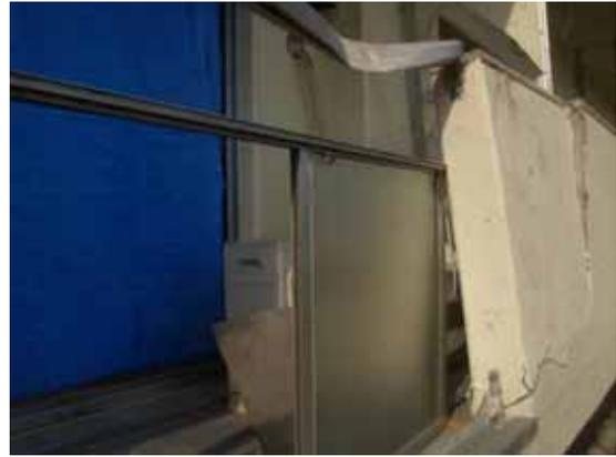
写真 3.4-28 RC造手すりの被害状況
