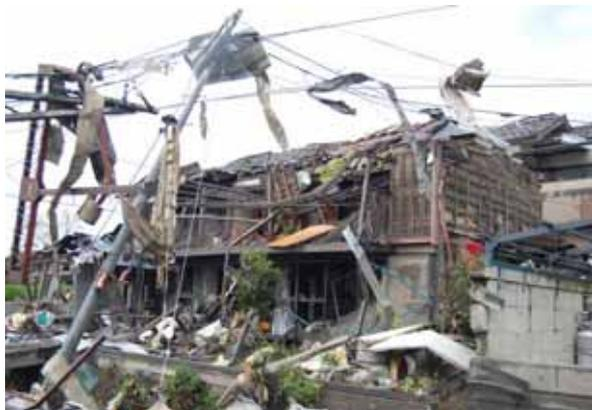
写真 3.1-28 傾斜した木造建築物
