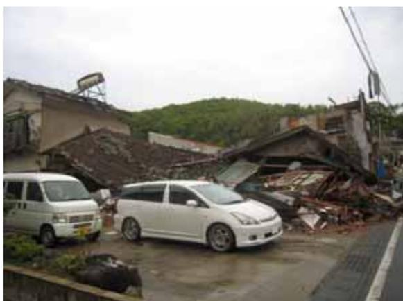
写真 3.1-24 倒壊した木造建築物
