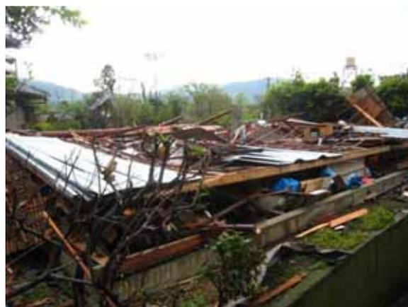
写真 3.1-25 倒壊した木造建築物
