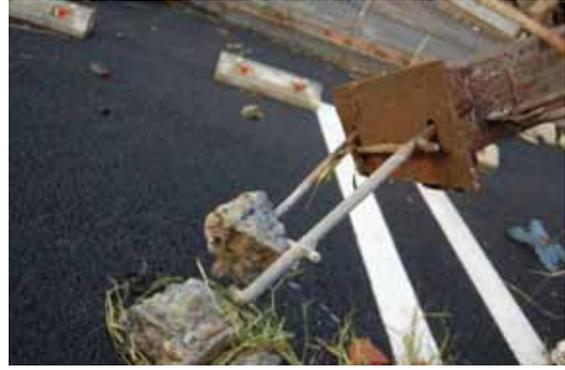
写真 3.2-9 写真 3.2-8 の柱脚の引き抜け状況
