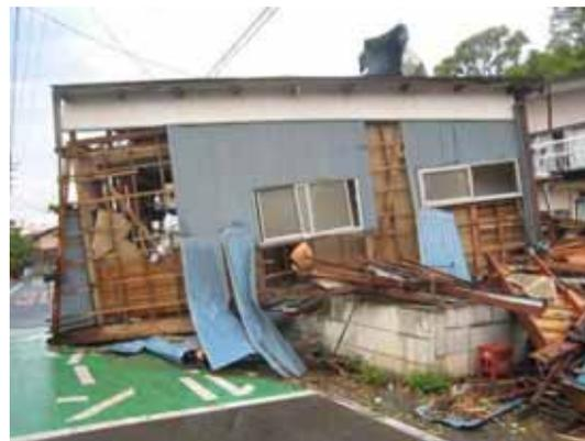
写真 3.1-31 移動した木造建築物の外観
