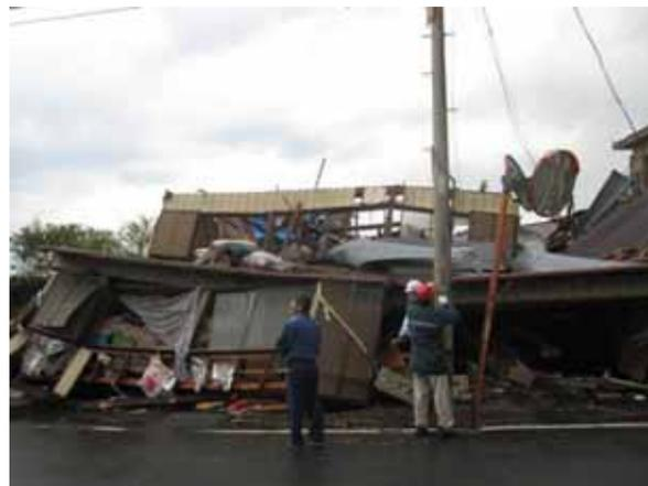
写真 3.1-29 傾斜した木造建築物
