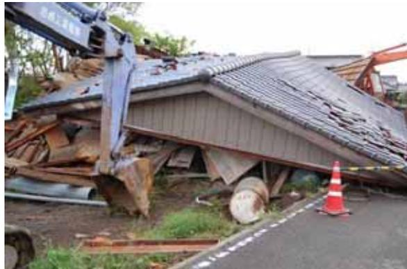
写真 3.1-23 倒壊した木造建築物
