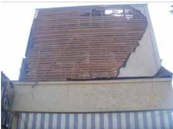
写真 3.4-11 モルタル外壁の脱落
