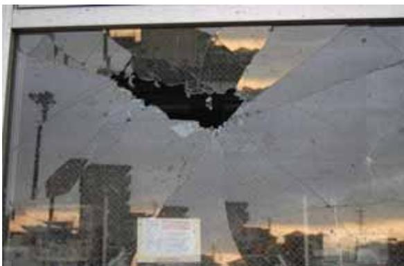
写真 3.4-35 ガラスへの飛来物の衝突痕
