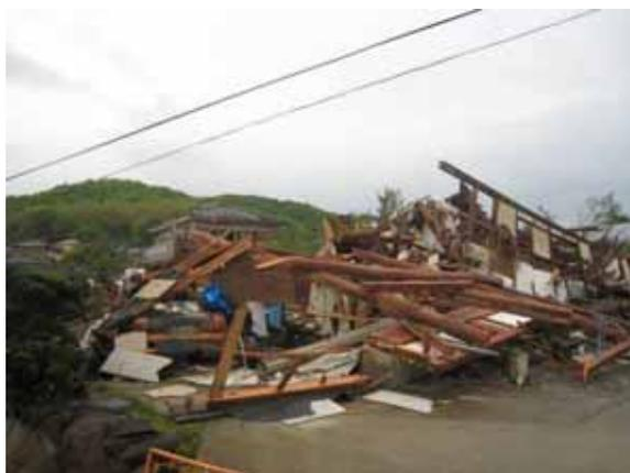
写真 3.1-26 倒壊した木造建築物
