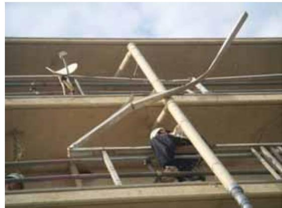
写真 3.4-30 屋外方向に引き抜かれたアルミ手すり
