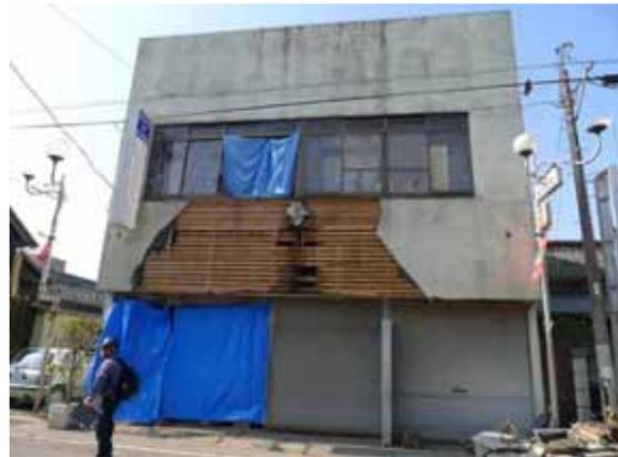
写真 3.4-12 モルタル外壁の脱落
