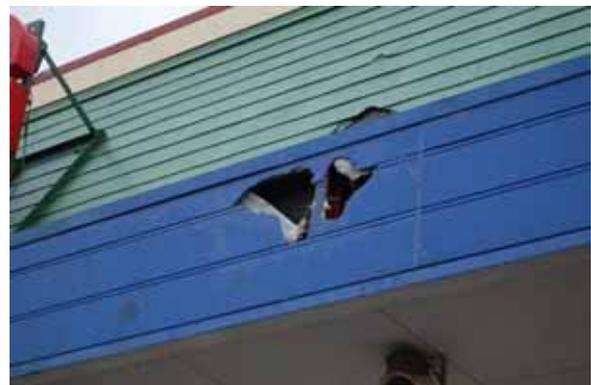
写真 3.4-34 エントランスでの飛来物の衝突痕
