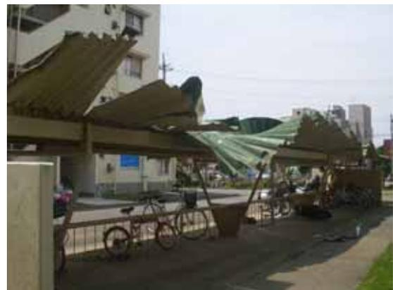
写真 3.5-2 駐輪場の折板屋根の著しい変形
