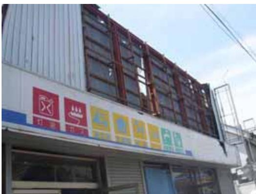
写真 3.4-13 外壁材の脱落
