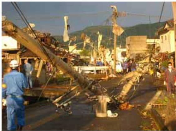
写真 3.5-7 電柱の折損・傾斜
