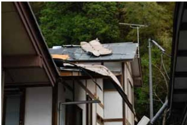
写真 3.4-6 飛来物（鋼板製屋根材）の衝突
