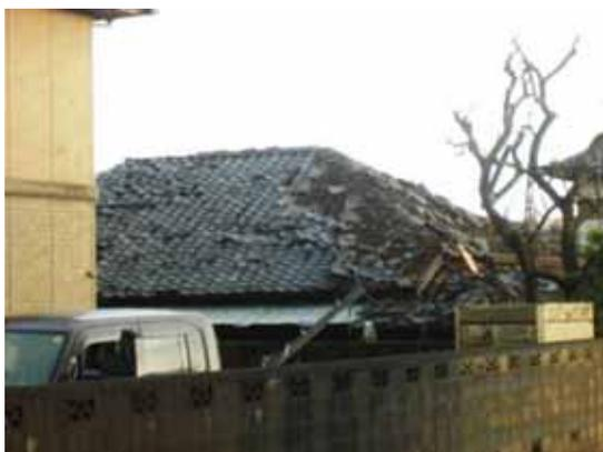
写真 3.4-3 屋根瓦の脱落
