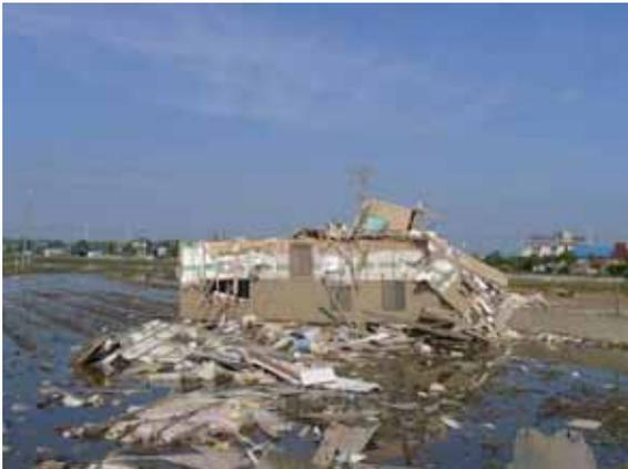
写真 3.1-1 基礎から転倒した木造建築物
