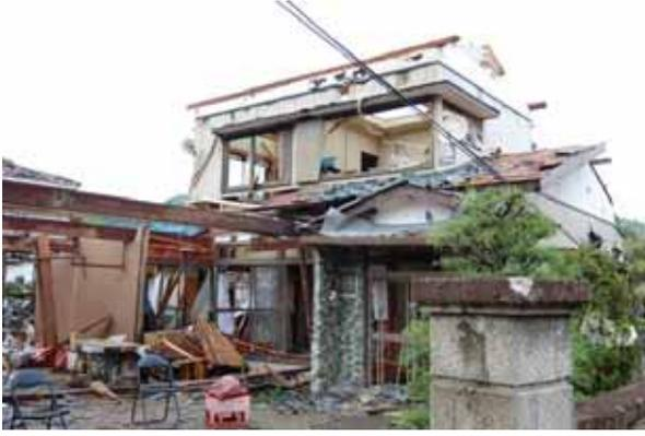
写真 3.1-32 切妻屋根の被害
