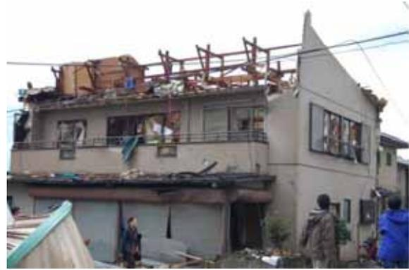
写真 3.1-35 片流れ屋根の被害
