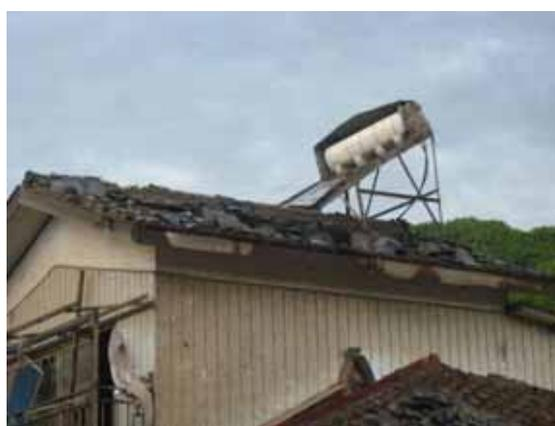
写真 3.4-2 屋根瓦の脱落
