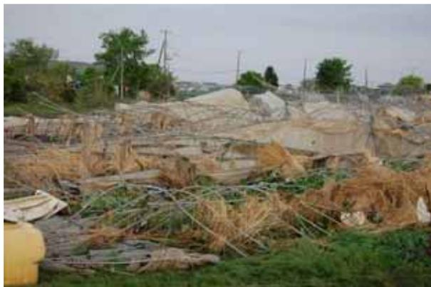
写真 3.5-9 パイプハウスの被害状況
