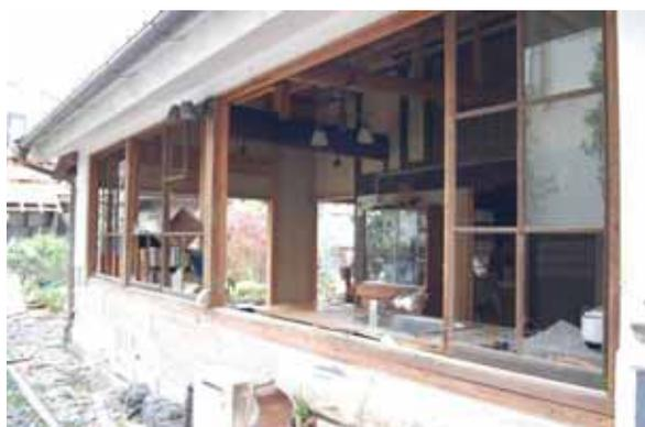
写真 3.4-25 店舗併用住宅の開口部の被害状況
