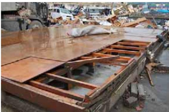
写真 4.2-3 上部構造の飛散
