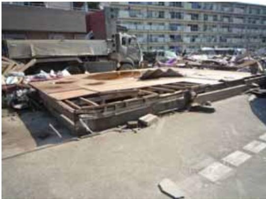
写真 3.1-13 土台を残し飛散した木造建築物
