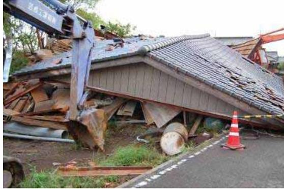
写真 4.2-2 上部構造の倒壊
