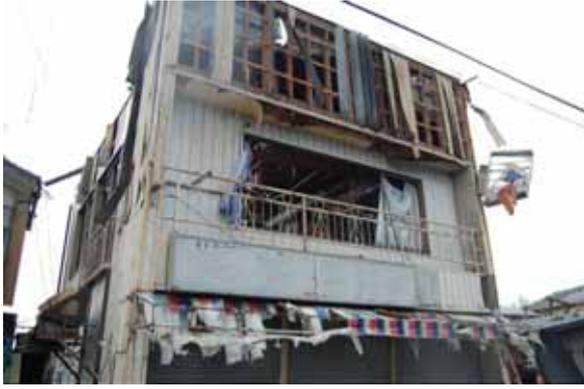
写真 3.4-15 外壁材の脱落
