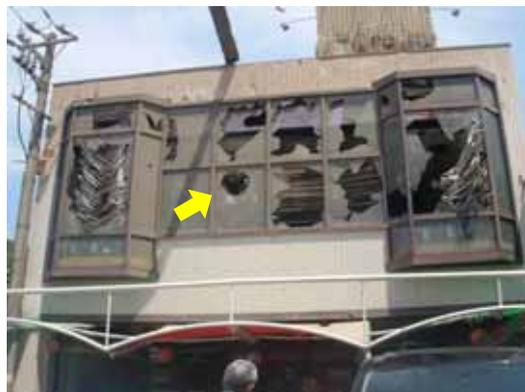
写真 3.4-22 店舗の窓ガラスの被害状況
