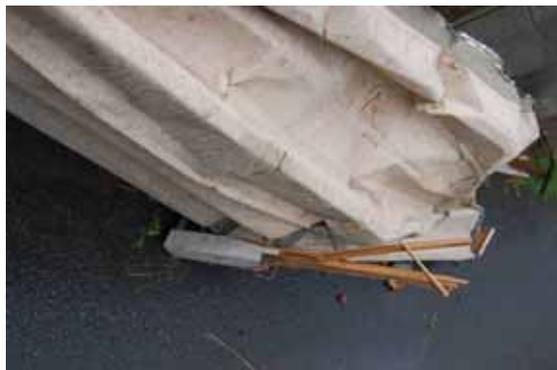
写真 3.4-8 飛散した折板屋根の状況
