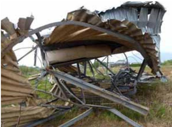
写真 3.2-2 鉄骨造建築物 A
