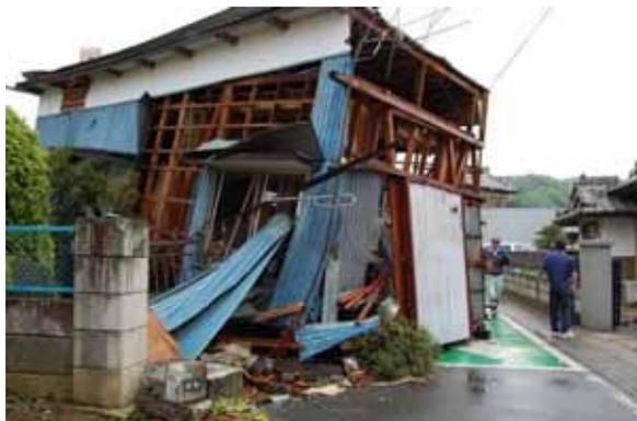
写真 3.1-30 移動した木造建築物の外観
