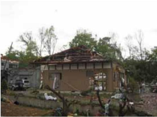
写真 3.1-34 寄棟屋根の被害
