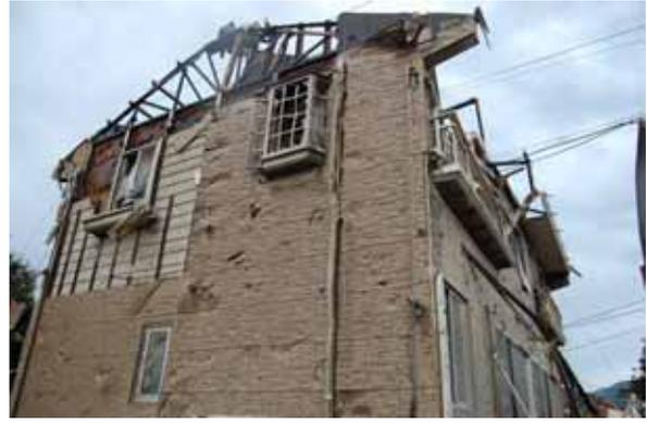
写真 3.4-16 軽量鉄骨造住宅の外壁材の脱落
