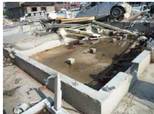
写真 4.2-4 上部構造の飛散
