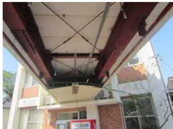
写真 3.4-20 渡り廊下底面の仕上げ材の脱落
