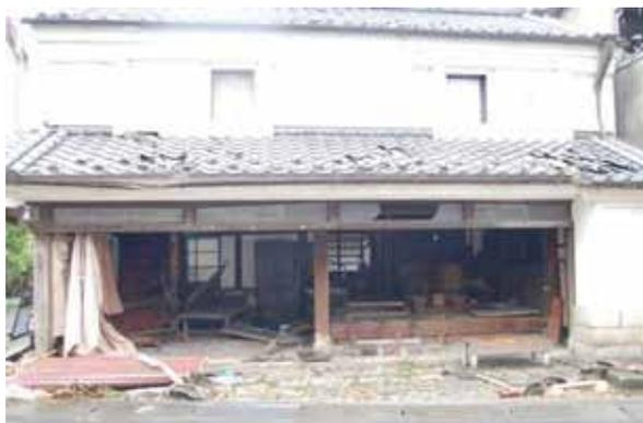
写真 3.4-23 店舗併用住宅の開口部の被害状況
