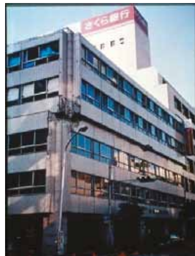
写真 5.5 中間層で崩壊した建築物（阪神・淡路大震災） 5-2)
