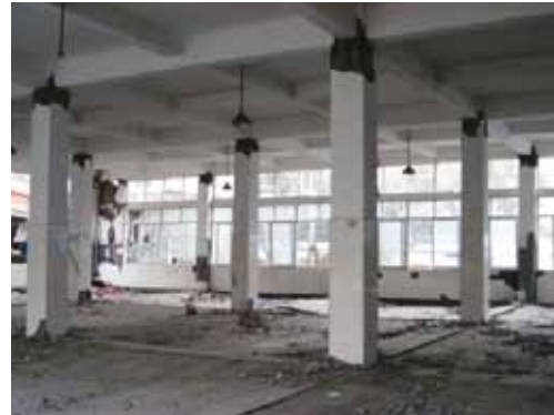
写真 5.19 柱頭の曲げ破壊 (四川大地震)
