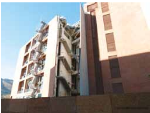
写真 5.34 外壁の脱落（写真 4.7.2 を再掲）
