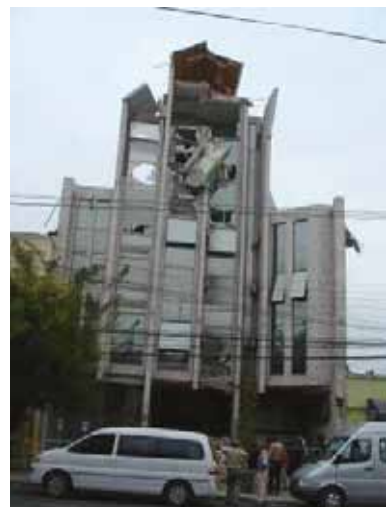
写真 5.35 外壁の脱落 （写真 4.19.1 を再掲）
