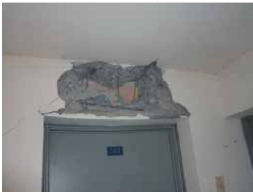
写真 5.20 せん断破壊した短スパン梁 (写真 4.20.3 を再掲)
