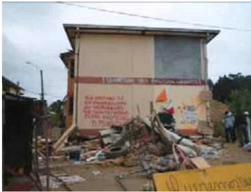
写真 4.14.3 1 層部分で層崩壊した建物
