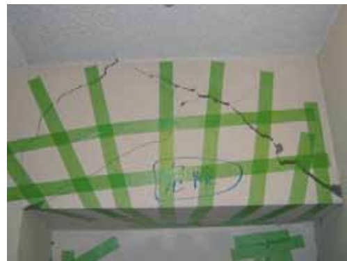
写真 5.21 せん断ひび割れが発生した 短スパン梁 (新潟県中越地震)
