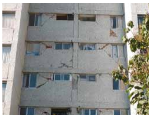
写真 4.5.2 れんが積み外壁の損傷
