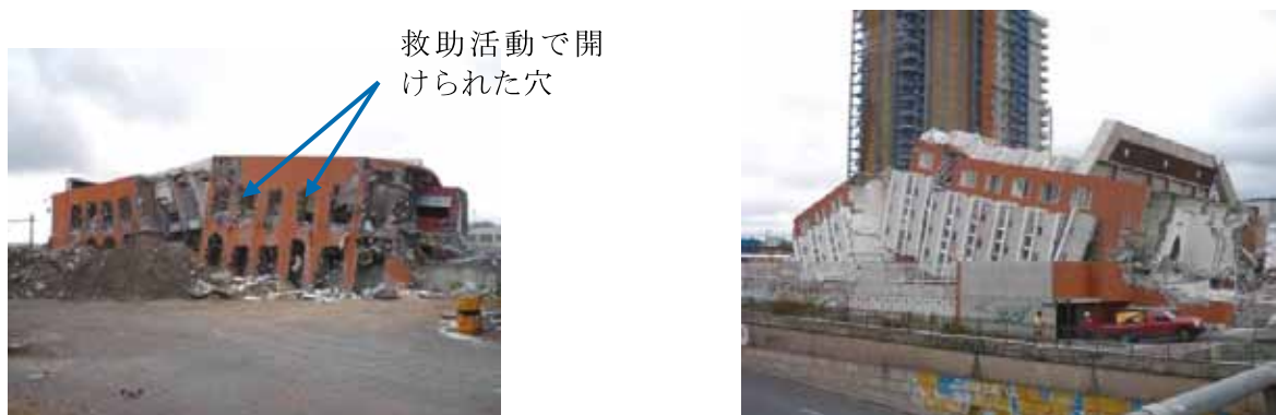
写真 5.1 転倒による被害（写真 4.25.2 を再掲）
