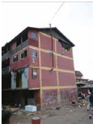
写真 4.15.3 妻壁頂部の梁の崩落
