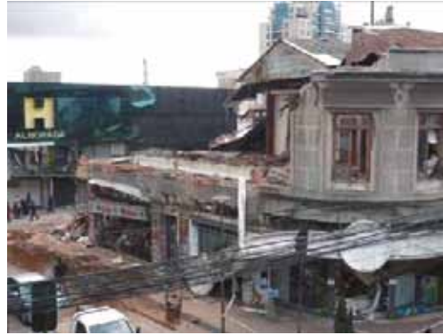
写真 5.13 れんが造建築物の被害（写真 4.22.1、写真 4.32.1 を再掲）
