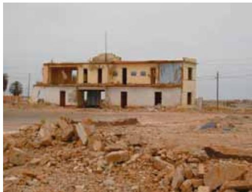
写真 5.11 崩壊したCM造建築物（ピスコ地震）
