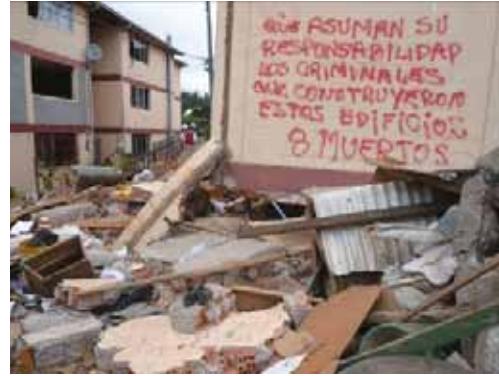
写真 5.10 1層部分で層崩壊したCM造（写真 4.14.3 を再掲）
