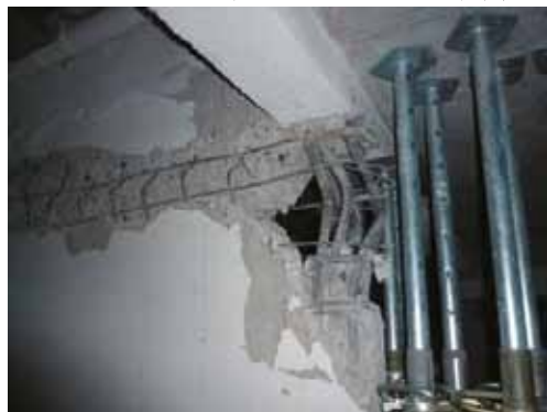
写真 5.17 大破した RC 造壁 （写真 4.2.3 を再掲）
