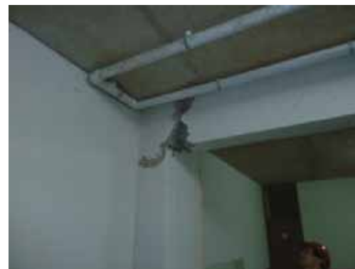
写真 4.4.4 写真 4.4.2 の地下部分
