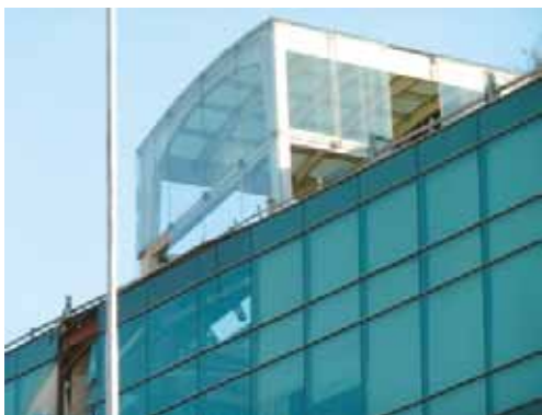
写真 4.7.4 ペントハウス階の落床と屋根非構造材の被害
