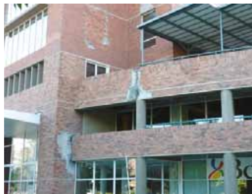
写真 4.6.2 壁梁の損傷
