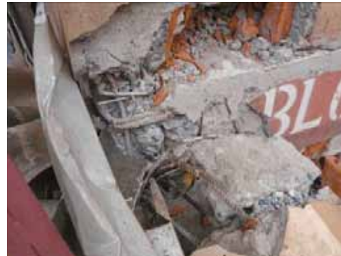
写真 5.25 柱梁接合部の破壊 (写真 4.14.4 を再掲)
