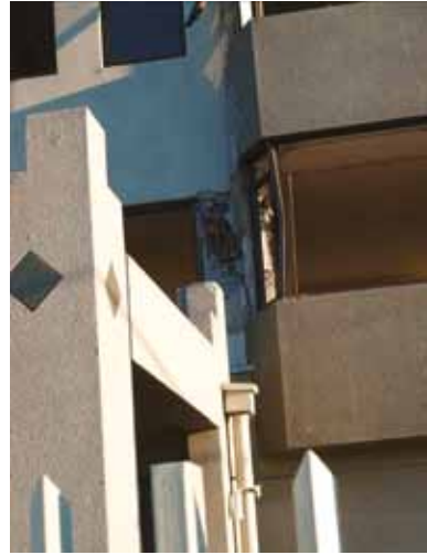
写真 4.30.2 外から確認できる損傷
