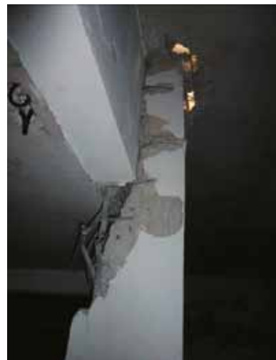
写真 4.2.4 RC 造柱の破壊
