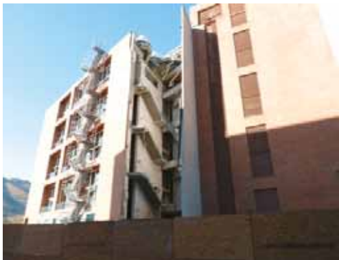
写真 4.7.2 外部階段壁の崩落、階段室鉄骨梁の落下
