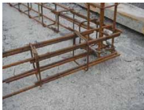
写真 4.18.2 基礎梁の配筋とコーナー鉄筋
