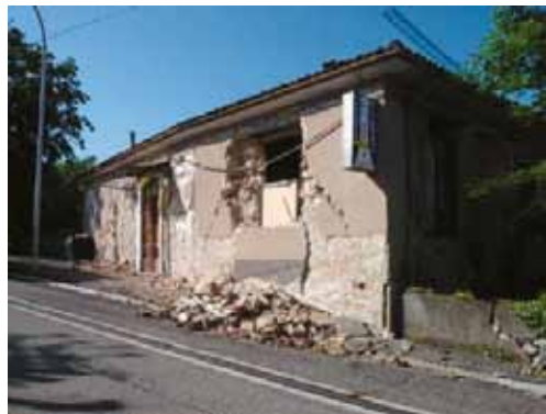
写真 5.15 組積造建築物の被害 （ラクイラ地震）
