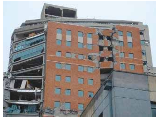
写真 5.4 層崩壊した 12 階付近（左は写真 4.23.3 を再掲）
