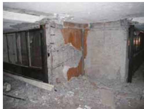
写真 4.26.4 2 階の壁の損傷
