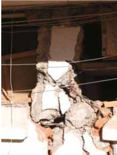
写真 4.28.3 短柱の被害
