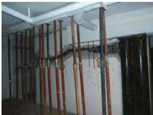
写真 5.16 大破した RC 造壁 （写真 4.1.2 を再掲）
