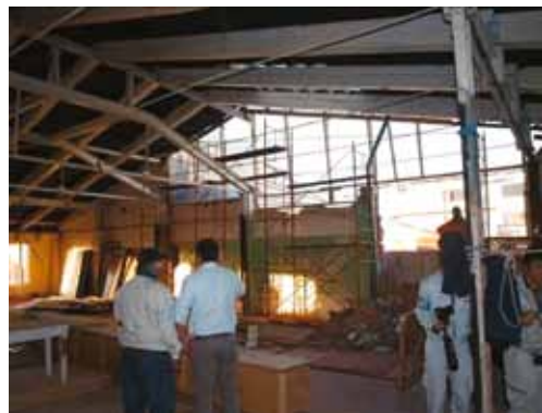
写真 4.31.2 撤去中のれんが壁
