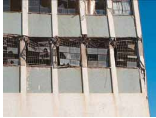
写真 4.36.4 建物右側の損傷
