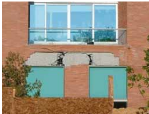
写真 4.7.3 梁と柱梁接合部の破壊
