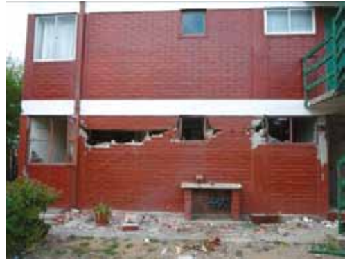
写真 4.17.2 大破した桁行方向壁
