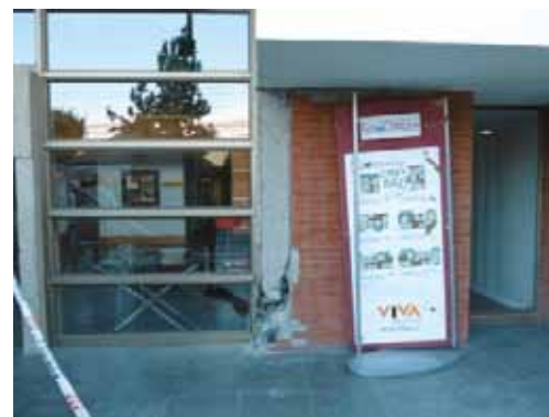
写真 4.4.2 1階柱脚の圧壊
