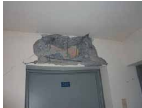
写真 4.20.3 せん断破壊した耐力壁と短スパン梁
