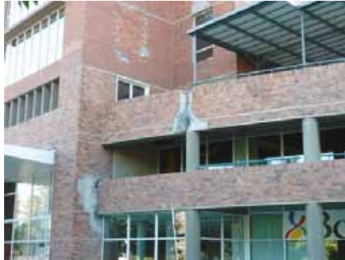
写真 5.28 2 棟の建築物の接続部分（写真 4.6.2 を再掲）
