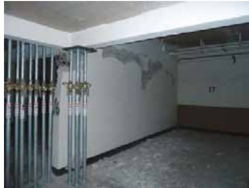
写真 4.2.2 大破した RC 造壁
