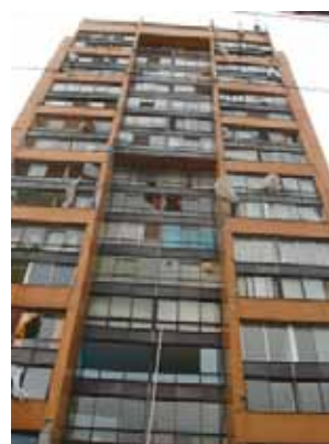
写真 5.37 窓ガラスの飛散
