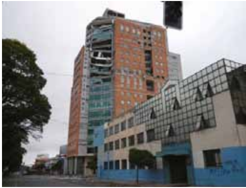
写真 5.3 中間層崩壊による被害（写真 4.23.2 を再掲）
