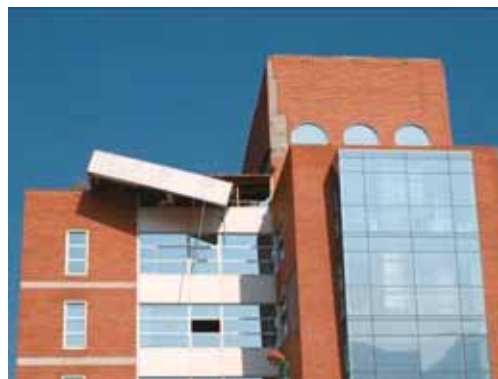
写真 4.7.4 ペントハウス階の落床と屋根非構造材の被害
