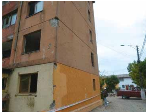
写真 4.21.3 隅柱の損傷
