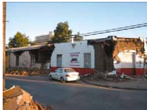
写真 5.12 アドベ造建築物の被害（写真 4.16.1、写真 4.22.1 を再掲）
