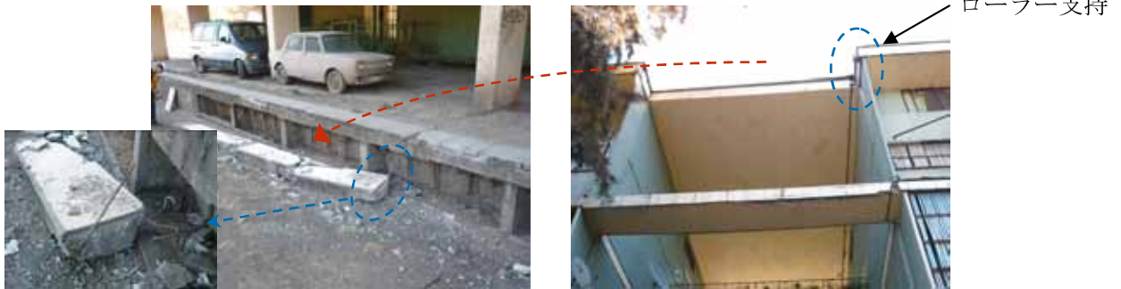
接続部の配筋状況
