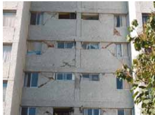
写真 5.30 れんが壁の破壊（写真 4.5.2 を再掲）
