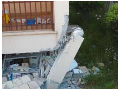
写真 5.27 柱梁接合部の破壊 (ラクイラ地震)
