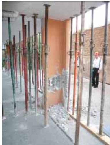
写真 4.10.2 T形壁柱と耐力壁の破壊
