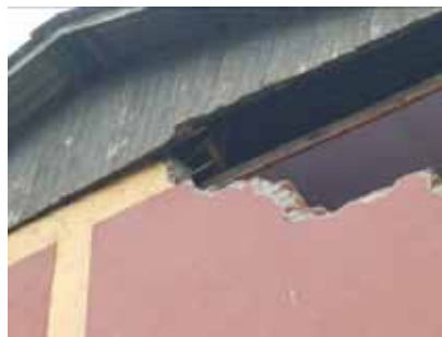
写真 4.15.3 妻壁頂部の梁の崩落
