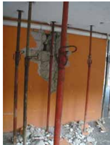
写真 4.10.2 T形壁柱と耐力壁の破壊
