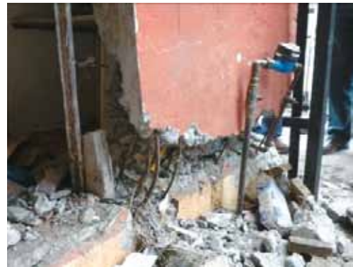
写真 4.15.2 妻壁のせん断破壊
