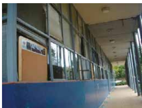
写真 5.36 窓ガラスの飛散(写真 4.20.2 を再掲)
