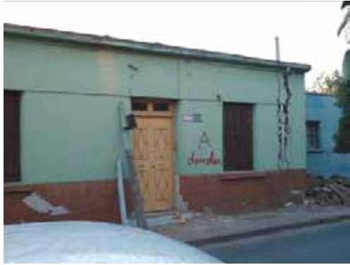
写真 5.13 れんが造建築物の被害（写真 4.22.1、写真 4.32.1 を再掲）
