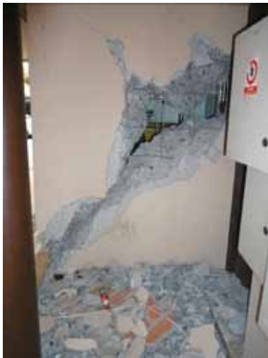
写真 4.20.3 せん断破壊した耐力壁と短スパン梁
