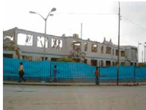
写真 5.11 崩壊したCM造建築物（ピスコ地震）
