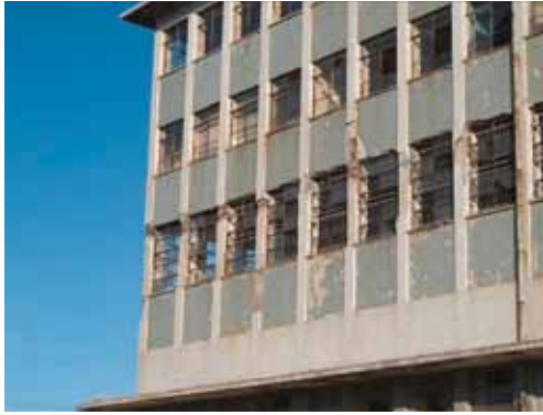
写真 4.36.3 建物左側の損傷
