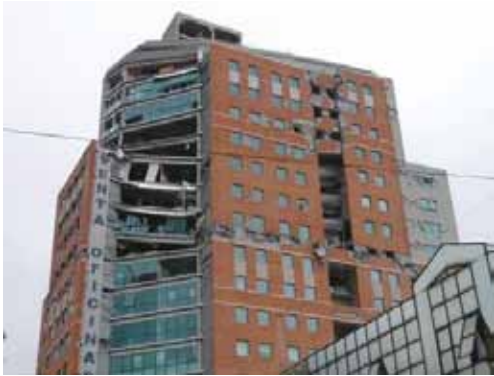
写真 5.4 層崩壊した 12 階付近（左は写真 4.23.3 を再掲）
