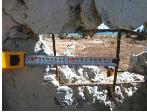
写真 4.33.2 プレキャスト RC 造壁
