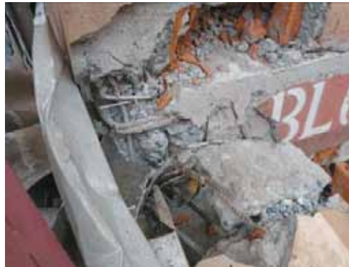
写真 4.14.4 柱梁接合部
