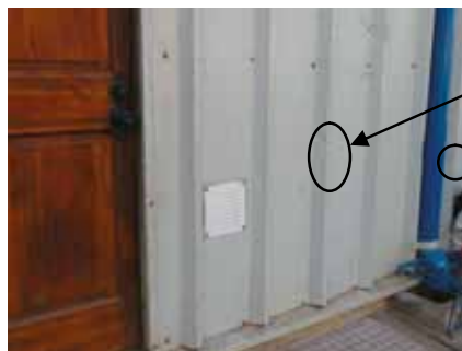
写真 4.35.2 折板の一部が変形
