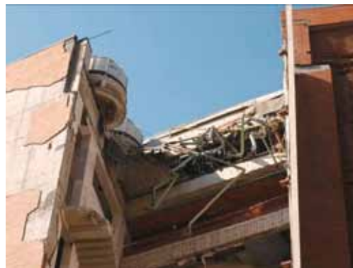
写真 4.7.2 外部階段壁の崩落、階段室鉄骨梁の落下
