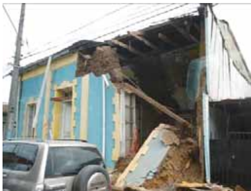
写真 5.12 アドベ造建築物の被害（写真 4.16.1、写真 4.22.1 を再掲）
