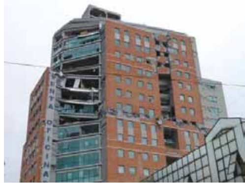
写真 4.23.3 層崩壊している 12 階付近
