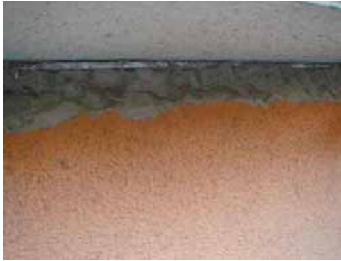
写真 4.10.3 壁上端の充填物
