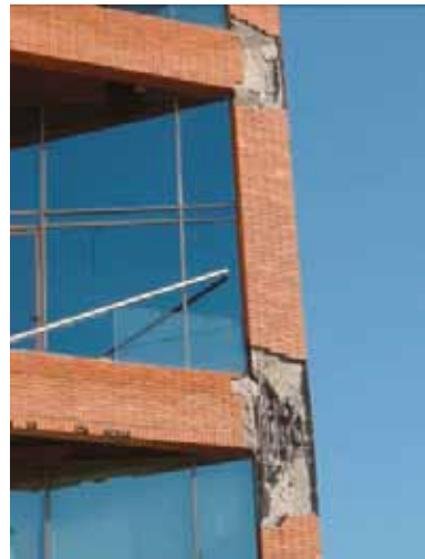
写真 4.7.3 梁と柱梁接合部の破壊
