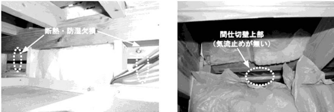
図3 壁の実況見分の事例
