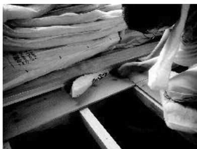
図7 床下への吹付け施工の様子
