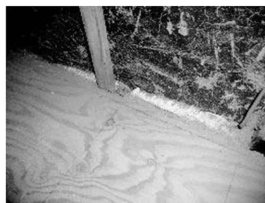
図8 床下から吹付けた断熱材が壁と床の隙間から床上に漏れ出した様子
