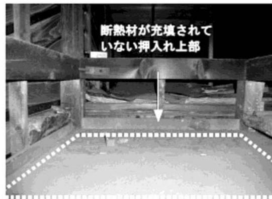
図5 押入れ上部の断熱欠損の例
