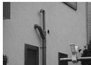
図5 換気設備用の外壁の貫通孔
