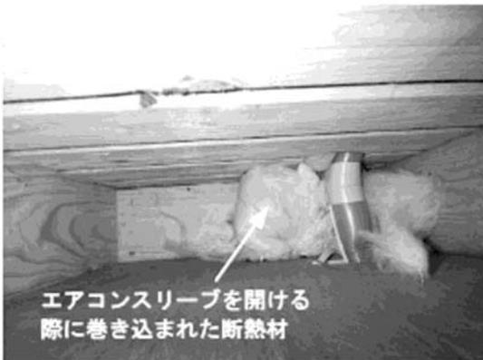
図4 エアコン設置工事の際に生じた断熱欠損の例
