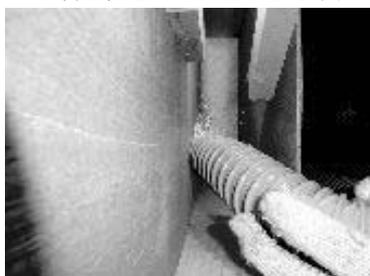
図 11 壁体内へ EPS を吹き込む様子
