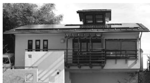
図4 竣工後に太陽光発電モジュールを設置した例
