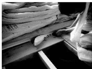
図 16 ●荒板と敷居の間に気流止めを充填
