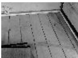
図 14 畳下地の荒板の隙間
