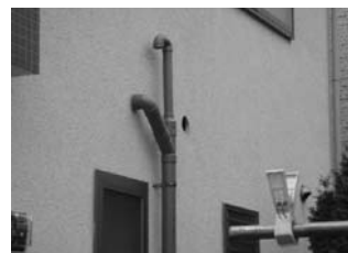
図5 換気設備用の外壁の貫通孔
